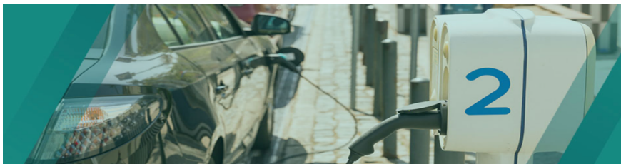
Εικόνα 4-10: Φόρτιση ηλεκτρικού αυτοκινήτου σε σταθμό δημόσιας φόρτισης[135]
