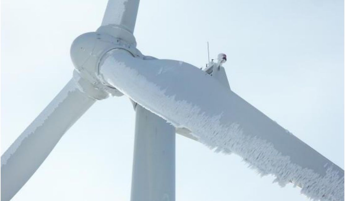
Εικόνα 19: Πτερύγια ανεμογεννήτριας με πάγο στην επιφάνεια τους ( http://www.ewea.org/ )
