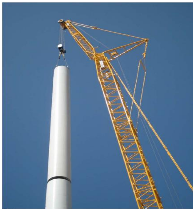
Εικόνα 14: Τοποθέτηση πύργου ανεμογεννήτριας ( http://www.cres.gr/cres/index.html )
