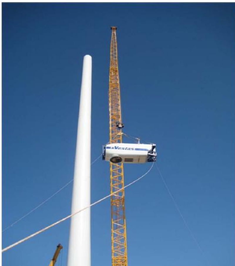
Εικόνα 5: Ανύψωση ατράκτου της ανεμογεννήτριας στον πύργο ( http://www.cres.gr/cres/index.html )
