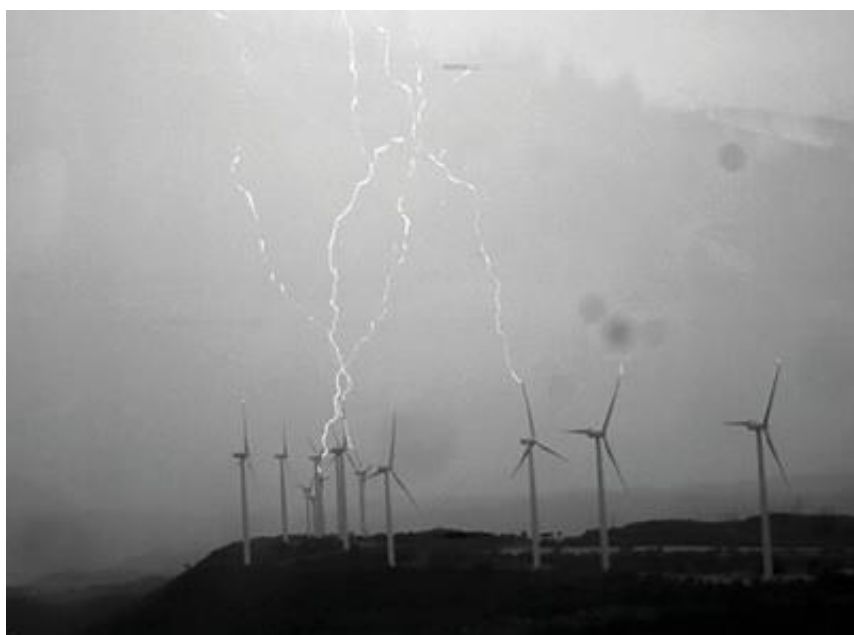
Εικόνα 21: Καταιγίδα σε αιολικό πάρκο ( https://www.agenciasinc.es/Noticias/El-movimiento-de-las-turbinas-eolicas-puede-generar-rayos )
