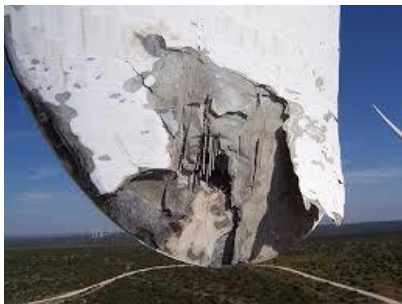
Εικόνα 22: Κατεστραμμένο πτερύγιο ανεμογεννήτριας από κεραυνό ( https://www.windpowerengineering.com/the-importance-of-testing-wind-turbine-lightning-protection/ )
