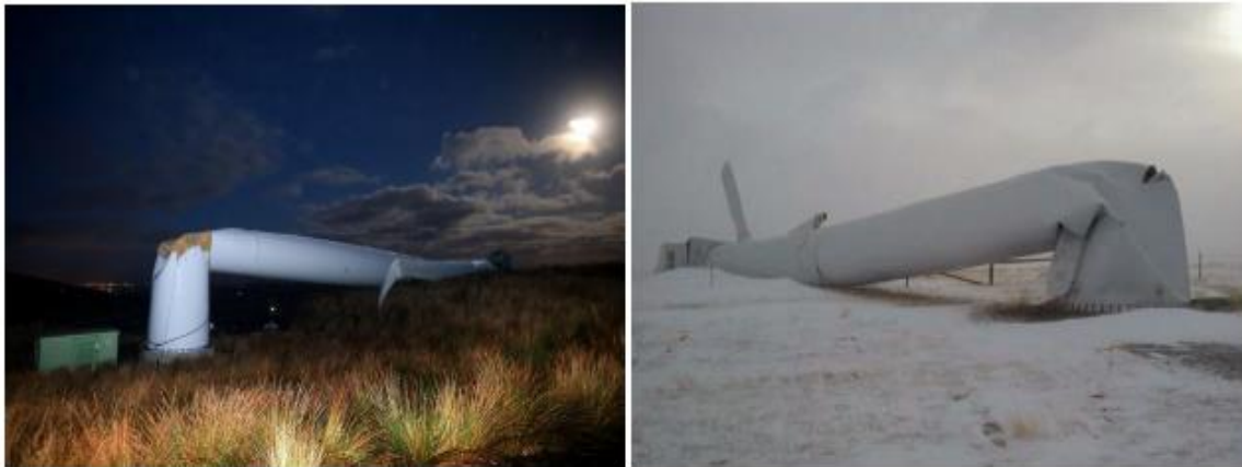
Εικόνα 29: Λυγισμός των πλώνων των ανεμογεννητριών ( https://www.independent.co.uk/news/uk/home-news/wind-turbine-crashes-ground-after-rotor-blades-spin-out-control-under-light-winds-a219426.html?amp )
