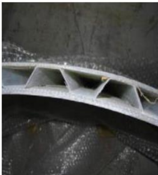
Εικόνα 15: Κατασκευή πύργου ανεμογεννήτριας από ινοπλισμένα πολυμερή υλικά ( http://oceanis.lib2.uniwa.gr/xmlui/bitstream/handle/123456789/5009/mech_43005.pdf?sequence=1&isAllowed=y )
