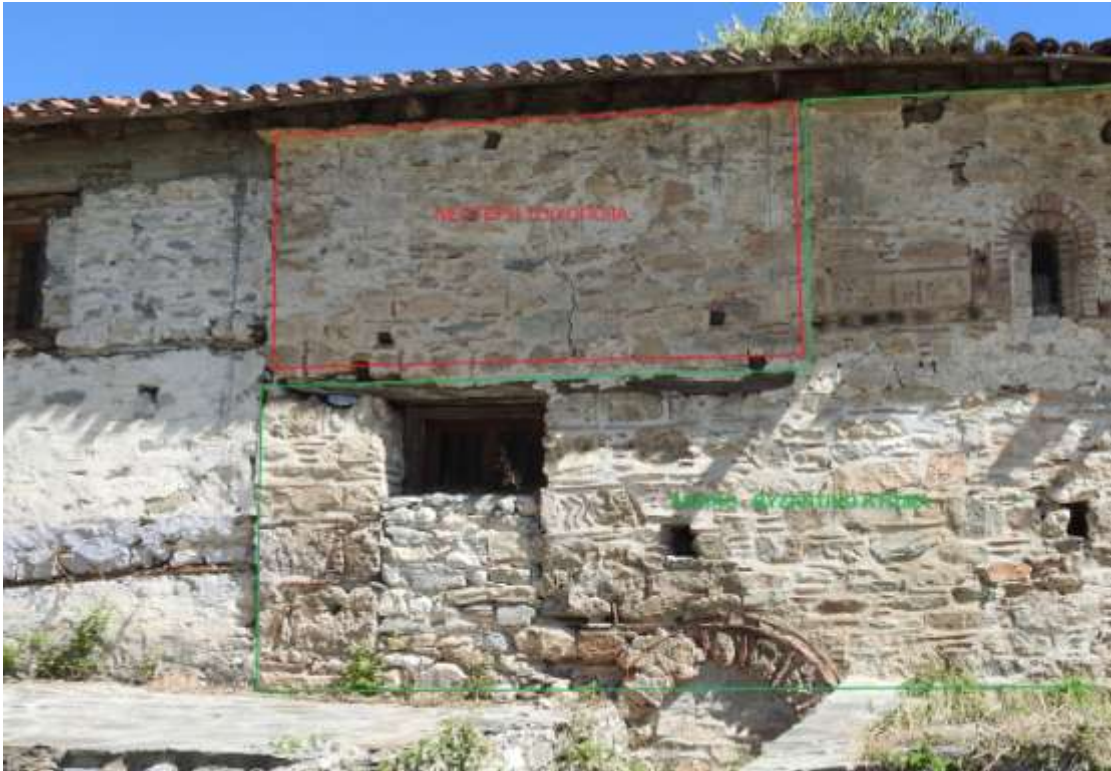
Εικ. 11 Νεότερη τοιχοποιία άνω της βυζαντινής τοιχοποιίας
