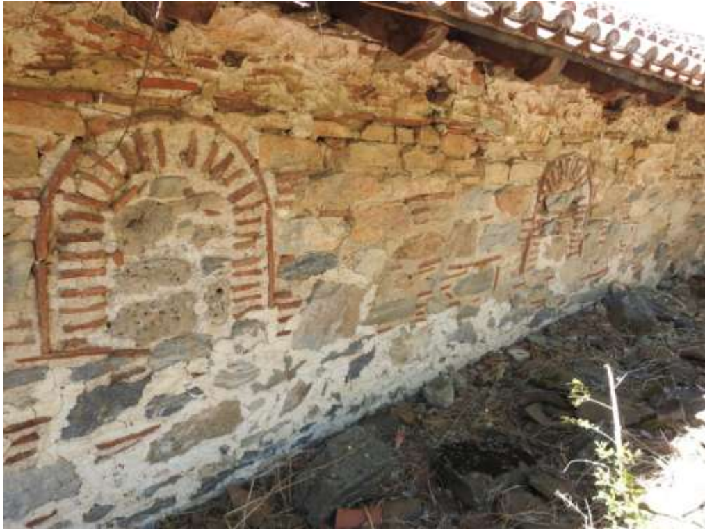
Εικ. 15 Διο σφραγιςμμένα μονόλοβα παράθυρα τής βόρειας πλευράς
