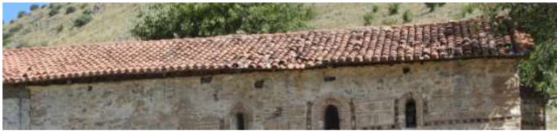
Εικ. 19 Στέγη με νεότερα βυζαντινά κεραμίδια
