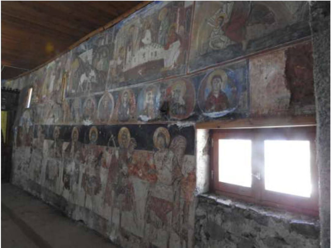
Εικ. 22 Νότιος τοίχος κυρίως ναού
