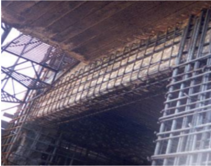
Εικόνα 4.9 Ενίσχυση δοκού με την χρήση μανδύα σκυροδέματος
