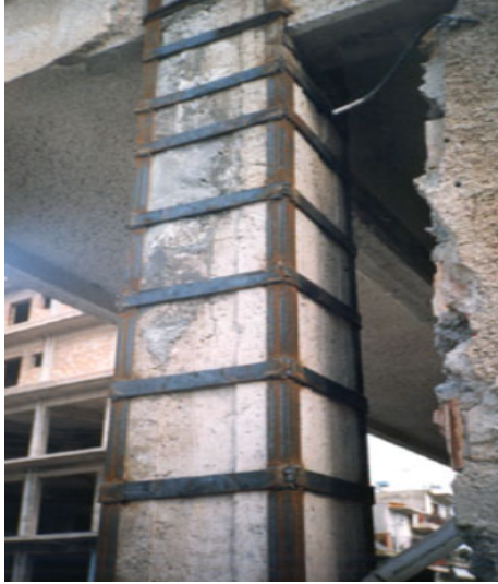
Εικόνα 4.11 Ενίσχυση υποστυλώματος με μεταλλικά ελάσματα
