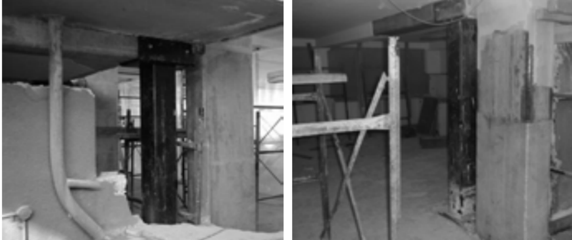
Εικόνα 4.4, Προσθήκη υποστυλώματος για την μείωση του ανοίγματος της δοκού, Σπυράκος
