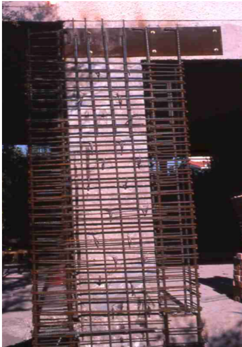
Εικόνα 4.10 Ενίσχυση υποστυλώματος με μανδύα οπλισμένου σκυροδέματος
