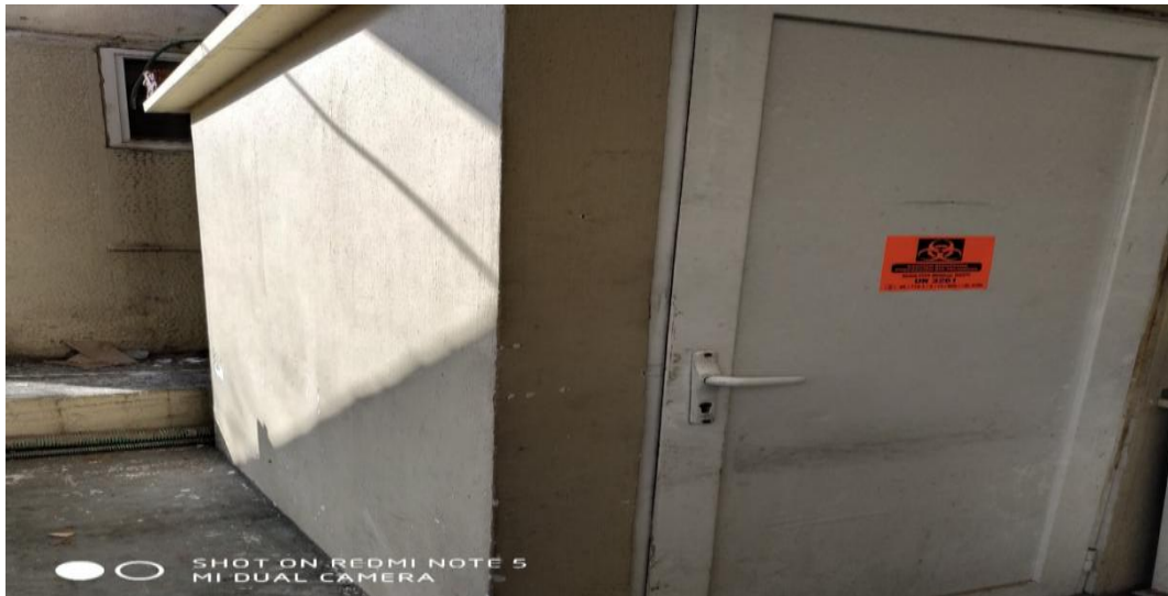
Εικόνα 4.11 Θάλαμος προσωρινής αποθήκευσης ΑΕΑ - Πηγή: ΕΚΔΑΥΜ ΓΝΑ «ΑΛΕΞΑΝΔΡΑ»
