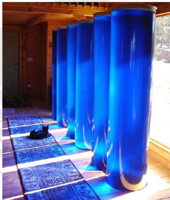
Εικόνα 3.8 Ηλιακός Τοίχος Νερού ( πηγή: Πτυχιακή εργασία με θέμα «ΕΞΟΙΚΟΝΟΜΗΣΗ ΕΝΕΡΓΕΙΑΣ ΣΤΑ ΚΤΙΡΙΑ ΜΕΣΩ ΠΑΘΗΤΙΚΩΝ ΗΛΙΑΚΩΝ ΣΥΣΤΗΜΑΤΩΝ», Μελέτη: ΣΟΦΙ ΕΝΕΑ, Εισηγητής-Επιβλέπων :Σταυρίδου Αναστασία, Καβάλα, 2013, σελίδα 57 )
