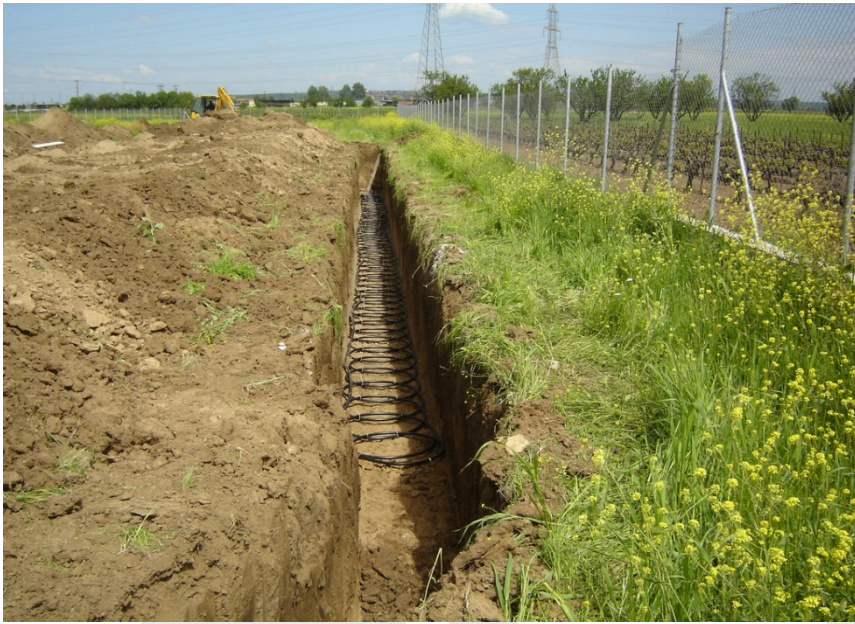
Εικόνα 3.34 Οριζόντιο κλειστό γεωθερμικό σύστημα ( πηγή: https://www.eneroots.gr/ )
