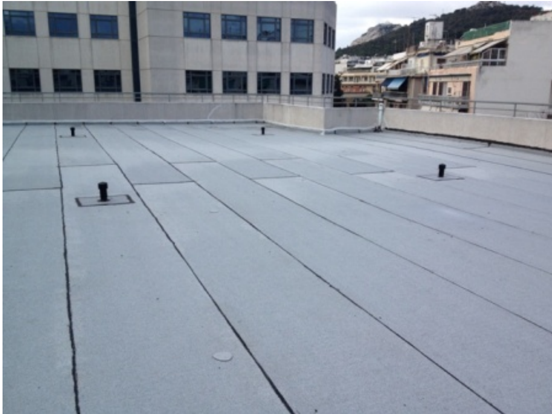
Εικόνα 3.32 Στεγανοποίηση με ασφαλτόπανα ( πηγή: www.monodomiki.gr )
