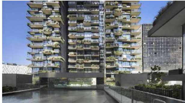
Εικόνα 6.6 Εξωτερική λεπτομερής πρόσοψη του One Central Park. ©www.jeannouvel.com
