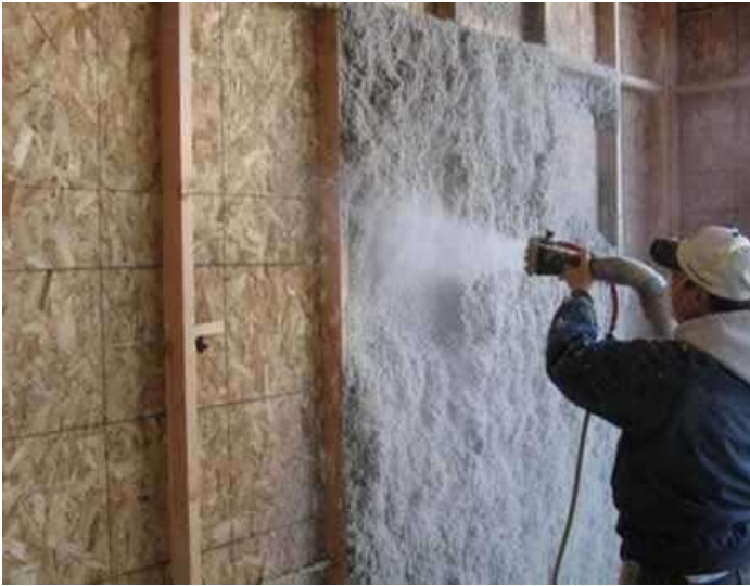
Εικόνα 5.17 Τοποθέτηση κυτταρίνης
