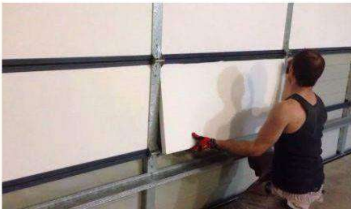
Εικόνα 5.19 Τοποθέτηση αφρολέξ πολυστερίνης
