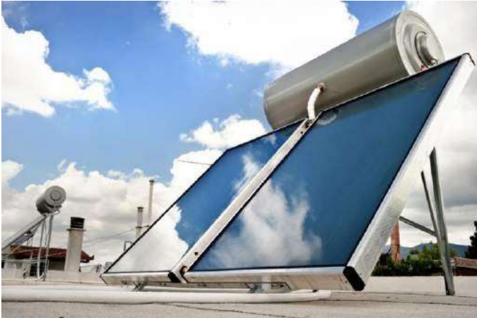
Εικόνα 4.6 Ηλιακός θερμοσίφοντας
