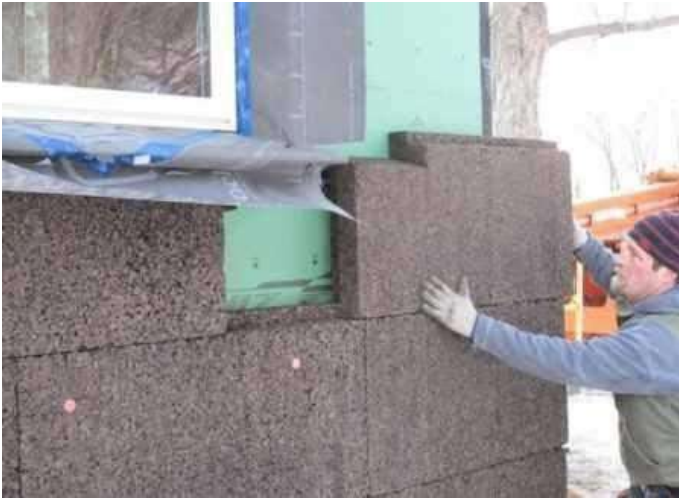
Εικόνα 5.18 Τοποθέτηση φελλού ως μονωτικό υλικό
