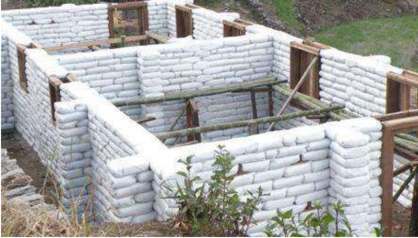
Εικόνα 5.8 Τοίχοι από χωμάτινες τσάντες
