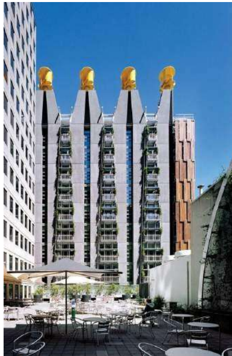
Εικόνα 6.2 Όψη του Council House 2. ©www.archdaily.com
