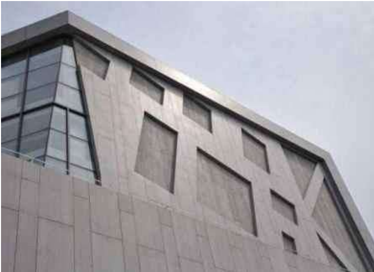
Εικόνα 5.23 Εξωτερική όψη κτιρίου με τσιμεντένιες ίνες
