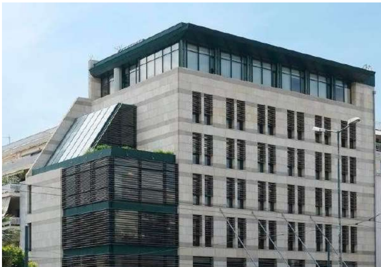
Εικόνα 6.14 Κτίριο Γραφείων – Βασιλίσσης Σοφίας
