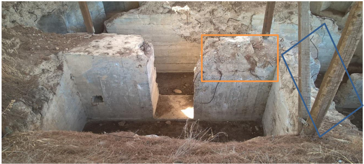
Εικόνα 16 Υπόγειες εγκαταστάσεις τμήματος αντιαεροπορικού πολυβολείου 88 mm στη νοτιοανατολική πλευρά του Λόφου Οχυρού. Διακρίνεται το τμήμα της εξωτερικής τοιχοποιίας (πορτοκαλί χρώμα) και ο εσωτερικός τοίχος (μπλε χρώμα).
