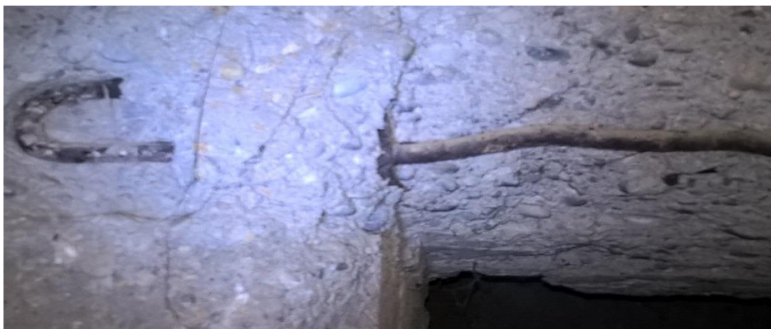
Εικόνα 27 Αγκύρωση κυρίως οπλισμού της εικόνας 17.
