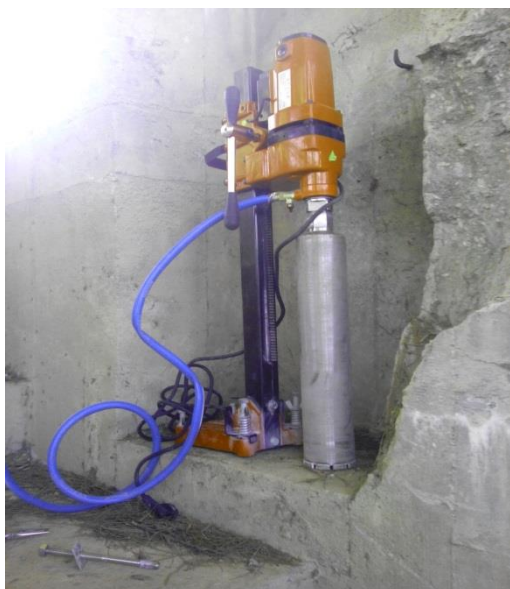
Εικόνα 19 Καροτιέρα BULLECDC-150.
