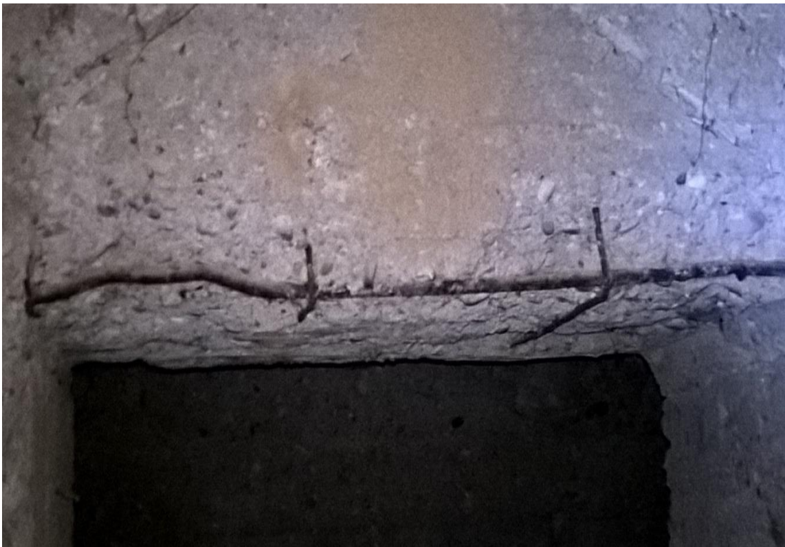
Εικόνα 26 Κύριος οπλισμός Φ16 και δευτερεύων οπλισμός Φ8 δεμένοι με συνδετήρες
