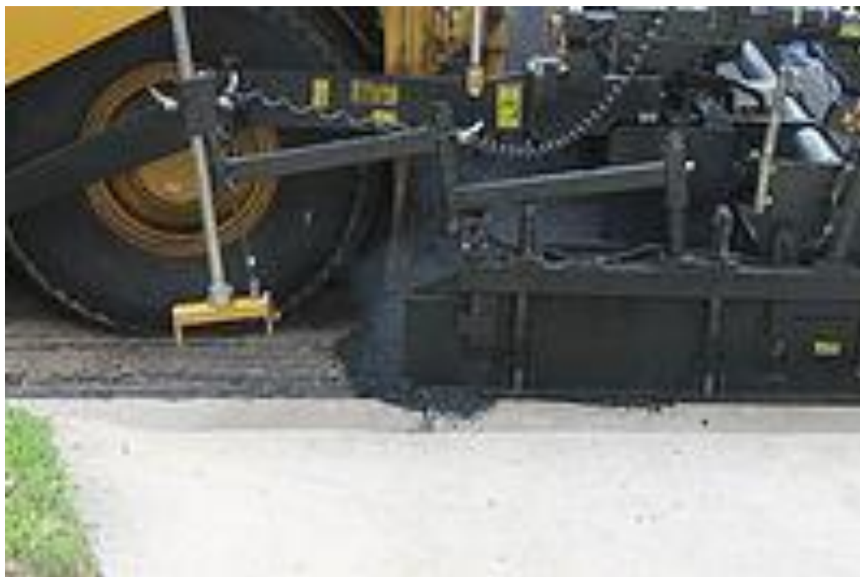
Εικόνα 4.18 Μηχανή τοποθέτησης ασφάλτου σκυροδέματος σε λειτουργία στο Laredo του Τέξας
