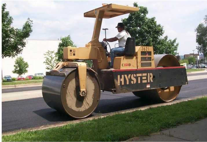
Εικόνα 4.16 Πάτημα νέας ασφάλτου με οδόστρωμα
