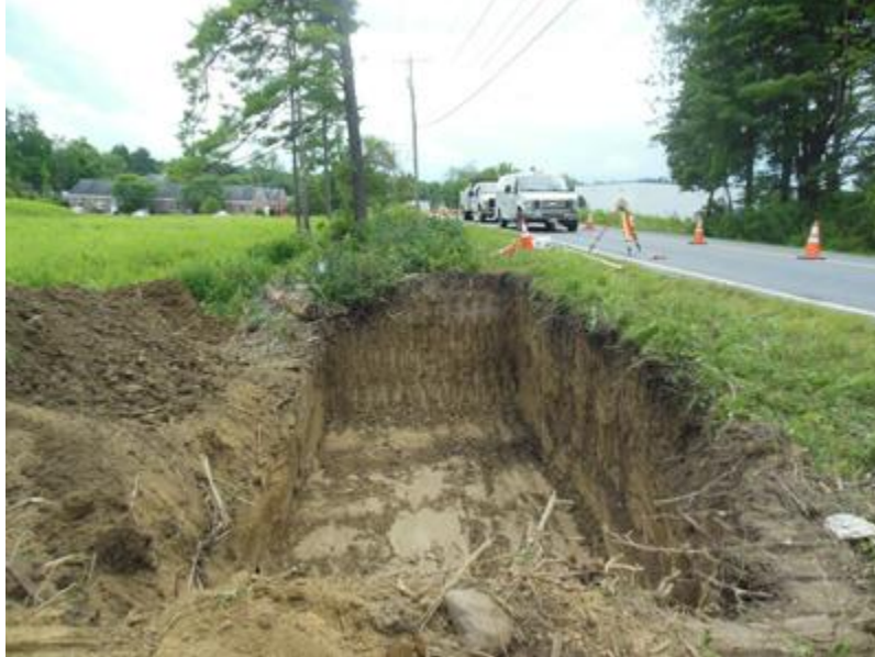
Εικόνα 1.3 Χώματα εκσκαφών Πηγή: Jarred O'dell (2016)
