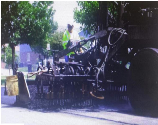
Εικόνα 4.13 Μηχάνημα με ασάλινα δόντια και υδραυλικά ελατήρια
