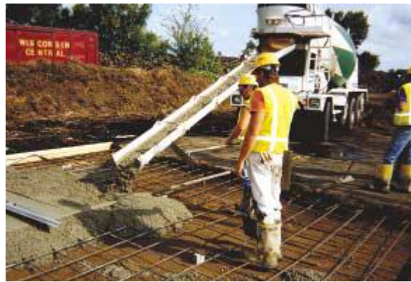
Εικόνα 8.2 Εργάτες έτοιμοι να τοποθετήσουν φρέσκο σκυρόδεμα ξύλινης τέφρας δομικής ποιότητας
