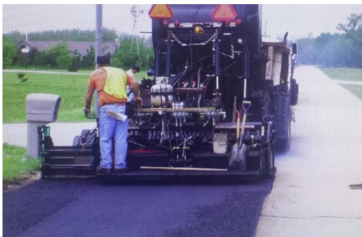
Εικόνα 4.15 Κατανομή και επαναδιάστρωση νέου ασφαλτομίγματος.
