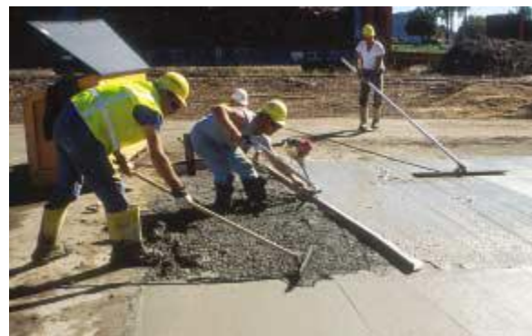
Εικόνα 8.3 Ολοκλήρωση της πλάκας επίδειξης σκυροδέματος δομικής ποιότητας ενσωματώνει τέφρα ξύλου, τοποθετήθηκε το 2001
