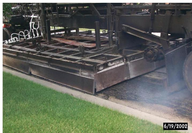
Εικόνα 4.11 Προθερμαντήρας οδοστρώματος (140-150°C)
