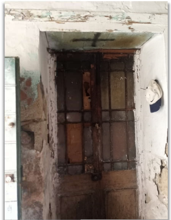
Εικόνα 3.4: Εσωτερική πόρτα που έχει καταργηθεί
