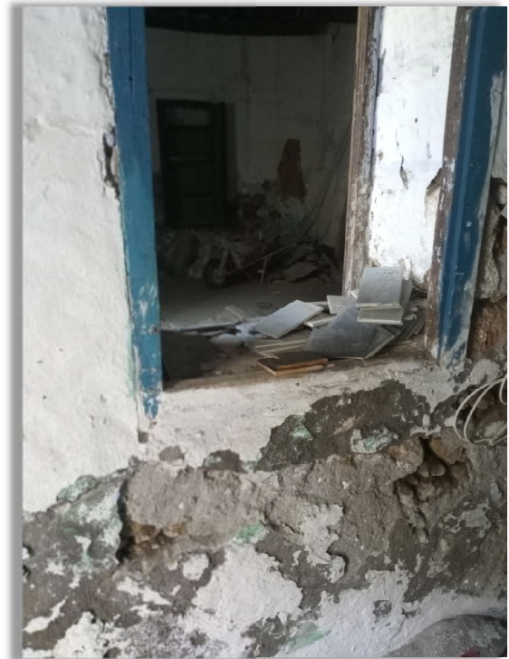
Εικόνα 3.21: Αποσάρθρωση συνδετικού υλικού
