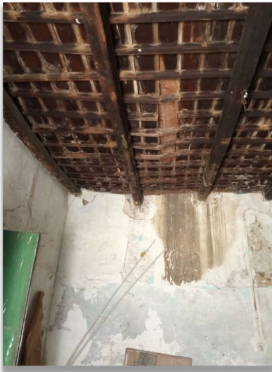
Εικόνα 3.20: Εμφάνιση υγρασίας
