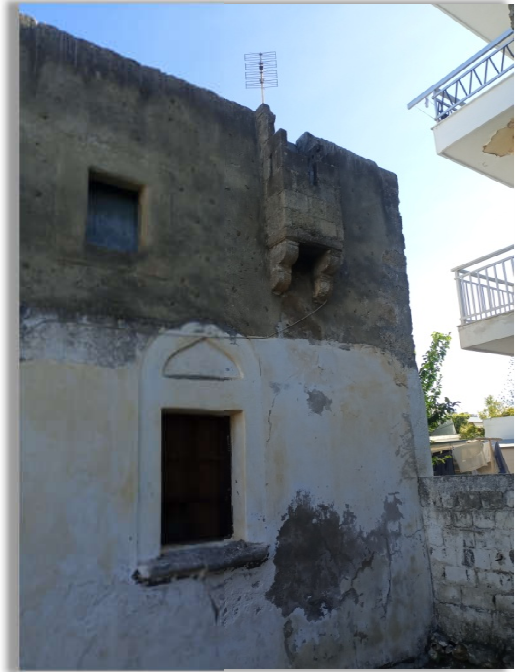
Εικόνα 3.22: Αποκόλληση επιχρισμάτων
