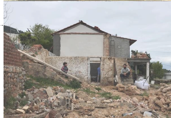
Εικ. 18 εργασίες αποκατάστασης
