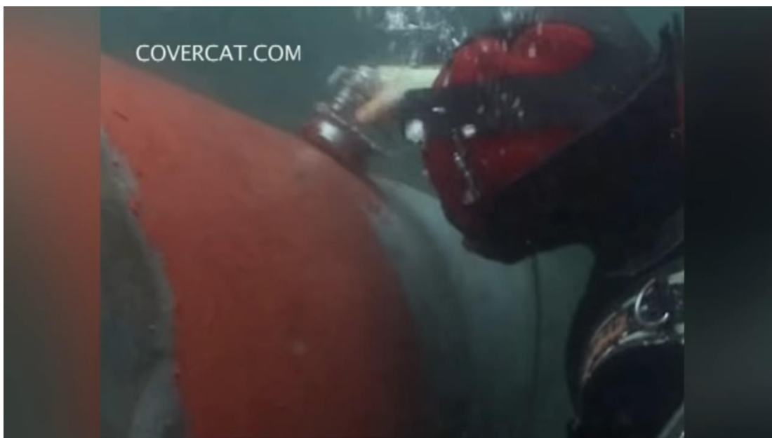
Εικόνα 14. Υποθαλάσσια εφαρμογή βαφής
