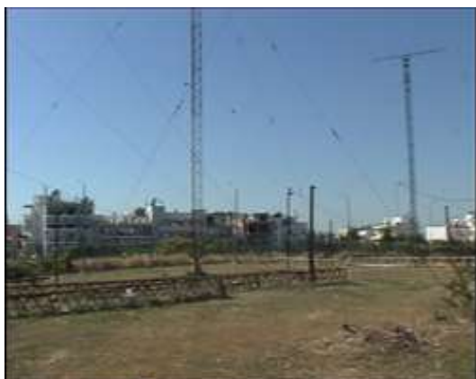
Εικ.40: Χώρος Ασυρμάτου γεμάτος με ανενεργές κεραίες
