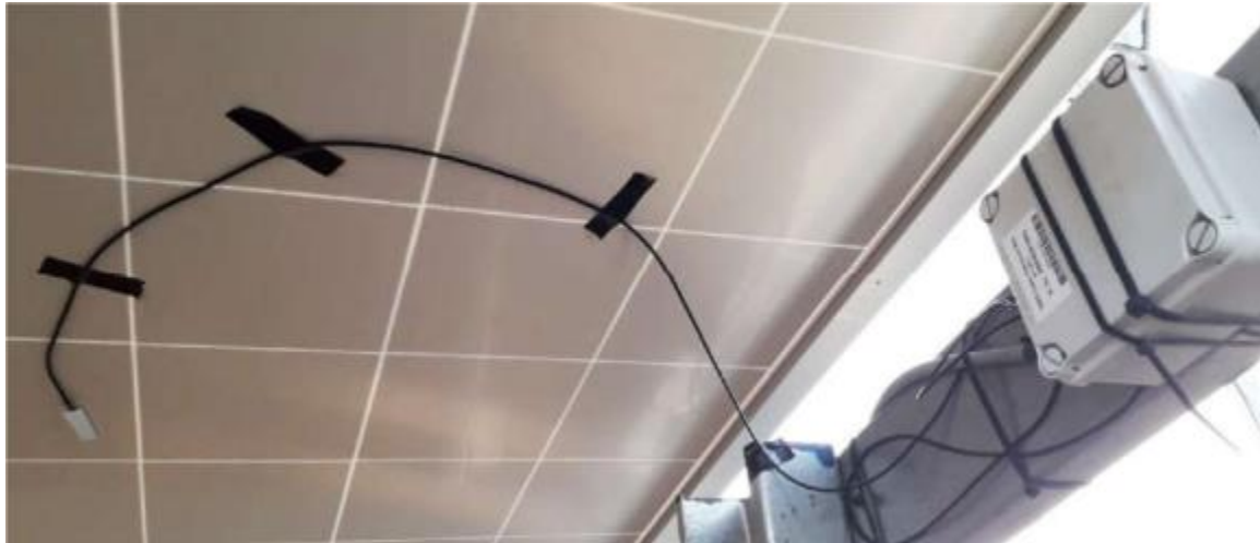
Εικόνα 23. Εγκατάσταση αισθητήρα θερμοκρασίας πλαισίου Πηγή: www.imt-solar.com/products/temperature-sensor/module-temperature
