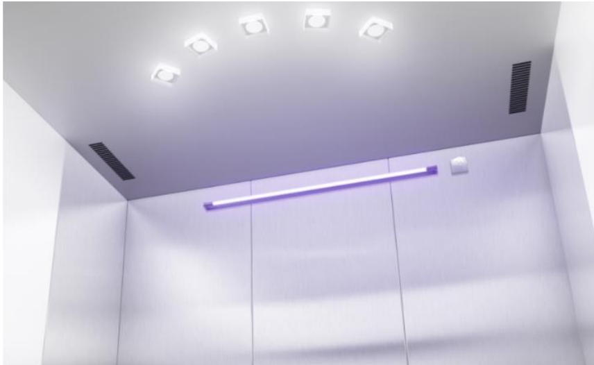
Εικόνα 31-Τοποθέτηση λαμπών UV
