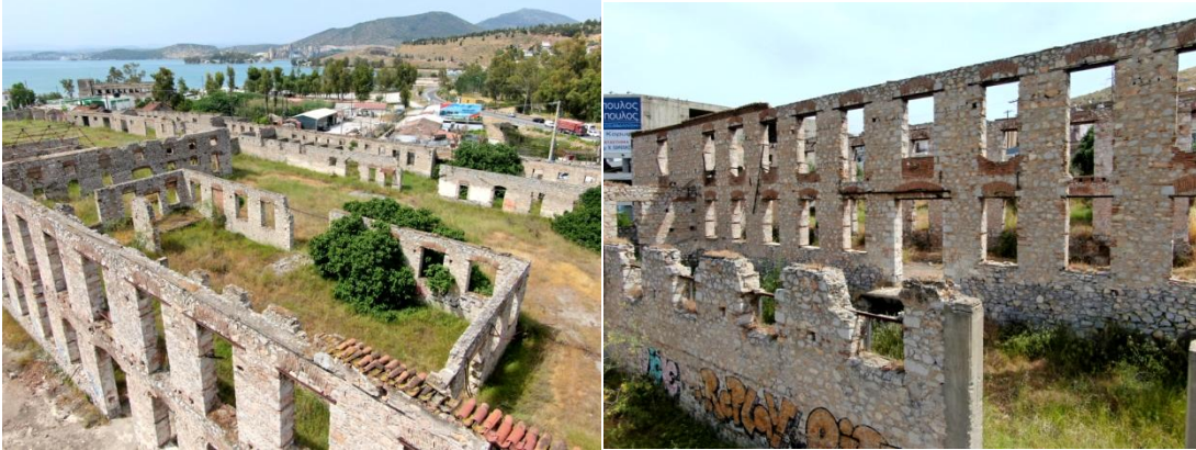
2.2 Τα ανοίγματα κατά μήκος των κτιριακών εγκαταστάσεων του εργοστασίου Β. Γεωργιάδη,(2020), Χαλκίδα, Εύβοια. ©Φωτογραφίες: Αλέξανδρος Καντανολέων
