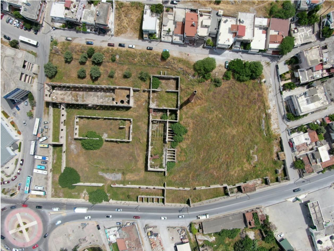
3.1 Κατοπική εναέρια λήψη του συγκροτήματος Β. Γεωργιάδη. Στο κέντρο του οικοπέδου το κτίριο το οποίο κρίθηκε διατηρητέο μαζί με το φουγάρο, (2020), Χαλκίδα, Εύβοια. ©Φωτογραφία: Αλέξανδρος Καντανολέων
