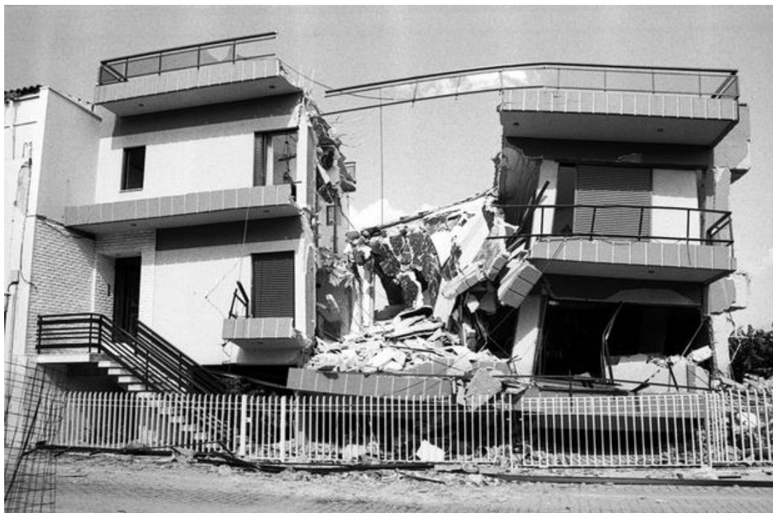
Εικόνα 3. Μερική κατάρρευση κτιρίου από τον σεισμό της Πάρνηθας το 1999. Πηγή: Σπύρος Στάβερης
