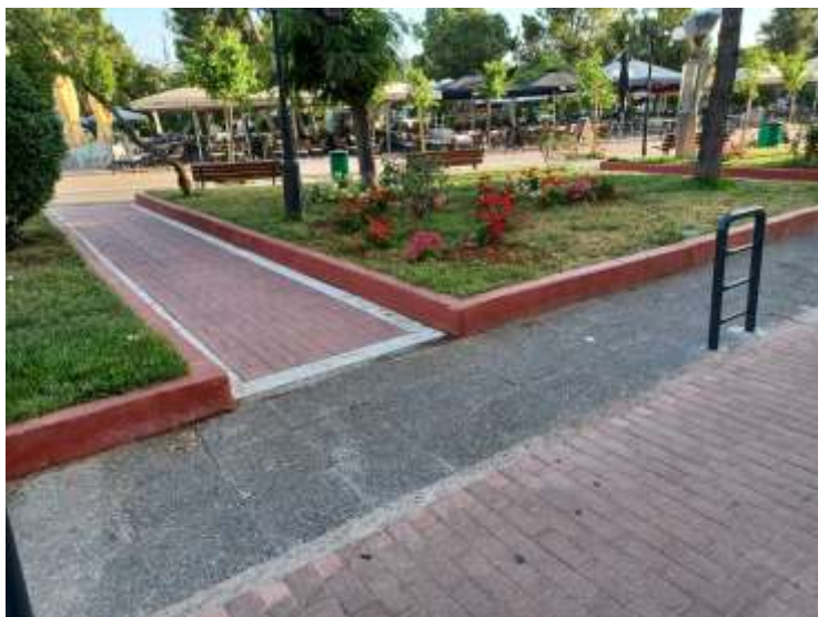
Εικόνα 8.26: Αύξηση πλάτους διέλευσης και απαγόρευση στάθμευσης.
