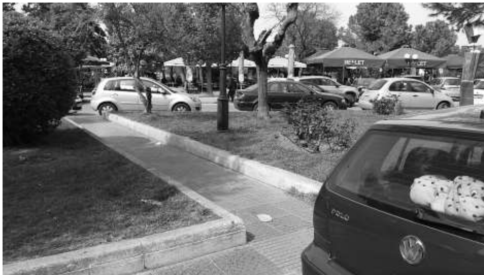
Εικόνα 8.25: Μικρό πλάτος διέλευσης που καταλήγει σε σταθμευμένο όχημα Πηγή: (Αρχείο Δ/σης Τεχνικών Υπηρεσιών Δήμου Αγίας Παρασκευής, 2022)
