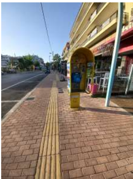
Εικόνα 5.5: Όδευση τυφλού στην οδό Ηρώων Πολυτεχνείου στο Δήμο Αγίας Παρασκευής .
