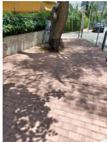
Εικόνα 8.41: Σημειακές διαπλατύνσεις πεζοδρομίων για τη διατήρηση των δέντρων
