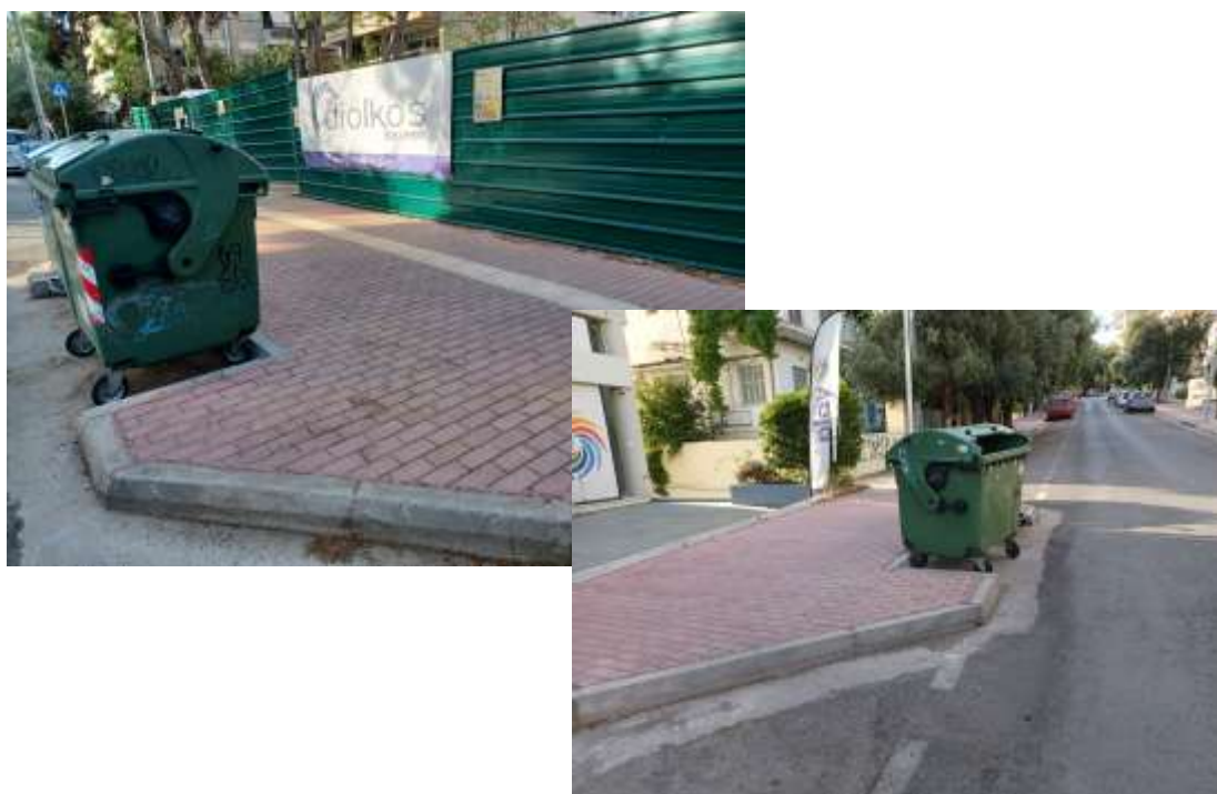
Εικόνα 8.37: Διαπλάτυνση πεζοδρομίων και χωροθέτηση κάδων σε εσοχή
