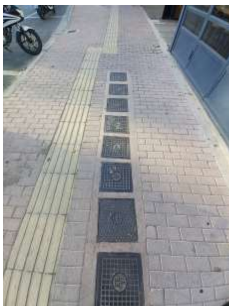
Εικόνα 8.33: Ανακατασκευή πεζοδρομίων με κυβόλιθο, όδευση τυφλών και φωτιστικά σώματα led
