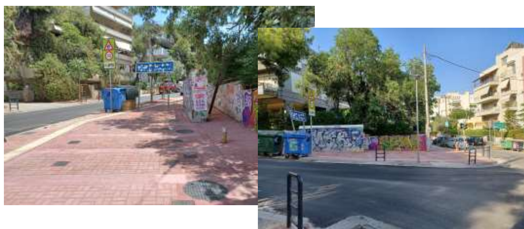
Εικόνα 8.43: Διαμόρφωση πεζοδρομίου, διάβασης, ράμπας ΑΜΕΑ και όδευση τυφλού.
