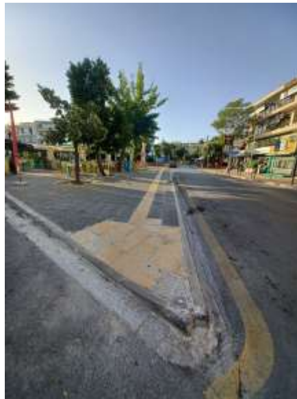
Εικόνα 8.22: Δημιουργία ράμπας ΑΜΕΑ και διαπλάτυνση πεζοδρομίων.
