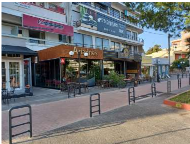
Εικόνα 8.14: Πεζοδρόμια οδού Ε. Γιαβάση μετά την παρέμβαση.
