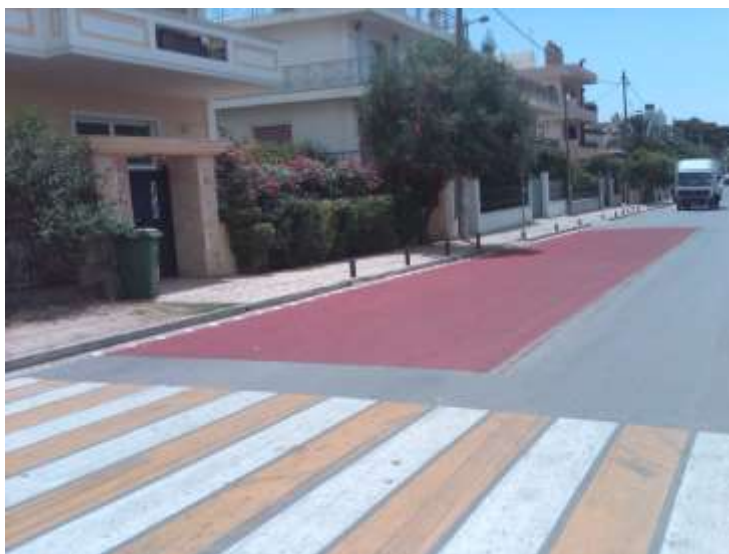
Εικόνα 4.9: Έντονες χρωματικές αλλαγές για την προειδοποίηση ύπαρξης διάβασης πεζών στο Δήμο Κηφισιάς.
