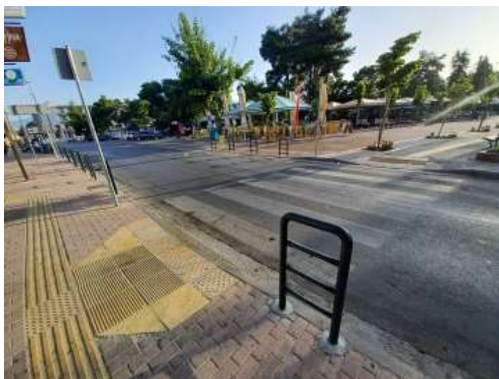
Εικόνα 8.20: Δημιουργία ράμπας ΑΜΕΑ και διάβασης πεζών.
