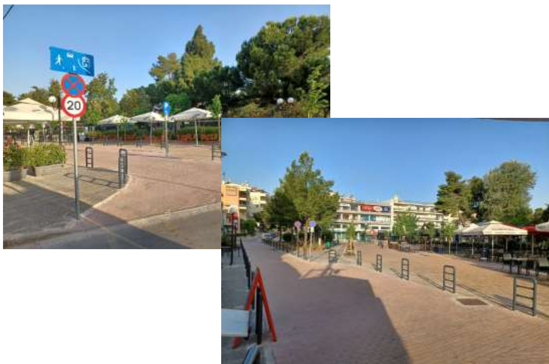
Εικόνα 8.8: Η οδός Ε. Γιαβάση, σε οδό ήπιας κυκλοφορίας.
