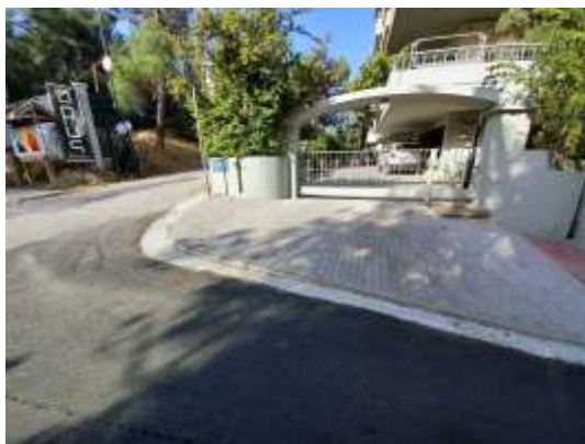
Εικόνα 8.56: Σημειακή διαπλάτυνση πεζοδρομίου, όδευση τυφλού, ράμπα ΑΜΕΑ, υποβιβασμός πεζοδρομίου στο σημείο εισόδου- εξόδου ιδιωτικής θέσης στάθμευσης.
