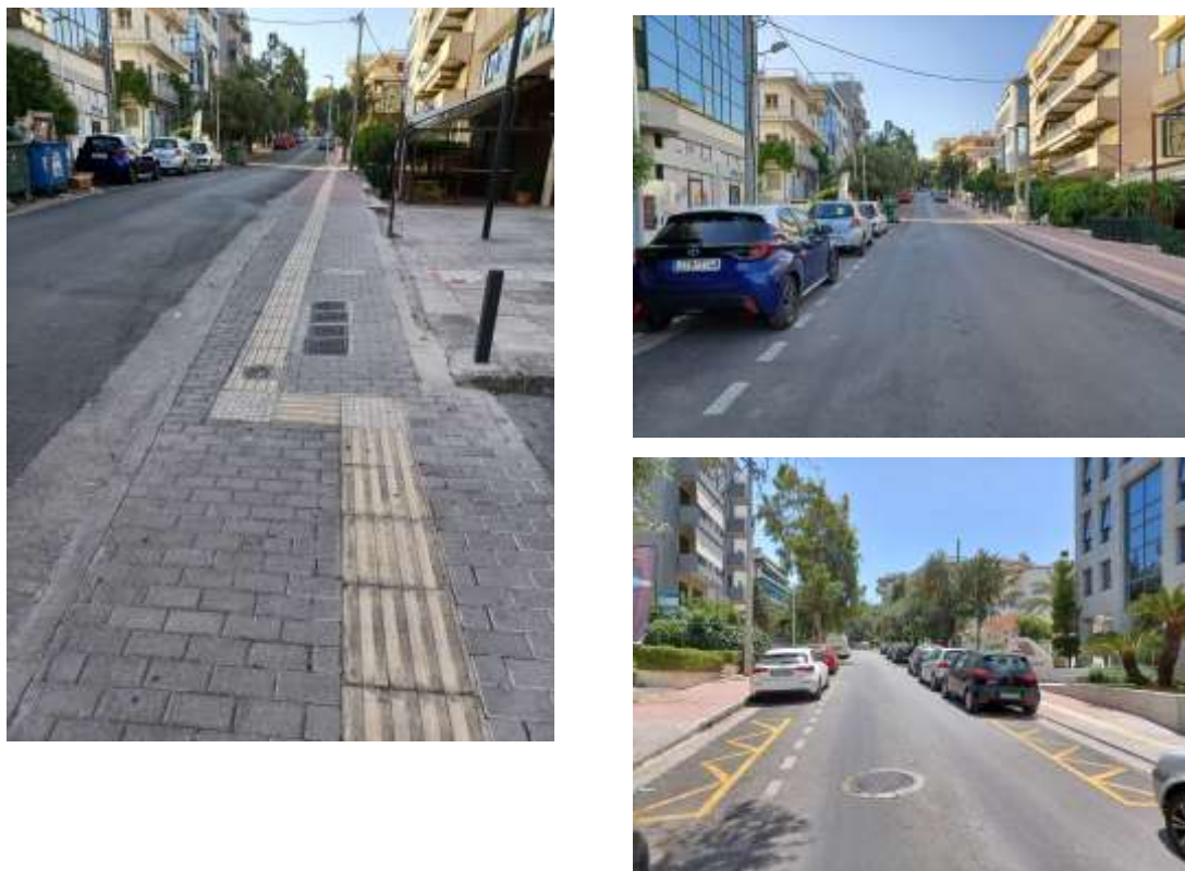
Εικόνα 8.35: Πλήρη ανακατασκευή της οδού Αιγαίου Πελάγους
