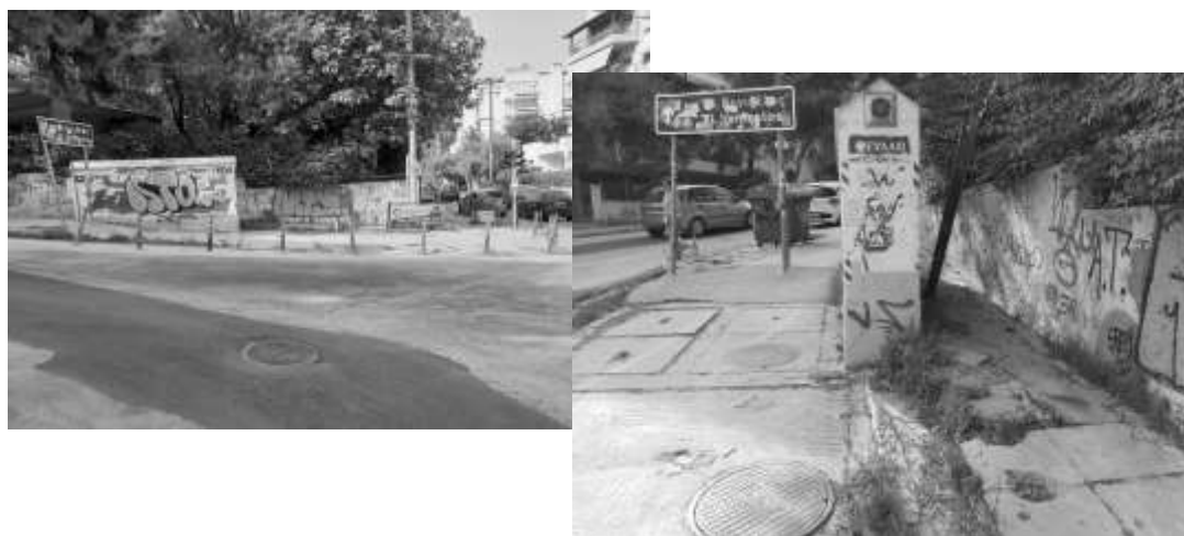
Εικόνα 8.42: Στη συμβολή των οδών Αιγαίου Πελάγους και Νεαπόλεως, δεν υπάρχει διαμορφωμένο πεζοδρόμιο.
