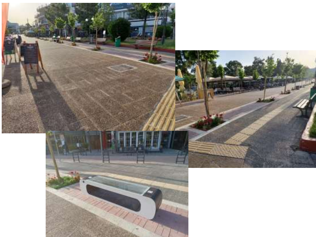
Εικόνα 8.24: Κατάργηση οδοστρώματος και δημιουργία πεζοδρομίων
