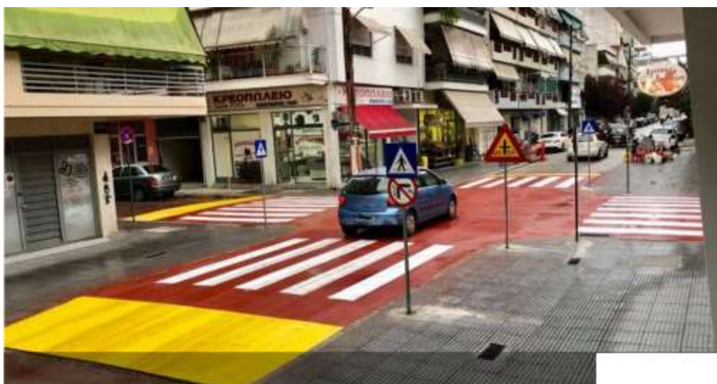
Εικόνα 4.8: Υπερυψωμένη διάβαση πεζών στο Δήμο Τρικάλων, που στοχεύουν στη μείωση της ταχύτητας των διερχόμενων οχημάτων.
