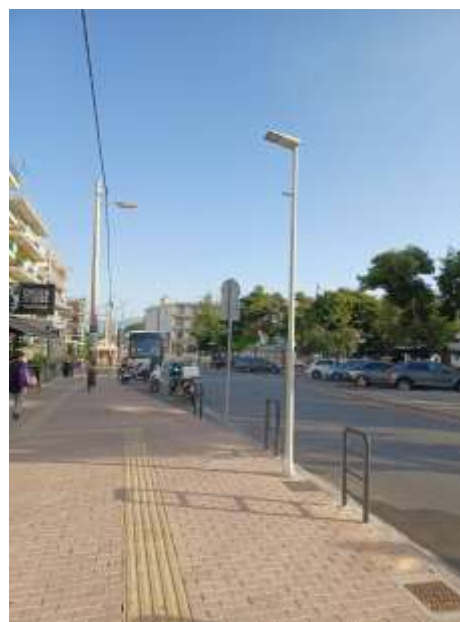
Εικόνα 8.33: Ανακατασκευή πεζοδρομίων με κυβόλιθο, όδευση τυφλών και φωτιστικά σώματα led
