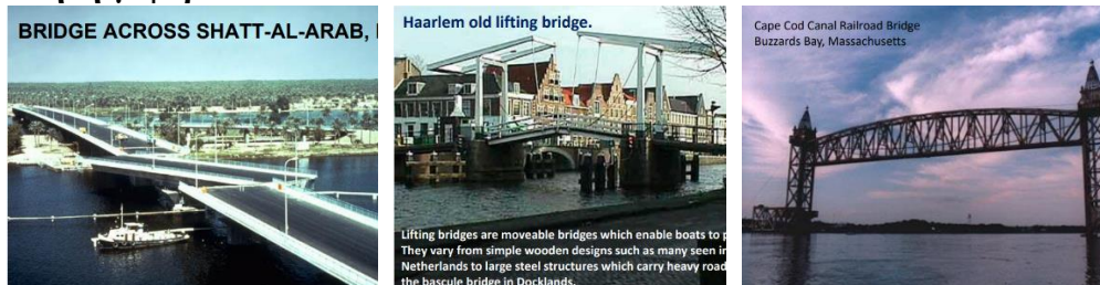
Εικόνα 8 Παραδείγματα κινητών γεφυρών (Α) γέφυρα Shatt – Al – Arab, Iraq, (Β) γέφυρα Haarlem Ολλανδία, (Γ) γέφυρα καναλιού Cape Cod, Μασαχουσέτη. (Σαπουντζάκης, 2022)
