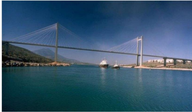
Εικόνα 5 Παράδειγμα καλωδιωτής γέφυρας (Νέα γέφυρα του Ευρίπου, Χαλκίδα). (Σαπουντζάκης, 2022)
