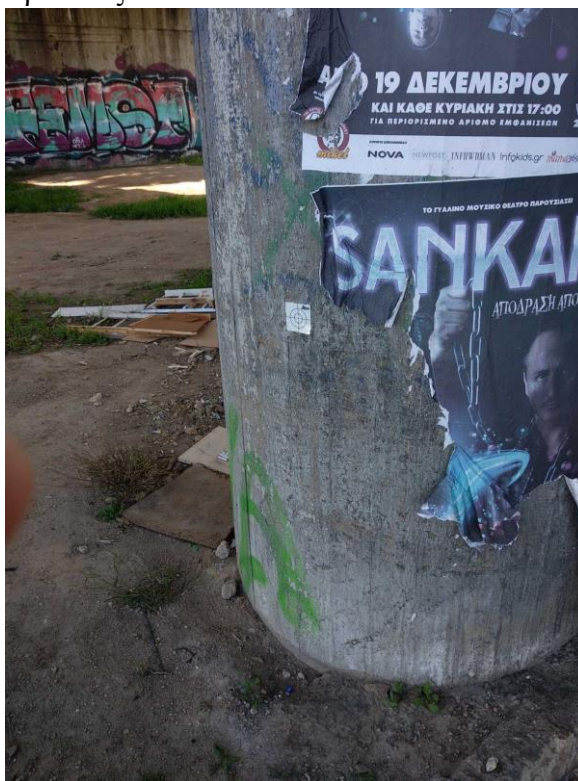
Εικόνα 21 Θέση ανακλαστικού στόχου πάνω στην κολώνα της γέφυρας.
