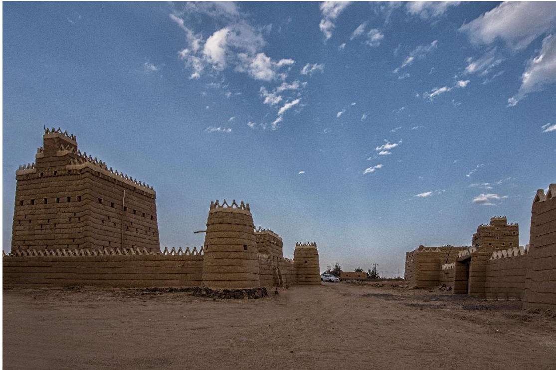
Εικόνα 2.3.46. Αποκατεστημένα πυργόσπιτα στον οικισμό Al Monajem, Najran, Σαουδική Αραβία, την Κυριακή 27 Φεβρουαρίου 2022.
