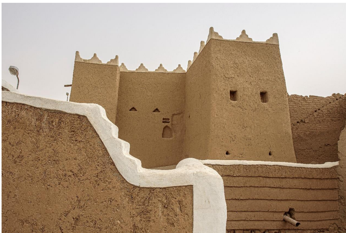
Εικόνα 2.7.42. Αποκατεστημένα κτίρια της παλαιάς πόλης της Shagra, Σαουδική Αραβία, την Κυριακή 6 Μαρτίου 2022.
