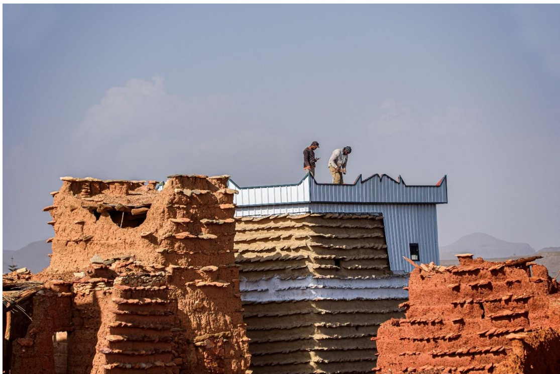
Εικόνα 2.2.13. Παρέμβαση σε παραδοσιακό κτίσμα, με τοποθέτηση μεταλλικής επίστεψης και επικάλυψης της όψης. Al Jahamah, Asir, Σαουδική Αραβία, το Σάββατο 26 Φεβρουαρίου 2022.
