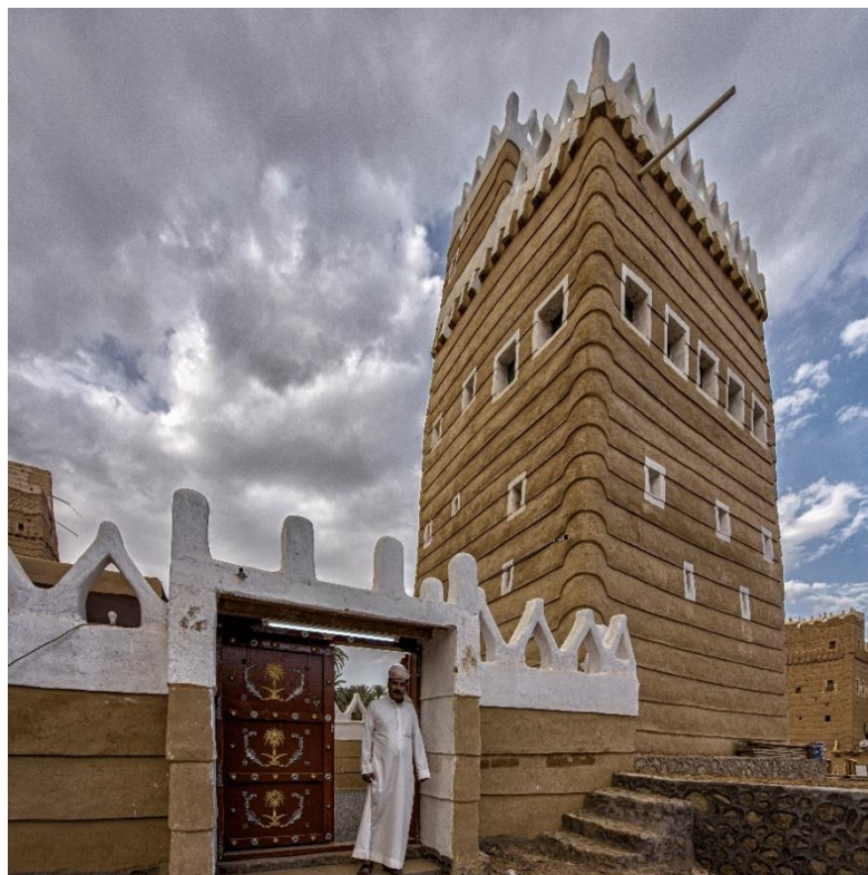
Εικόνα 2.3.41. Αποκατεστημένο κτίριο στον παραδοσιακό οικισμό Al Khrem, Najran, Σαουδική Αραβία, την Κυριακή 27 Φεβρουαρίου 2022.
