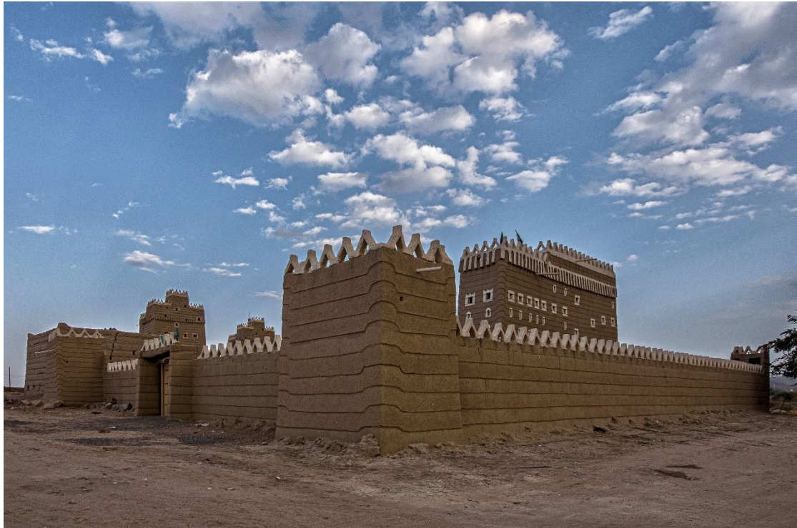
Εικόνα 2.3.48. Το αποκατεστημένο Al Monajem Palace, στον οικισμό Al Monajem, Najran, Σαουδική Αραβία, την Κυριακή 27 Φεβρουαρίου 2022.
