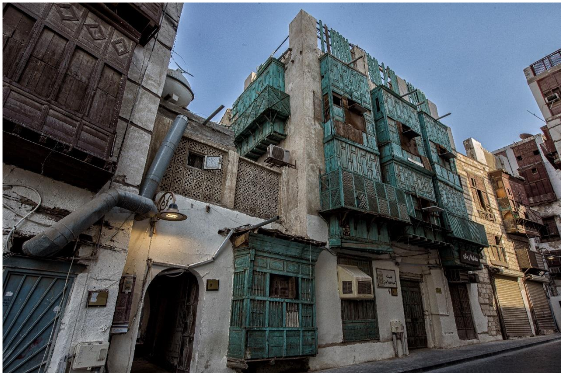
Εικόνα 2.4.6. Πρόσοψη κτιρίου με δικτυωτά πλαίσια παραθύρων σε προεξοχή, Rawasheen με Mashrabiyyas, στην Al-Balad, Jeddah, Σαουδική Αραβία, την Τρίτη 1 Μαρτίου 2022.
