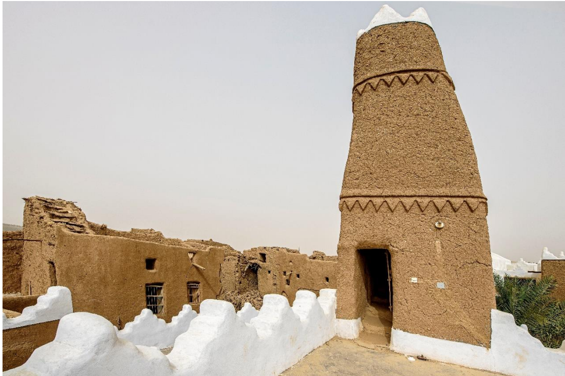
Εικόνα 2.7.18. Πύργος σε δώμα κτιρίου στο Ushaiger , Σαουδική Αραβία, την Κυριακή 6 Μαρτίου 2022.
