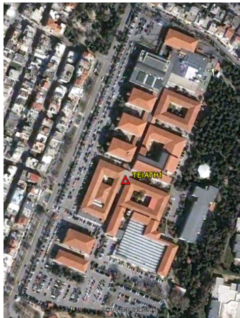
Εικόνα 5.2.1 Η θέση του μόνιμου σταθμού TEIATH1
