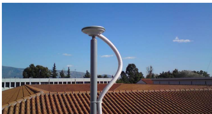
Εικόνα 5.2.2 Η κεραία του σταθμού ΤΕΙΑΤΗ1
