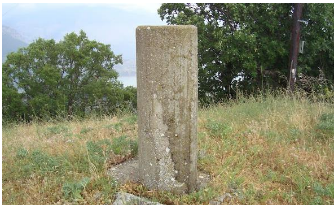
Εικόνα 3.3.1 Βάθρο από σκυρόδεμα του τριγωνομετρικού δικτύου της Ελλάδος
