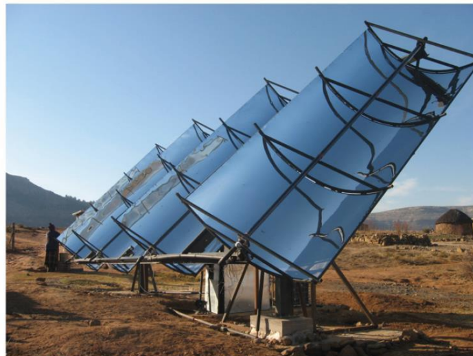
Εικόνα 1.11 – Παραβολικοί συλλέκτες εν λειτουργία. (S. Quoilin, 2011)
