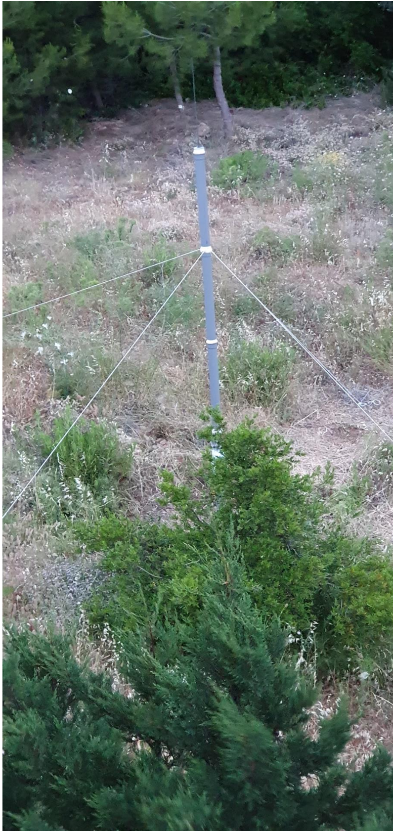
Εικόνα 3.9: Τελική στερέωση της κατασκευής
