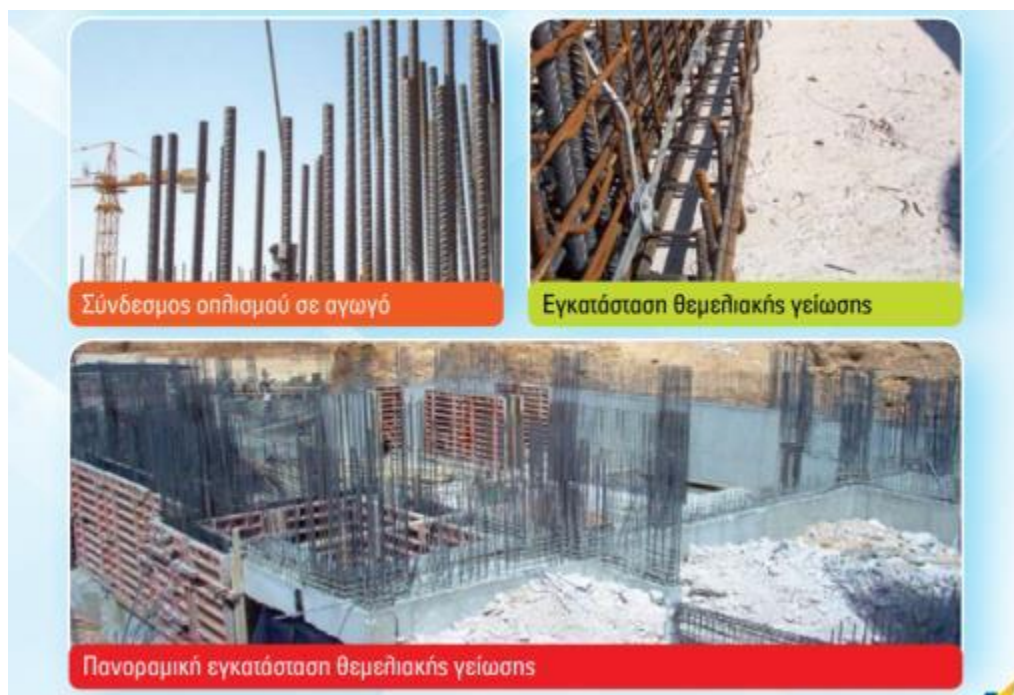
Εικόνα 2.3: Εικόνες εγκατάστασης θεμελιακής γείωσης 2 [7]
