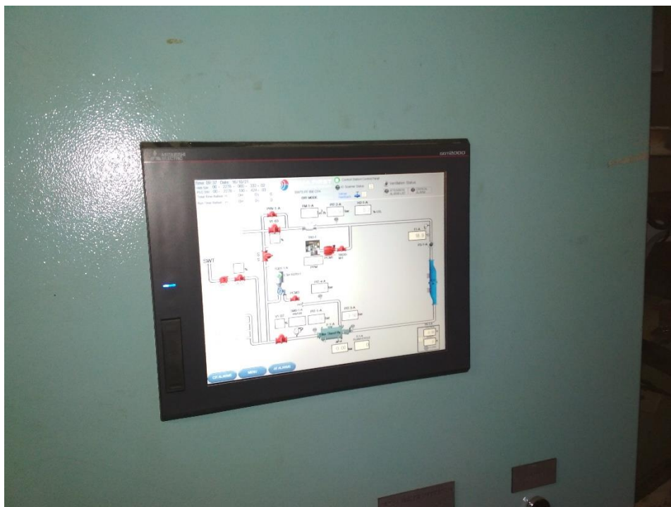
Εικόνα 4.55: Οθόνη που δείχνει τα δεδομένα του κυκλώματος 2
