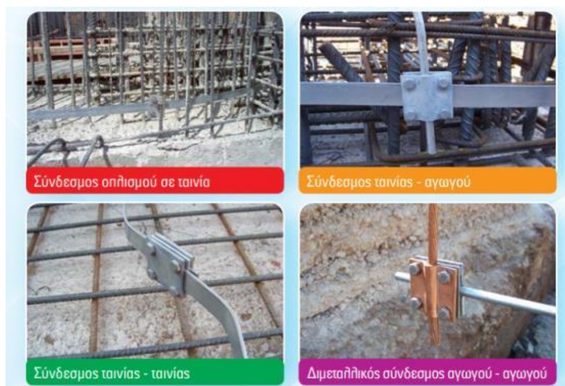
Εικόνα 2.2: Εικόνες εγκατάστασης θεμελιακής γείωσης 1 [7]
