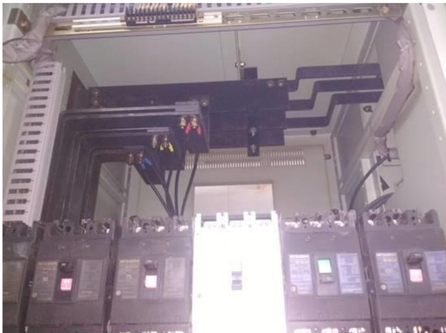
Εικόνα 2.23: Ζυγοί ενός πίνακα
