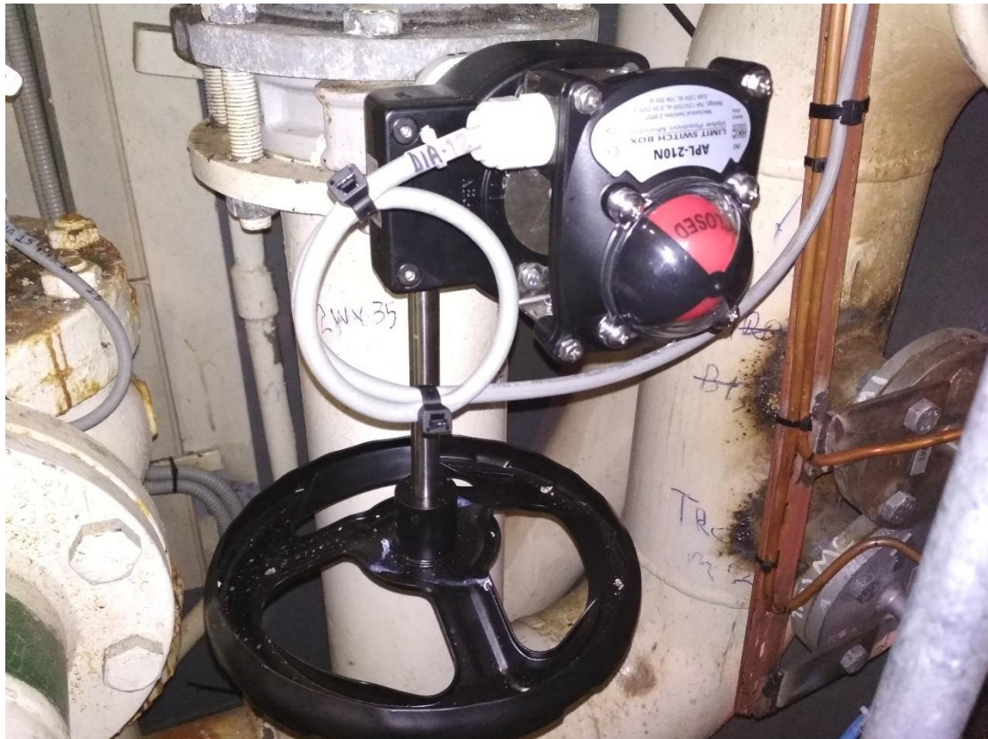
Εικόνα 4.54: Εικόνα μιας βαλβίδας και οριακού διακόπτη
