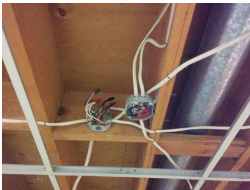
Εικόνα 2.24: Τοποθέτηση πεπλατυσμένων καλωδίων [26]
