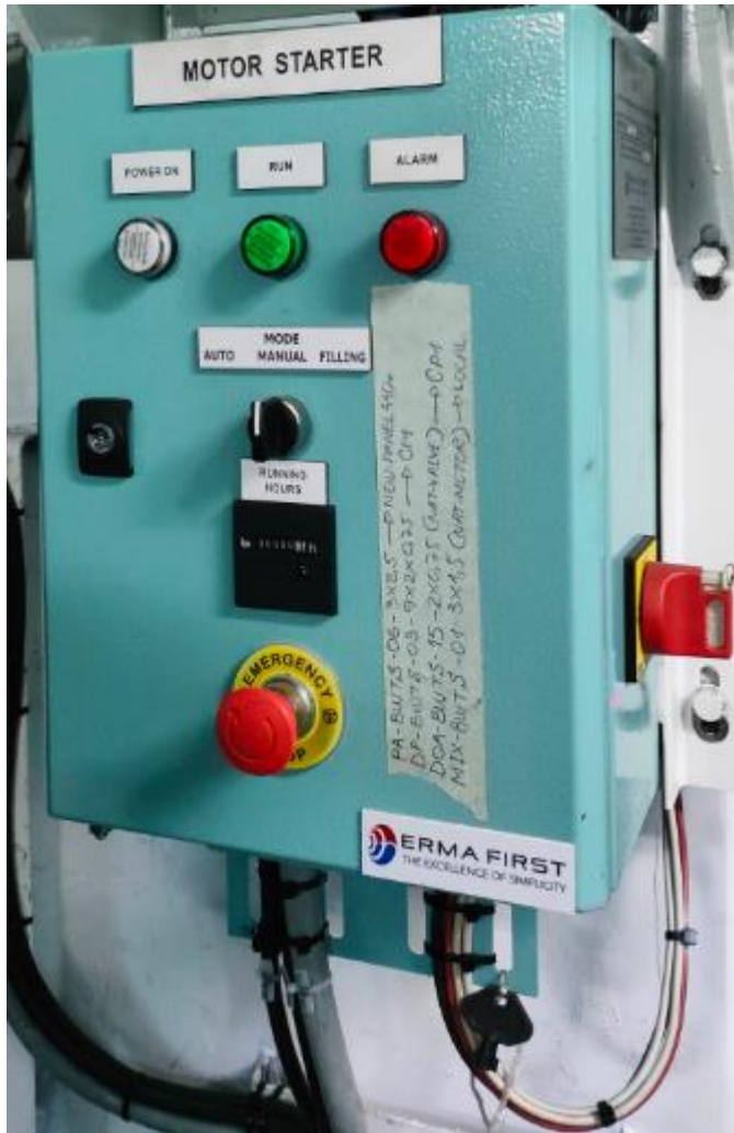
Εικόνα 3.10: Ένδειξη και μπουτόν σε πίνακα
