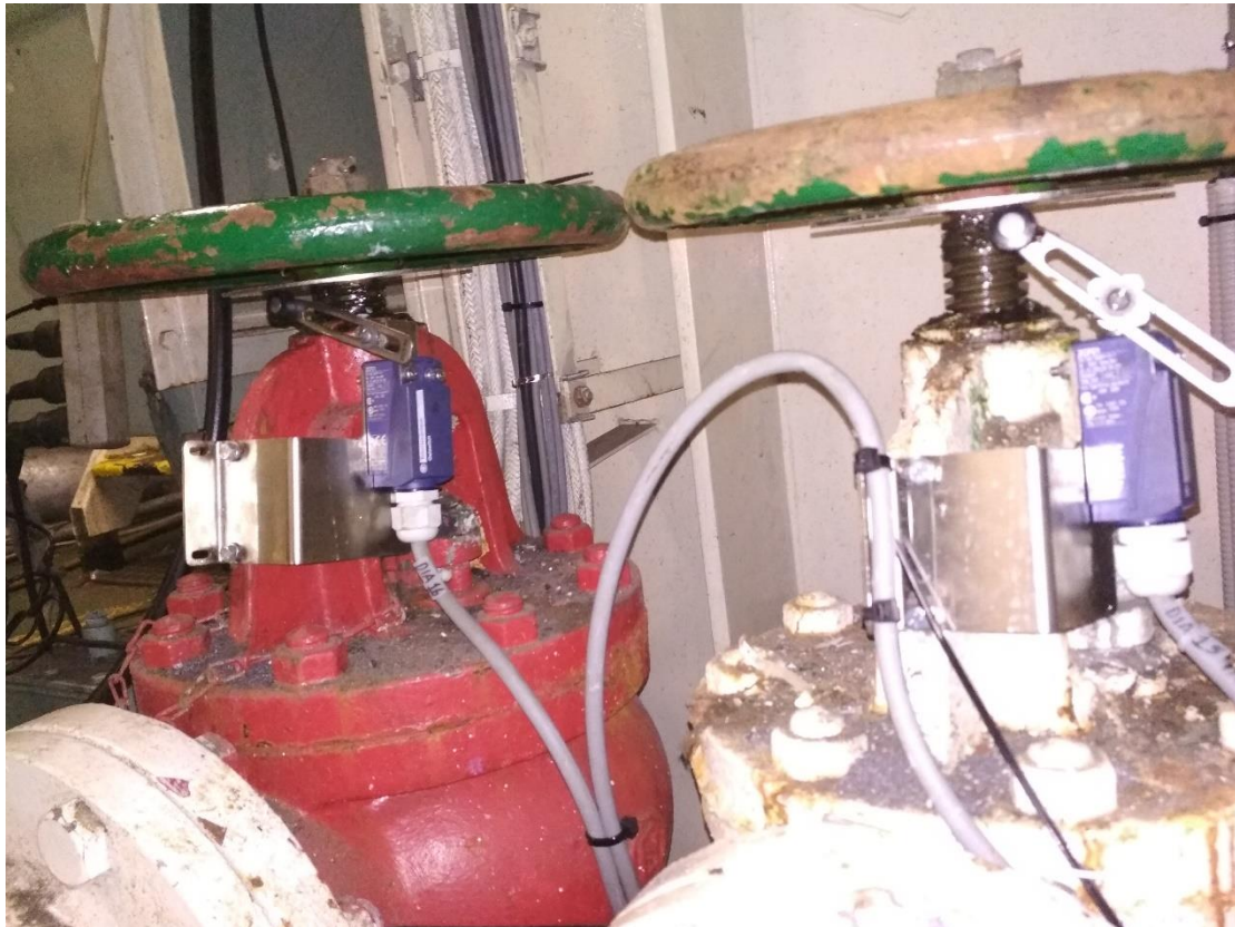
Εικόνα 4.53: Εικόνα βαλβίδων (VW- V19 έως V34) και οριακών διακόπτων
