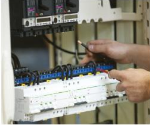
Εικόνα 3.18: Συναρμολόγηση πίνακα διανομής με σταθερή λειτουργική μονάδα [37]
