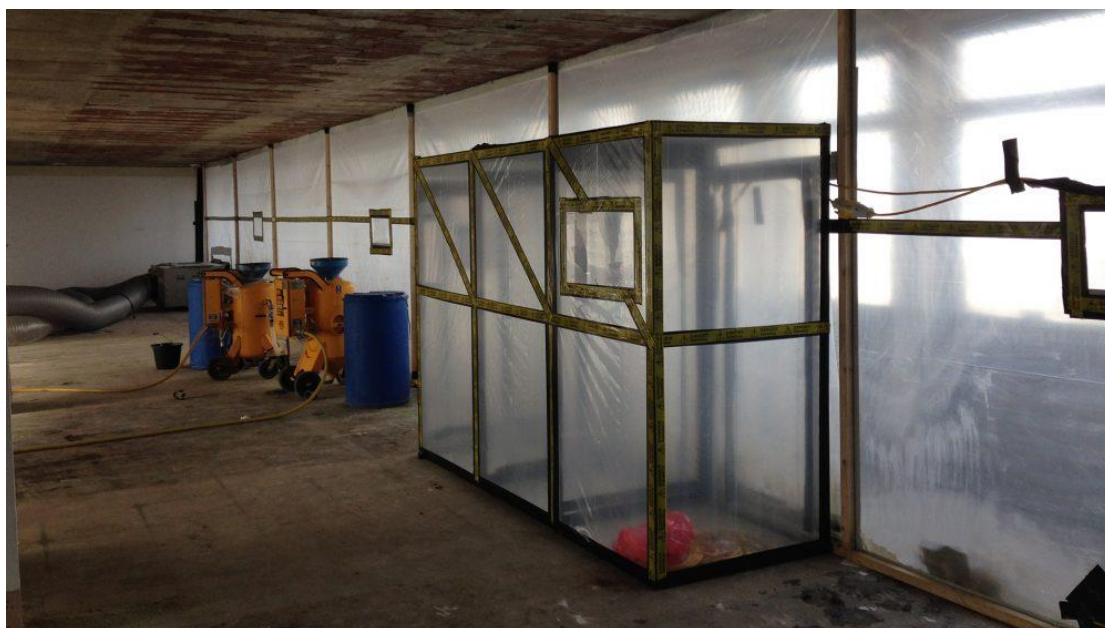
Εικόνα 23: Το διπλό αποδυτήριο που χρησιμοποιείται σε εργασιακούς χώρους υψηλού κινδύνου με Αμίαντο, (Downwell Group,2022)
