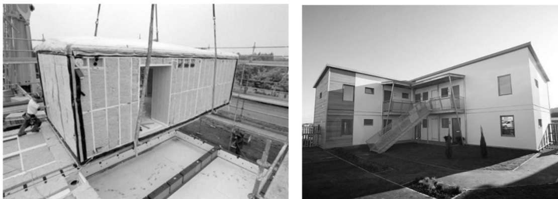
Εικόνα 6: Προκατασκευασμένο σπίτι από το IKEA κατά την ανέγερσή του με γερανό και ύστερα από την τις εργασίες μόνωσης, οι οποίες γίνονται επί τόπου.
