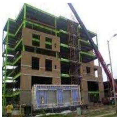
Εικόνα 10: Προκατασκευασμένη Δόμηση Μεταλλικού Πλαισίου (Jagtap & Dhawadw, 2015)
