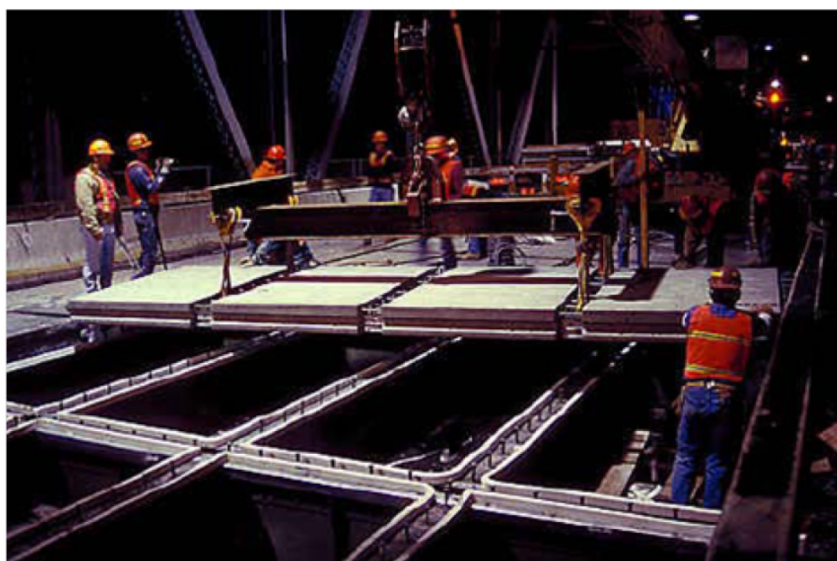
Εικόνα 18: Εγκατάσταση εξωτερικού καταστρώματος γέφυρας (Roddenberry & Servos, 2012)
