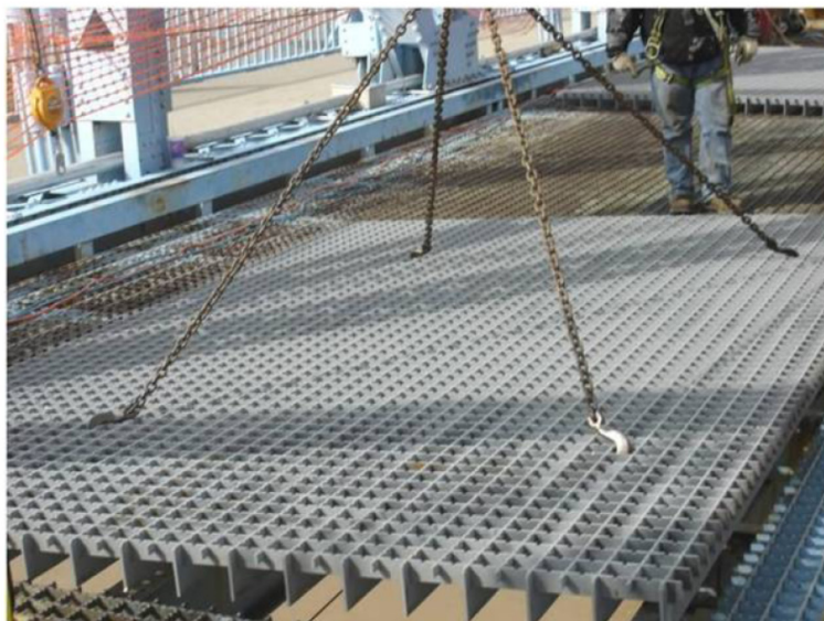
Εικόνα 17: Κατάστρωμα ανοιχτού πλέγματος (Roddenberry & Servos, 2012)
