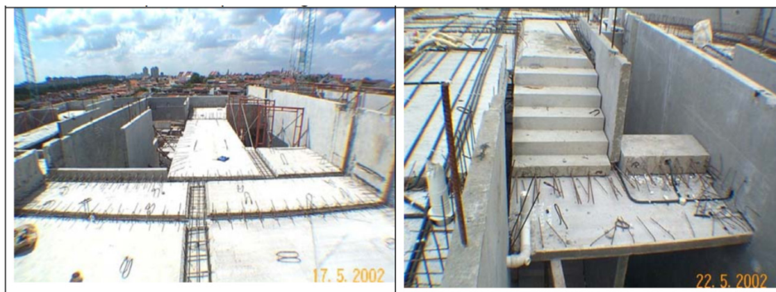
Εικόνα 48: Τοποθέτηση προκατασκευασμένων σανίδων (αριστερά) και Προετοιμασία κατασκευής πλατύσκαλου σε προκατασκευασμένη σκάλα (δεξιά (Building and Construction Authority, 2003))
