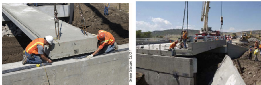
Εικόνα 15: Κατασκευή προκατασκευασμένης γέφυρας (Roddenberry & Servos, 2012)
