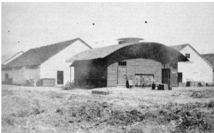
Εικόνα 4: Το Renkioi Hospital, φτιαγμένο από προκατασκευασμένη ξυλεία (Egege, 2018)
