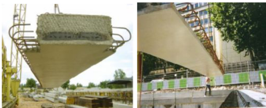
Εικόνα 22: Δοκός ανεστραμμένου T (Roddenberry & Servos, 2012)
