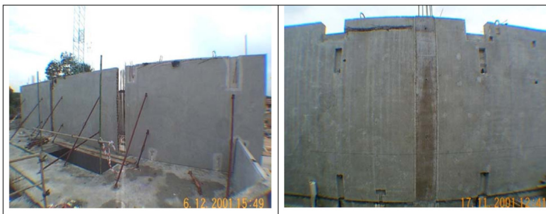
Εικόνα 47: Οι προκατασκευασμένοι τοίχοι στερεώνονται πριν την τοποθέτηση των συνδέσεων (απαιτείται τέλεια ευθυγράμμιση) αριστερά και η ταινία σύνδεσης που έχει κατασκευαστεί ανάμεσα στους δύο προκατασκευασμένους τοίχους (δεξιά) (Building and Construction Authority, 2003)
