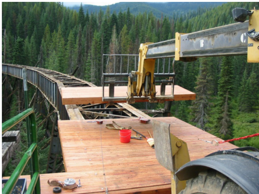
Εικόνα 20: Κατασκευή γέφυρας ξύλινου καταστρώματος (Roddenberry & Servos, 2012)
