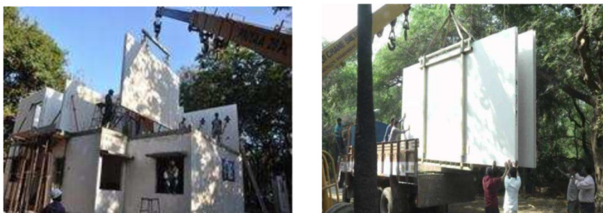
Εικόνα 8: Ανέγερση σπιτιού με χρήση προκατασκευασμένων πάνελ (Jagtap & Dhawadw, 2015)
