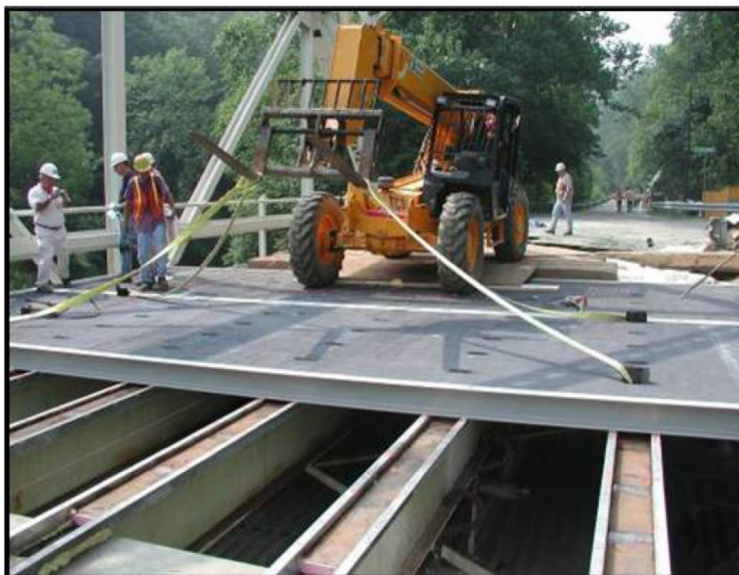
Εικόνα 19: Κατασκευή καταστρώματος από ενισχυμένο με ίνες πολυμερές (Roddenberry & Servos, 2012)
