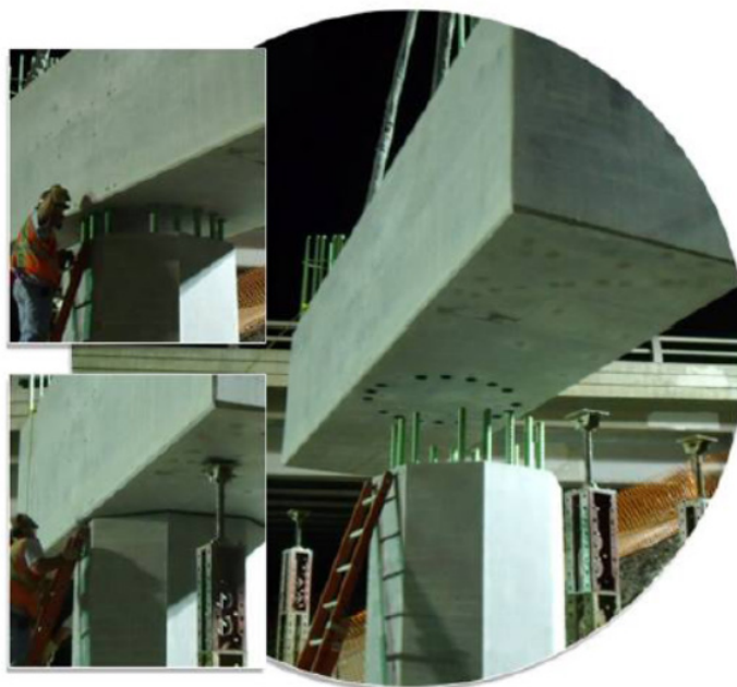
Εικόνα 23: Σύνδεση δοκού με καλύπτρα (Roddenberry & Servos, 2012)
