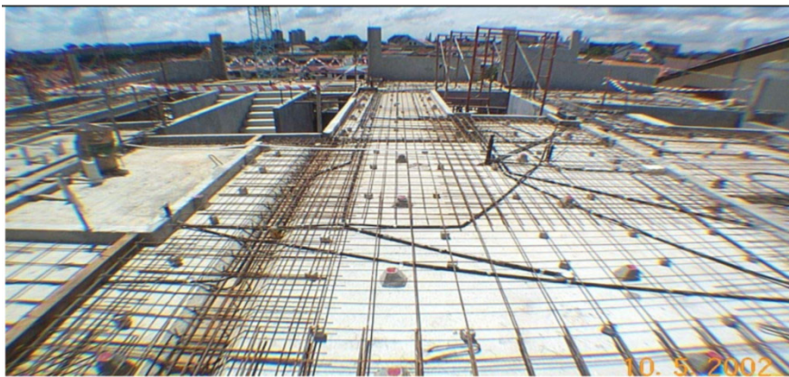
Εικόνα 43: Η όδευση των ηλεκτρικών καλωδίων ενσωματωμένων στην επικάλυψη της πλάκας (Building and Construction Authority, 2003)
