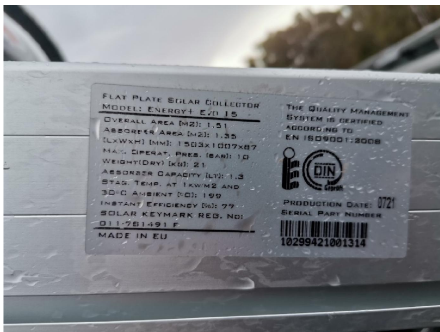
Εικόνα 4. Βασικά χαρακτηριστικά συλλεκτών.
