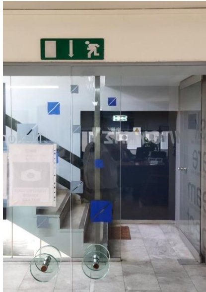
Εικ.13 - Σήμανση πάνω από πόρτα που οδηγεί προς την έξοδο κινδύνου. (Πηγή : Προσωπική συλλογή, 2022)
