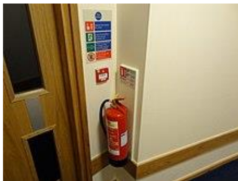
Εικ.7 - Ένας πυροσβεστήρας εγκλωβισμένης πίεσης κατασκευασμένος από την Amerex, (Πηγή: Πυροσβεστήρας-Wikipedia, 2012)
