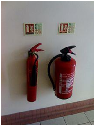
Εικ.5 - Τυπικοί βρετανικοί πυροσβεστήρες με CO 2 και νερό, (Πηγή: Πυροσβεστήρας - Wikipedia, 2007)
