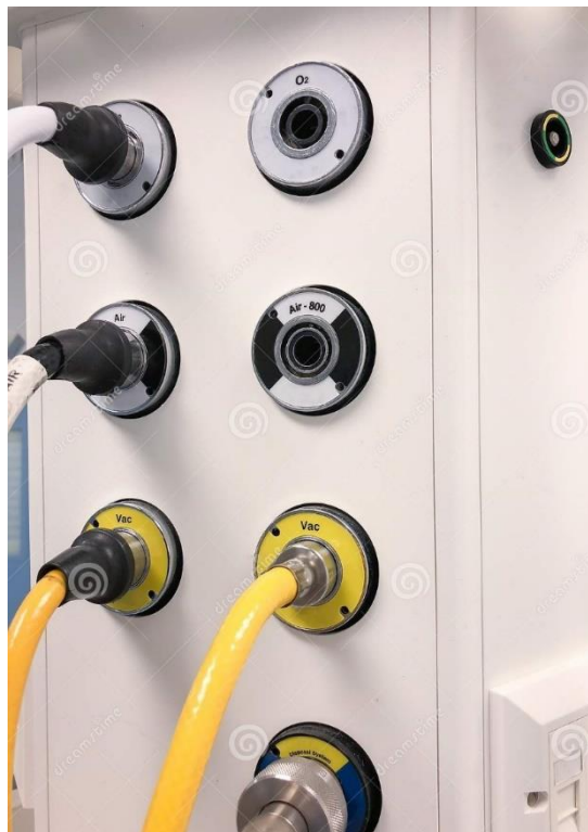
Εικόνα 19 - Υποδοχές αέρα, οξυγόνου και αρνητικής πίεσης σε κλίνες μονάδων νοσοκομείου (Πηγή: https://www.dreamstime.com/photos-images/medical-gases.html )
