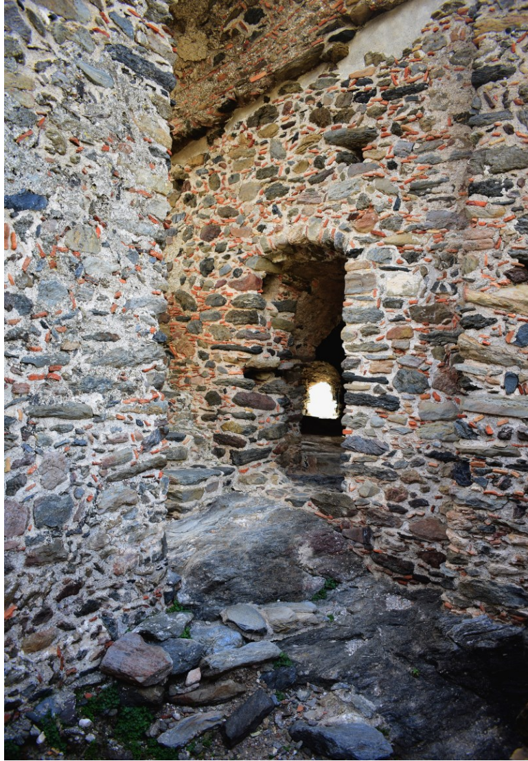
Εικ.9. Εσωτερικός χώρος Κάστρου Βατίκων. Τοίχοι Κάστρου.
