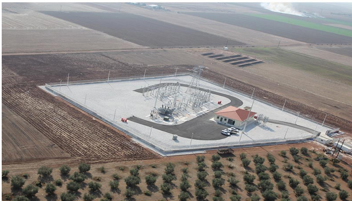
Σχήμα 5. 3: Υ/Σ 150/20 KV
