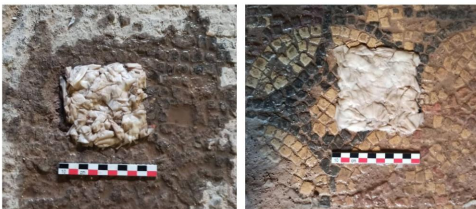
Εικ.5.30: Εφαρμογή της διαδικασίας αφαλάτωσης με κομπρέσες. Στα αριστερά της εικόνας γίνεται η εφαρμογή κομπρέσας σε αδιάλυτα άλατα και στα δεξιά γίνεται εφαρμογή κομπρέσας σε διαλυτά άλατα, Νικοδήμου Π., 2022.
