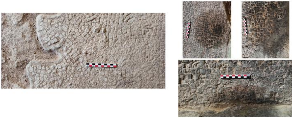
Εικ.5.17,5.18: Δημιουργία και δράση διαλυτών/αδιάλυτων αλάτων και βιολογικών επικαθήσεων, Νικοδήμου Π,2021.
