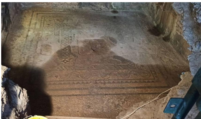
Εικ.5.21: Διείσδυση βρόχινου νερού στο ψηφιδωτό δάπεδο, Νικοδήμου Π, 2022.
