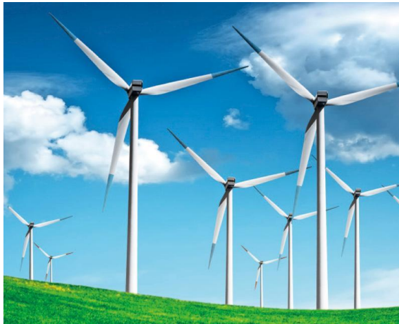
Εικόνα.3 Ηλεκτροπαραγωγική εγκατάσταση Ανεμογεννητριών.
