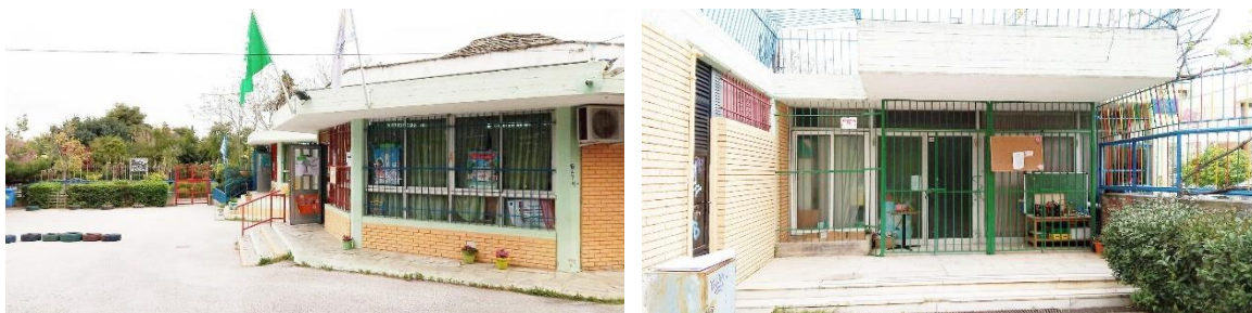
Εικόνα 52 & Εικόνα 53: Υλικά κατασκευής στην Νότια και την Ανατολική Είσοδο και τον αύλειο χώρο του κτιρίου. Ημ. Λήψης 19.04.22
