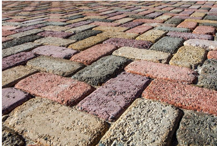
Εικόνα 81: Χρωματιστοί κυβόλιθοι επίστρωσης εξωτερικού χώρου. Πηγή: (ΤΣΙΜΕΝΤΟΤΕΧΝΙΚΗ)
