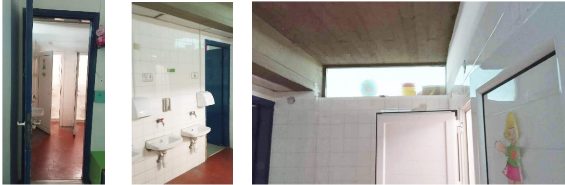
Εικόνα 40, Εικόνα 41, Εικόνα 42 : W.C. νηπίων. Ημ. Λήψης 19.04.22
