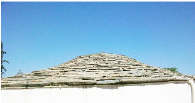
Εικόνα 50 & Εικόνα 51 : Στέγηση οκταγωνικών αιθουσών από οπλισμένο σκυρόδεμα και πλάκες Πηλίου, που καταλήγει σε διαφώτιστο που φωτίζει την αίθουσα διδασκαλίας. Φωτογραφία 47 αρχείο ΟΣΚ & 48 Ημ. Λήψης: 19.04.22
