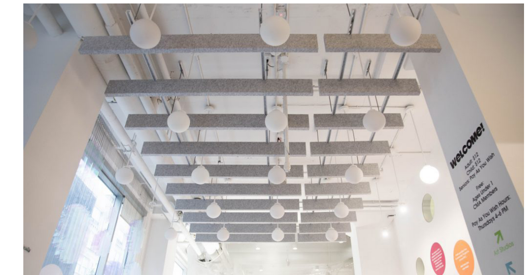
Εικόνα 40: Μια σειρά από διχρωμικά ακρυλικά πάνελ που κρέμονται από την οροφή μπροστά από τα μεγάλα παράθυρα με νότιο προσανατολισμό επιτρέπουν στο φως διαφορετικών χρωμάτων να ανακλάται και να μεταδίδεται ταυτόχρονα.
