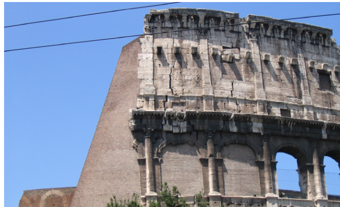
Εικ. 5: Η στερέωση του ανατολικού άκρου το 1806-1807 από τον R. Stern. (Μαλλούχου-Tufano, 2015, p. 86)
