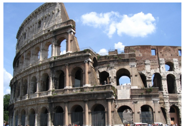
Εικ. 9: Οι αντηρίδες, των ετών 1823-1826 στα βορειοδυτικά άκρα του εξωτερικού και του ενδιάμεσου δακτυλίου του Κολοσσαίου. (Μαλλούχου-Tufano, 2015, p. 93)
