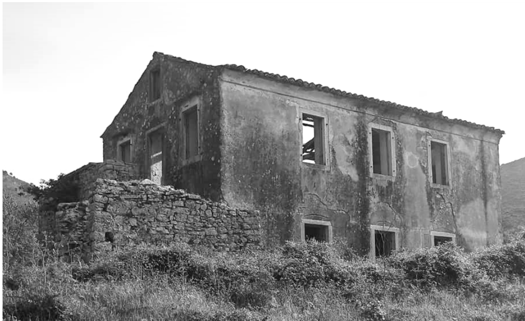
Εικόνα 24 Βόρεια όψη Πηγή: Προσωπικό φωτογραφικό αρχείο
