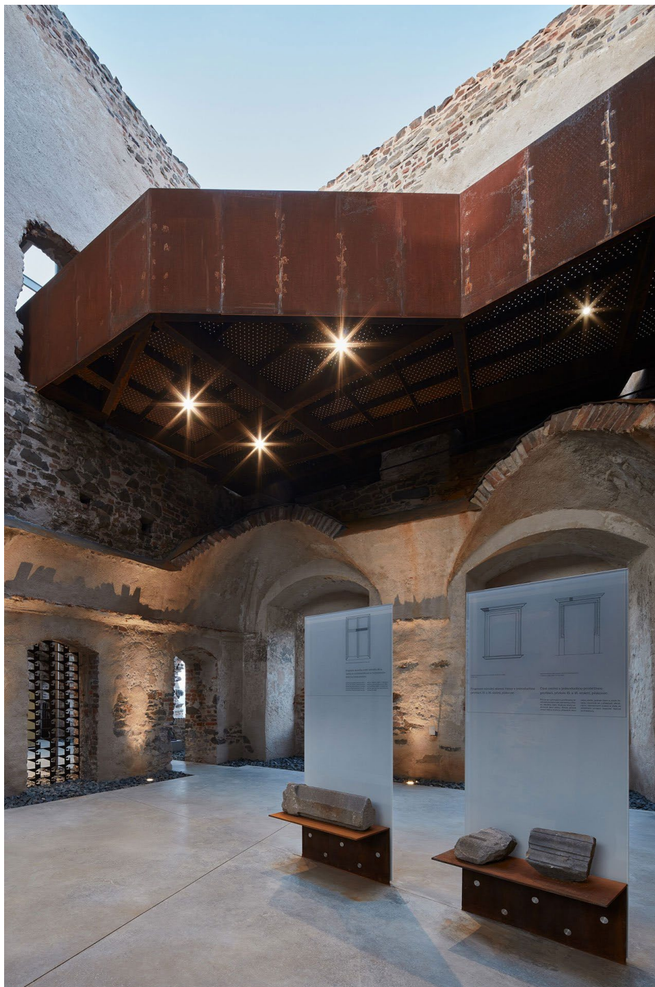
Εικόνα 41 Άλλες εφαρμογές της λαμαρίνας Corten -Helfstýn Castle, (14ος αιώνας), Atelier-r, Τσεχία Πηγή: Σημειώσεις Μπόμπολου Νικόλαου για το μάθημα Δομική ΙΙΙ του Πανεπιστημίου Δυτικής Αττικής, Τμήμα Εσωτερικής Αρχιτεκτονικής
