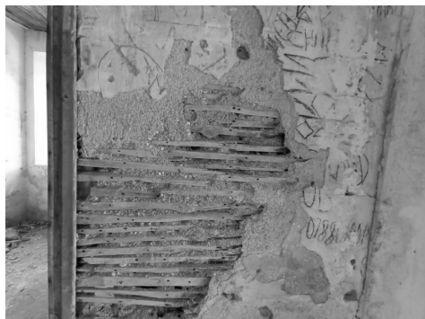
Εικόνα 13 Λεπτομέρειες ισογείου α.Μπαγδατί β.Τομή τοίχου από μπαγδατί γ. Μπαγδατί στα ανοίγματα
