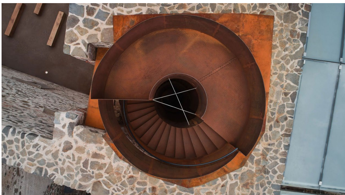
Εικόνα 39 Άλλες εφαρμογές της λαμαρίνας Corten - Helŕstŕn Castle , (14 ος αιώνας), Atelier-r , Τσεχία Πηγή: Σημειώσεις Μπόμπολου Νικόλαου για το μάθημα Δομική ΙΙΙ του Πανεπιστημίου Δυτικής Αττικής, Τμήμα Εσωτερικής Αρχιτεκτονικής
