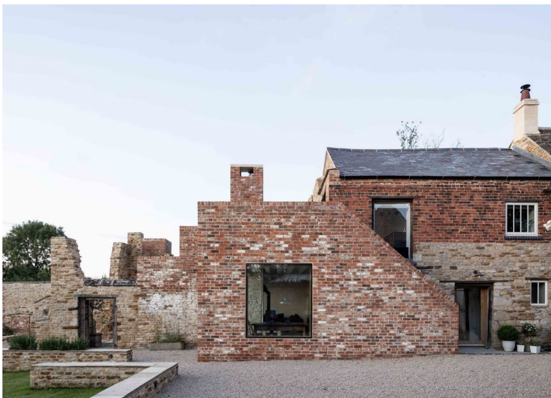
Εικόνα 27 Άποψη του παλιού εργοστασίου χαρτιού
