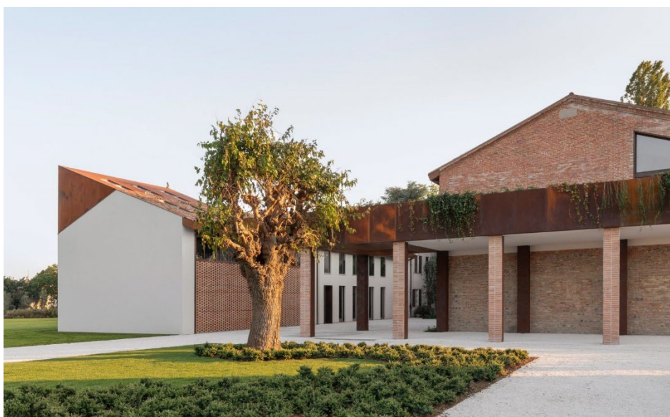
Εικόνα 36 Άποψη του εξωτερικού χώρου
