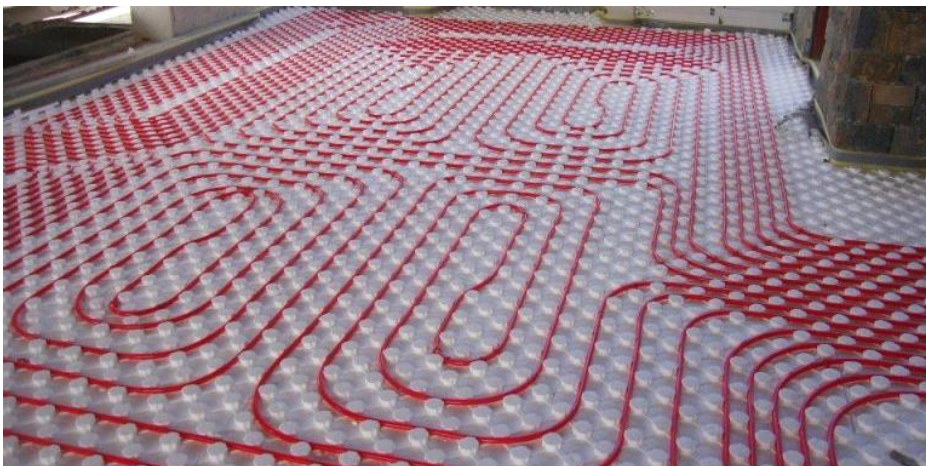
Εικόνα 4-6 Απεικόνιση συστήματος επιδαπέδιας θέρμανσης ( reconsblog.gr, n.d. )
