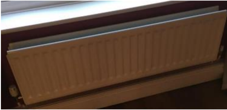
Εικόνα 4-5 απεικόνιση ενός σώματος καλοριφέρ τύπου πάνελ ( assets.publishing.service.gov.uk, 2021 )
