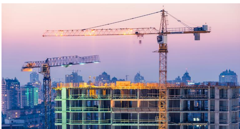
Εικόνα 1.4.: Πυργογερανός σε εγκατάσταση.
