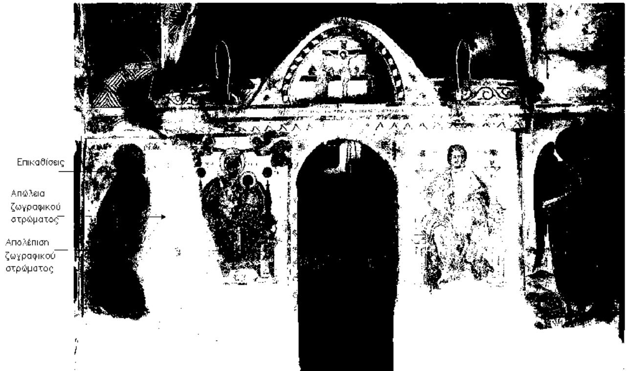
Εικόνα 39 : Ενδεικτικές φθορές τοιχογραφιών τέμπλου.
