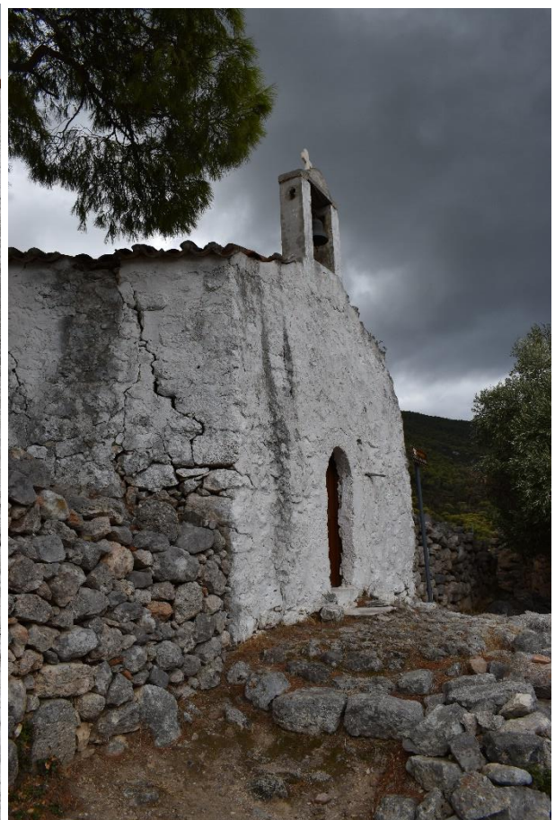
Εικόνα 21: Οι έντονες ρωγματώσεις της τοιχοποιίας του νάρθηκα (φωτ. Π. Ματθιοπούλου - Π. Λαμπρινίδης - Στάχτος 2021, ©ΥΠΠΟΑ)
