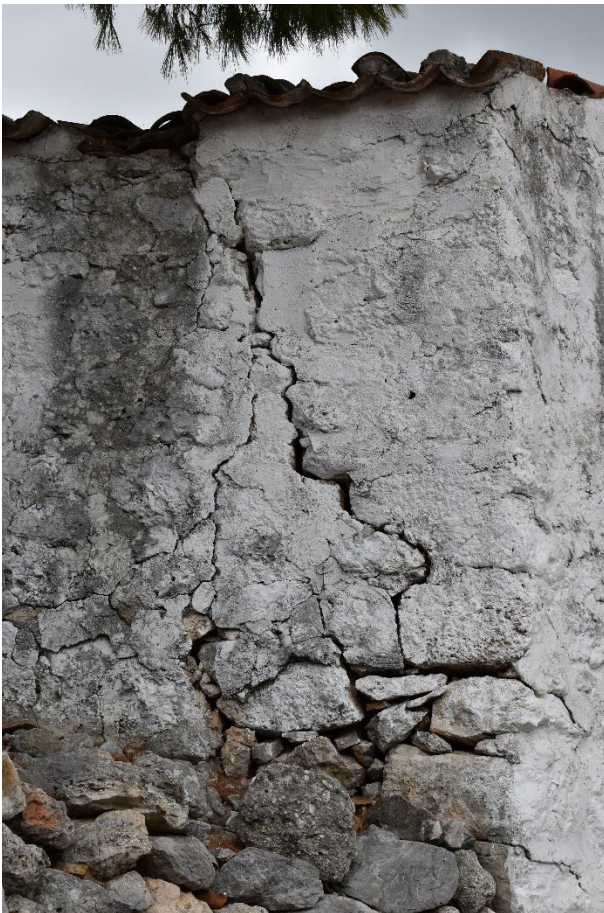
Εικόνα 21: Οι έντονες ρωγματώσεις της τοιχοποιίας του νάρθηκα (φωτ. Π. Ματθιοπούλου - Π. Λαμπρινίδης - Στάχτος 2021, ©ΥΠΠΟΑ)
