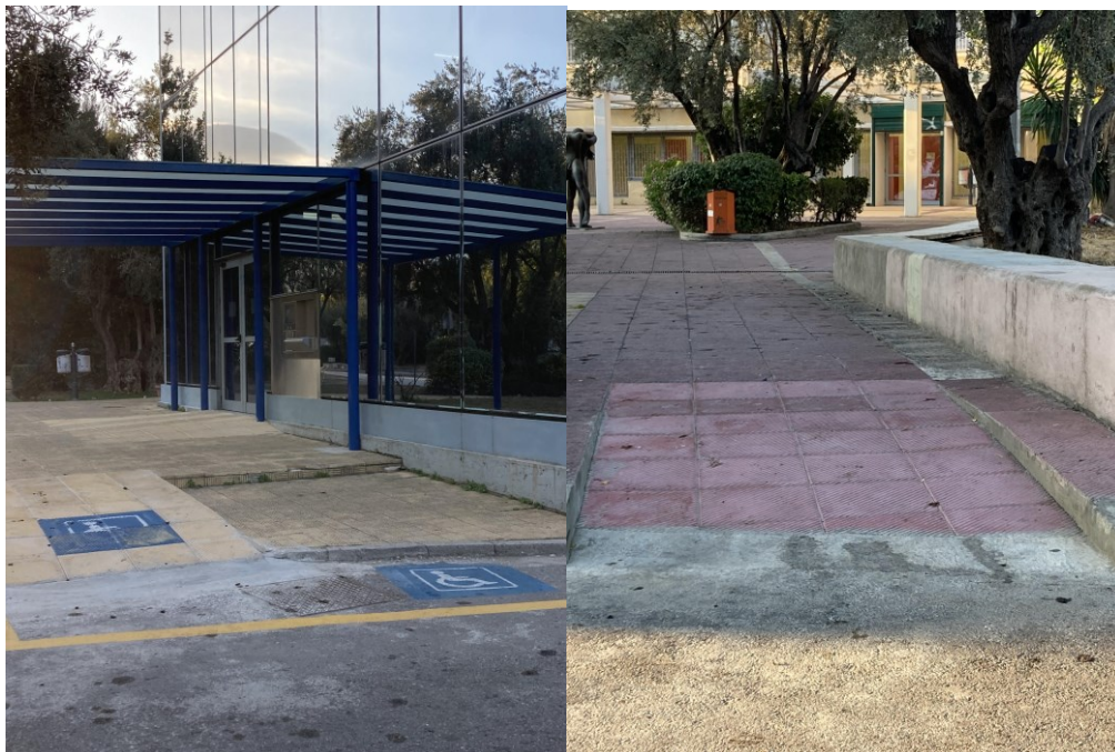
Εικόνα 28: Ράμπες Αναπήρων (Πηγή Φωτογραφιών από τον ιστότοπο του ΠΑΔΑ)
