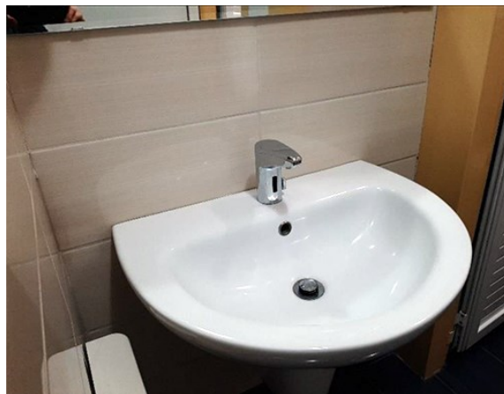
Εικόνα 25: Αυτοματοποιημένες βρύσες
