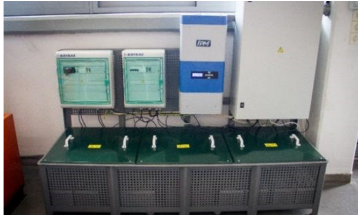
Εικόνα 17: Μπαταρίες αποθήκευσης ενέργειας (Πηγή Φωτογραφιών από τον ιστότοπο του ΠΑΔΑ)
