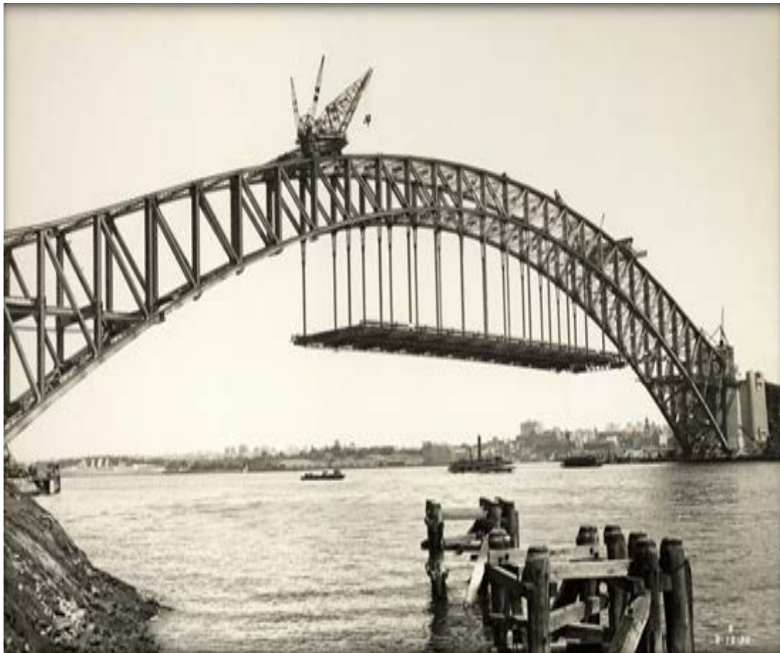
Εικόνα 34 Η κατασκευή του καταστρώματος
