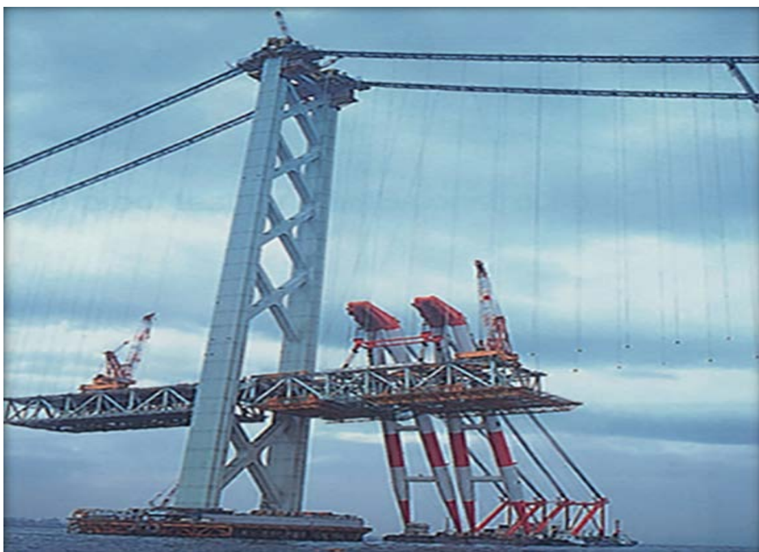
Εικόνα 8,9 Κατασκευή καταστρώματος γέφυρας: Μεταφορά προκατασκευασμένων σπονδύλων
