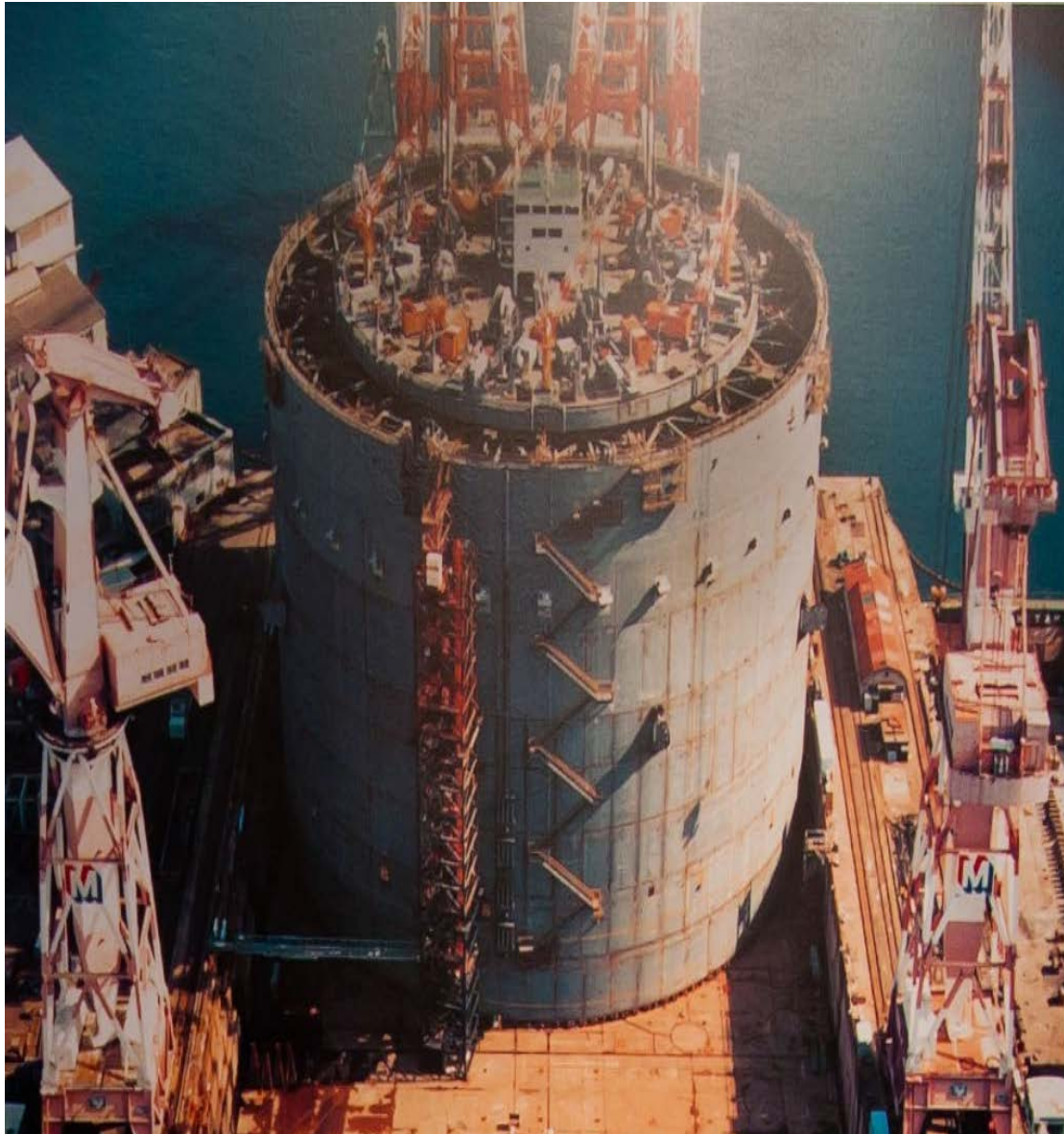
Εικόνα 3 Η μεταφορά του χαλύβδινου καλουπιού
