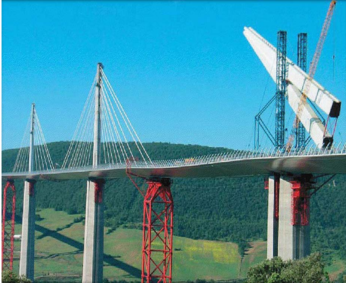
Εικόνα 57 Η τοποθέτηση των πύργων
