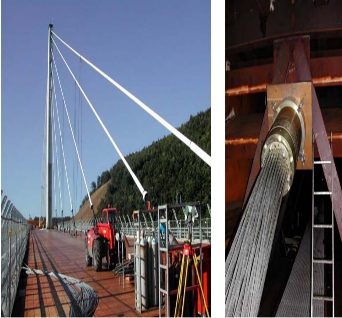
Εικόνα 58 Η καλωδίωση της γέφυρας και η αγκύρωση μέσα στο κατάστρωμα
