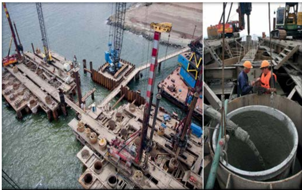
Εικόνα 43,44 Τοποθέτηση και σκυροδέτηση των πασσάλων
