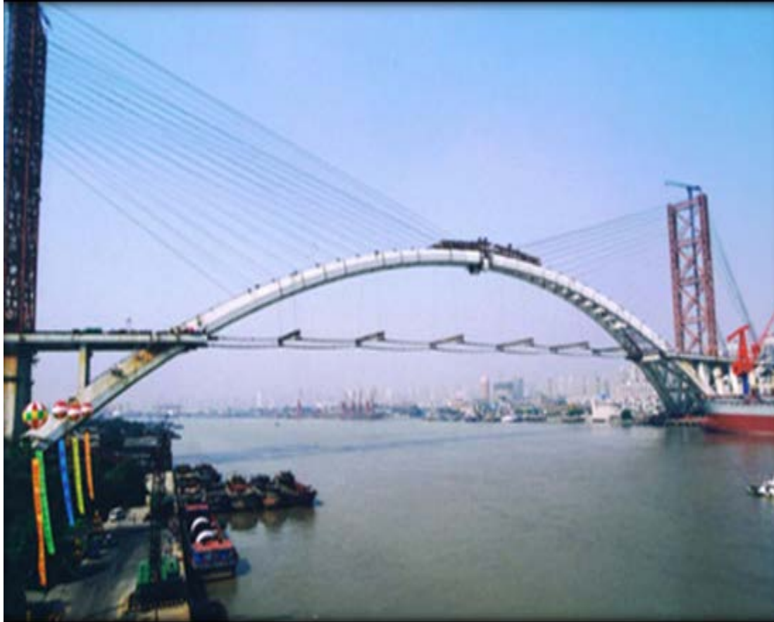
Εικόνα 25 Το δέσιμο των κομματιών κατά την κατασκευή
