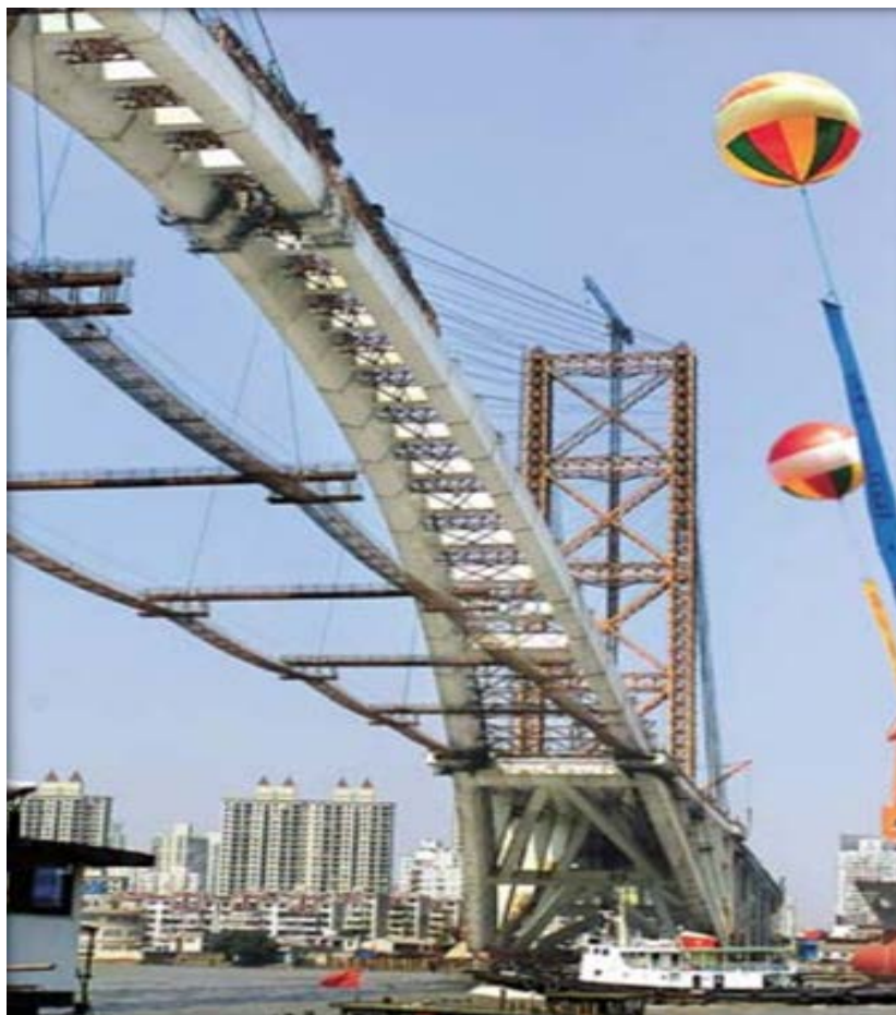
Εικόνα 27 Τα οριζόντια καλώδια με τα οποία δέθηκαν οι άκρες του τόξου
