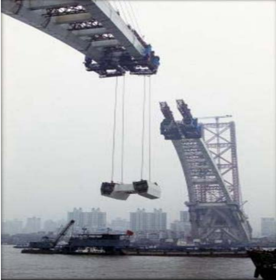
Εικόνα 26 Η ανύψωση των κομματιών από τον ποταμό
