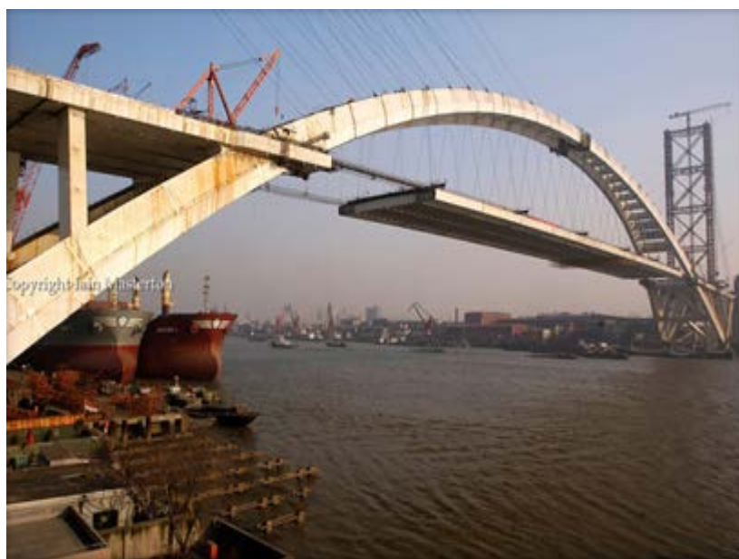
Εικόνα 28 Η σταδιακή τοποθέτηση του καταστρώματος
