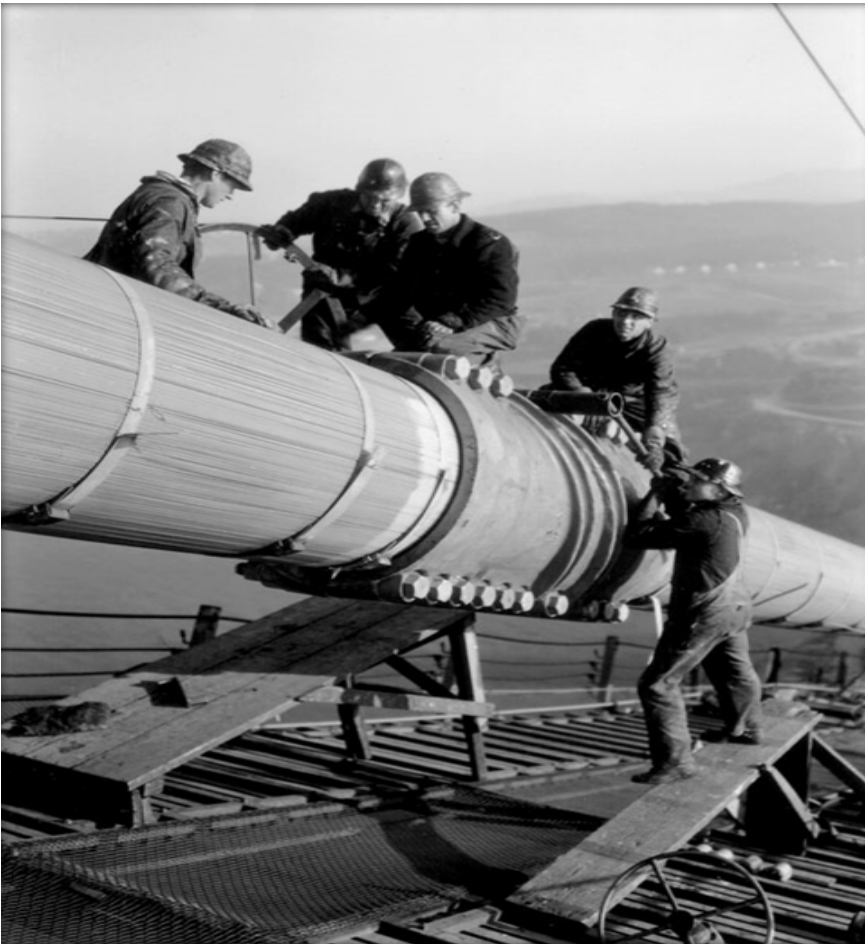
Εικόνα 18 Η υδραυλική πρέσα που συμπύκνωσε τα λεπτά σύρματα σε ένα μεγάλο καλώδιο
