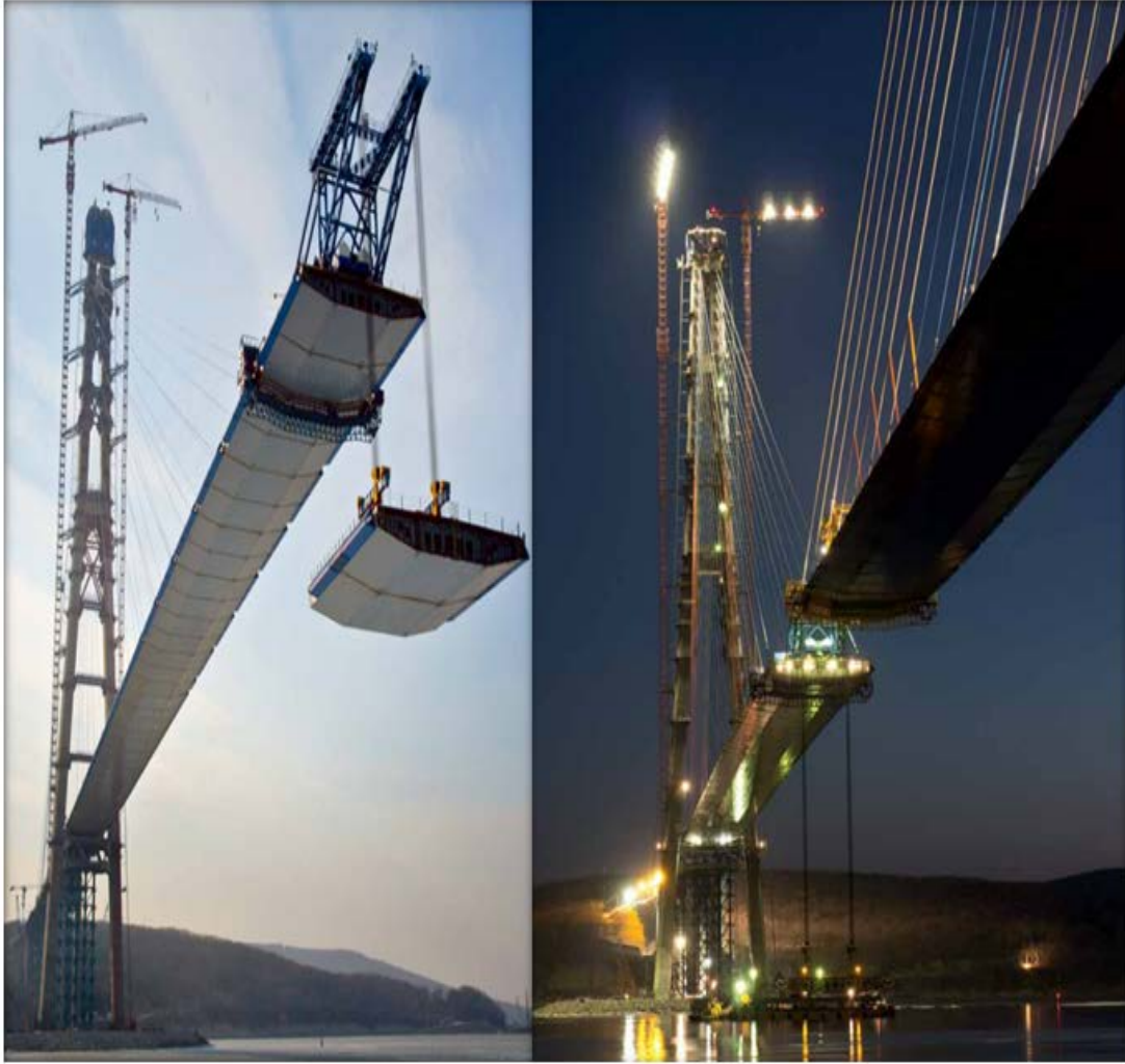
Εικόνα 50 Η ανύψωση των πάνελ
