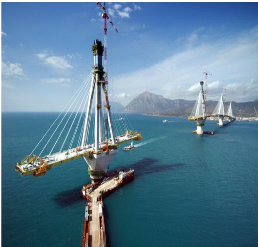
Εικόνα 75 Η κατασκευή του καταστρώματος με την τεχνική της αμφίπλευρης προβολοδότησης
