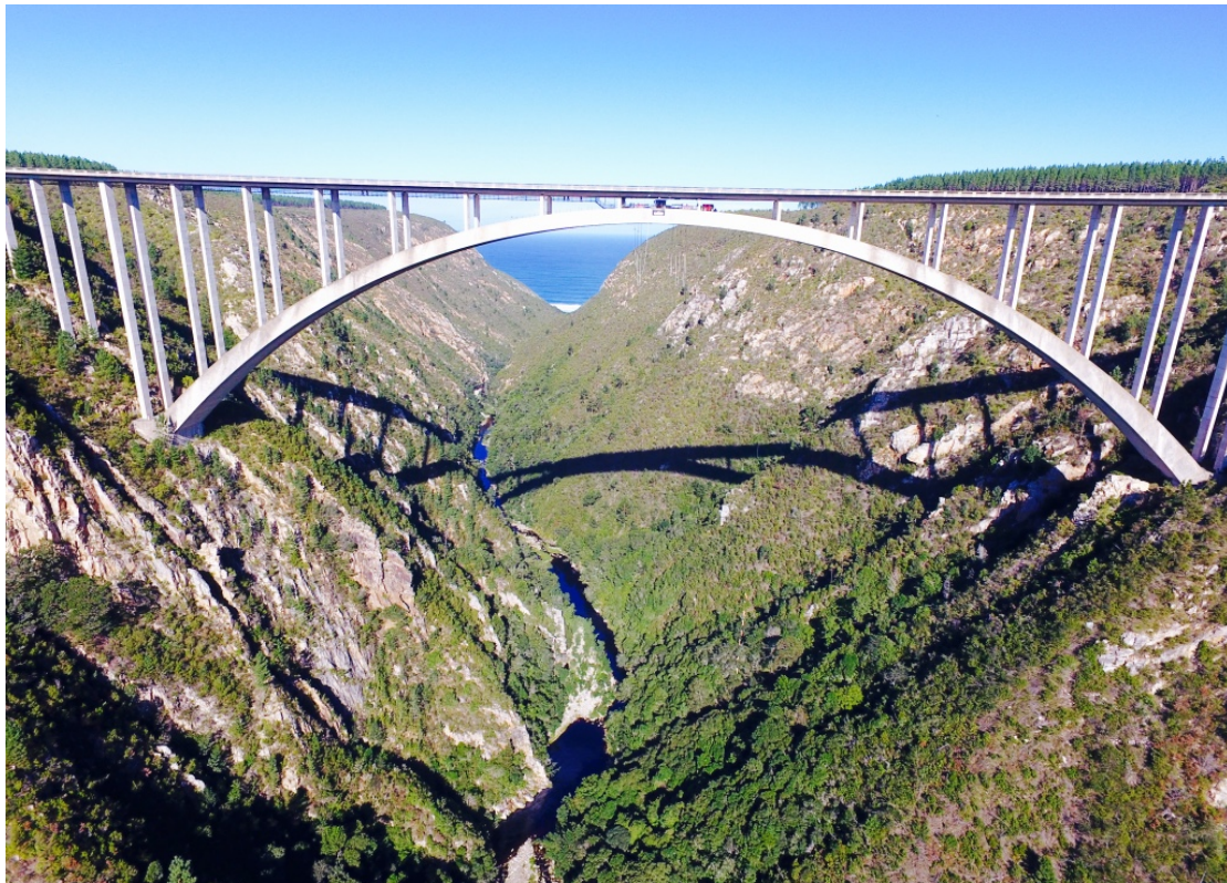
Εικόνα 86 Η γέφυρα Bloukrans
