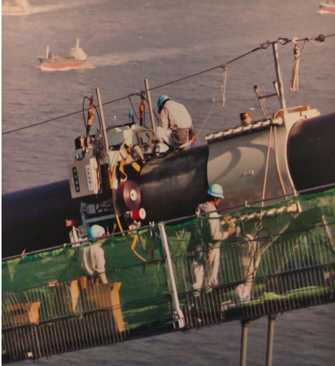
Εικόνα 7 Η τοποθέτηση του καλωδίου
