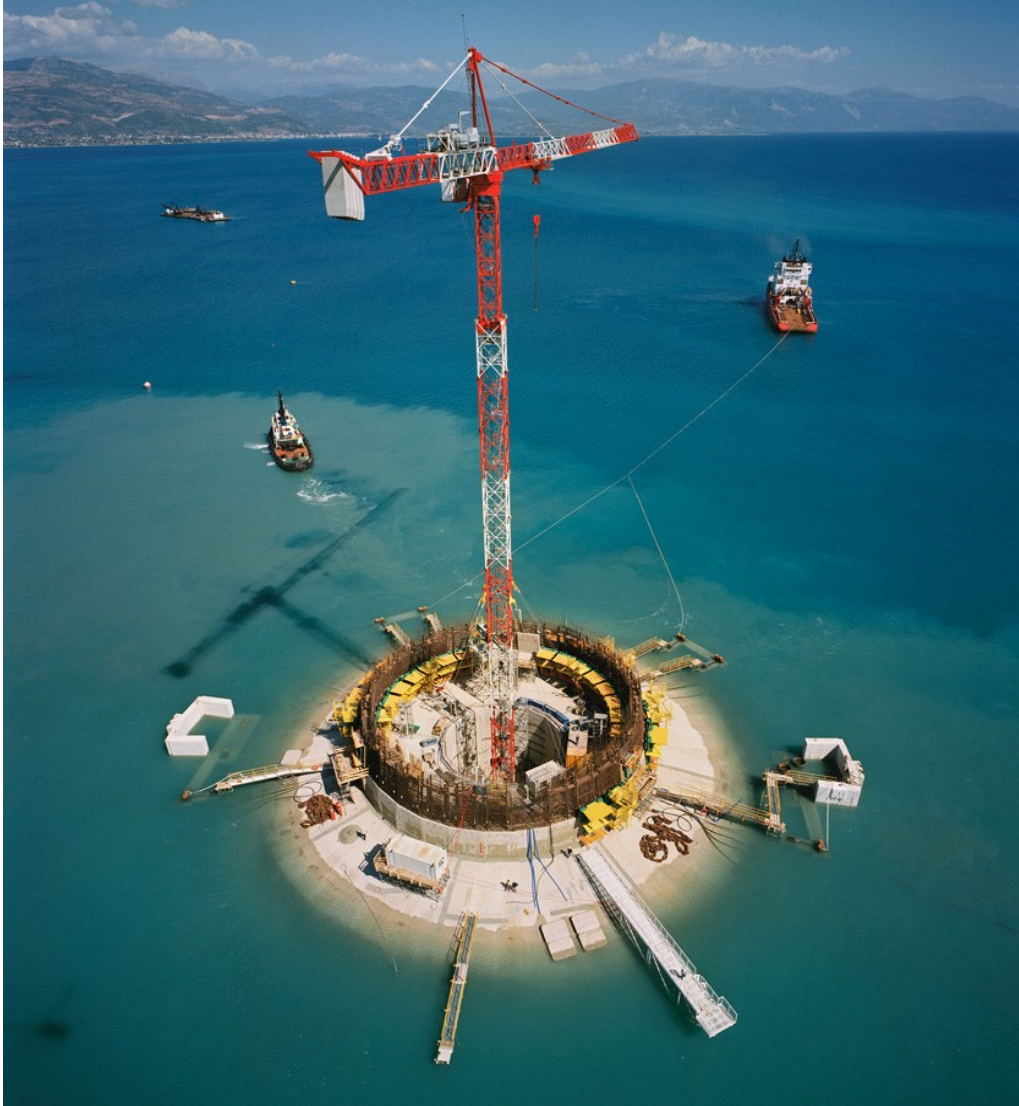
Εικόνα 74 Η ρυμούλκηση του θεμελίου
