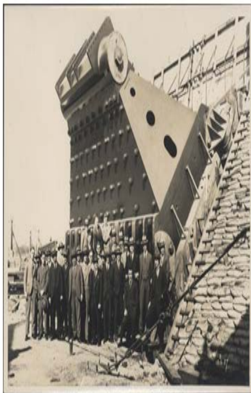
Εικόνα 31 Ο γιγάντιος μεντεσές και τα καλώδια αγκύρωσης
