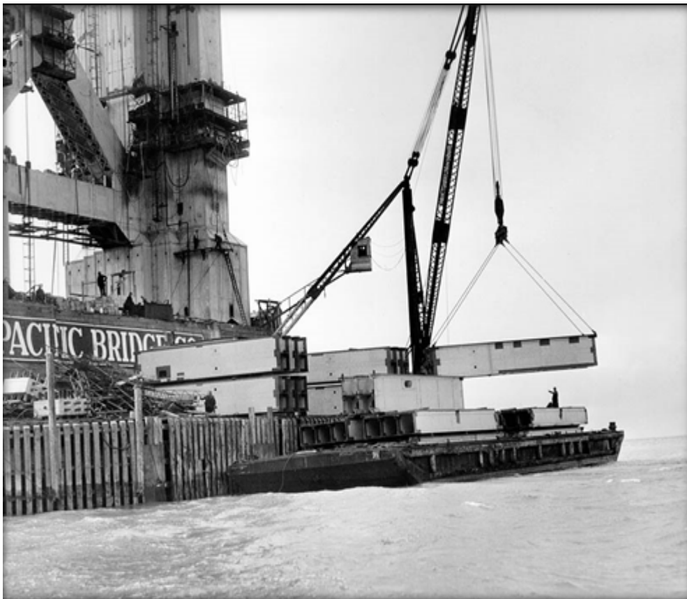
Εικόνα 15 Τα κομμάτια του πύργου φτάνουν στο σημείο με φορηγίδες
