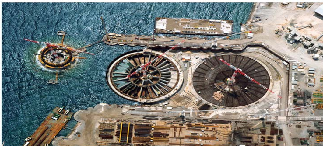
Εικόνα 73 Η κατασκευή των θεμελίων στην ξηρά δεξαμενή
