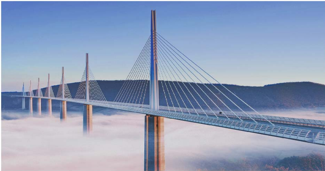
Εικόνα 53 Η γέφυρα σήμερα
