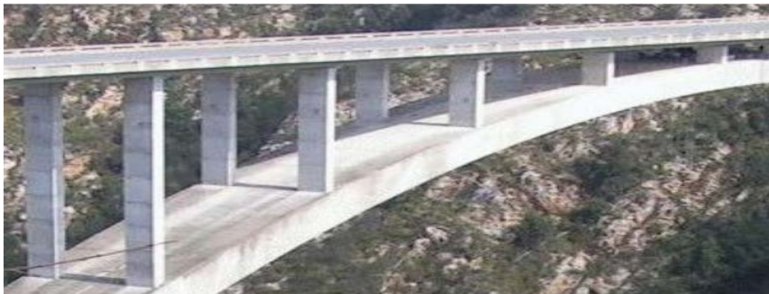
Εικόνα 86 Φωτογραφία με τους στήλους, το τόξο και τη διάταξη του καταστρώματος
