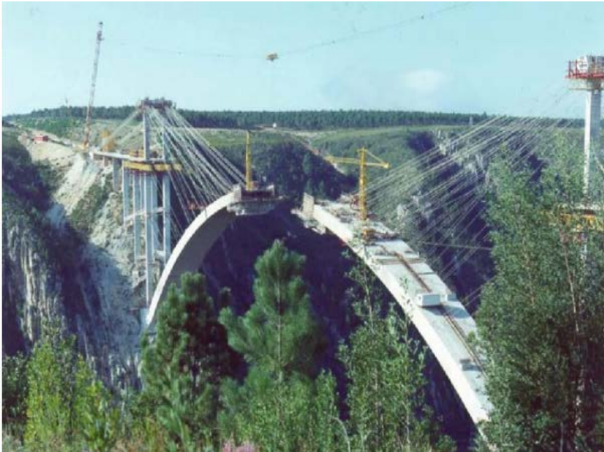
Εικόνα 87 Η κατασκευή της αψίδας
