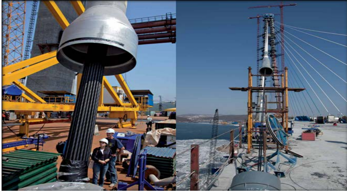
Εικόνα 51 Η τοποθέτηση των καλωδίων
