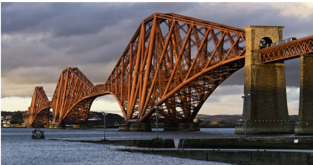
Εικόνα 59 Η γέφυρα σήμερα
