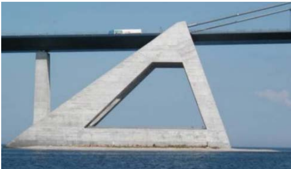
Εικόνα 84 Μορφή του βάρου μας δείχνει πώς οι δυνάμεις από τα καλώδια μεταφέρονται στο πίσω μέρος του.
