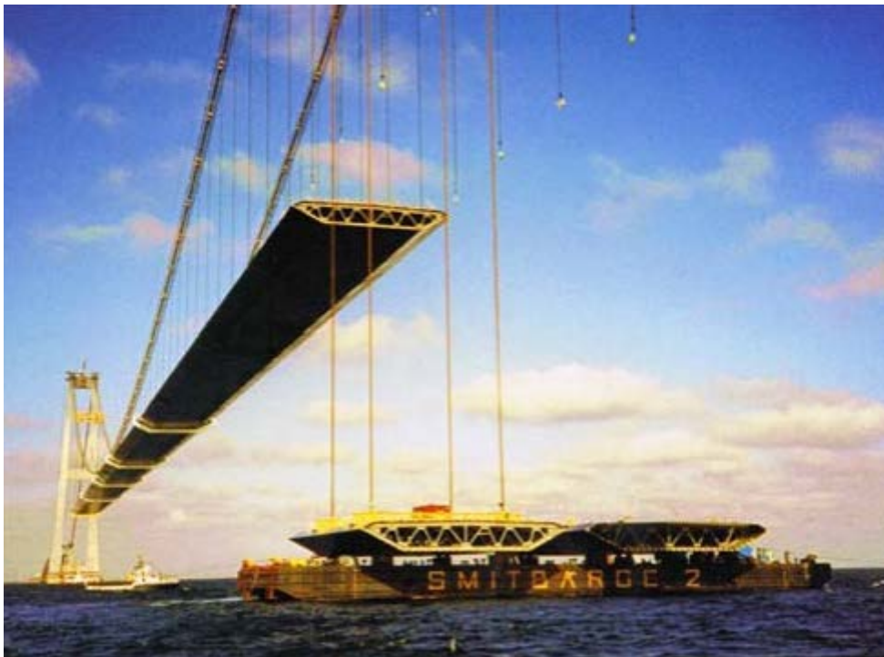
Εικόνα 85 Η τοποθέτηση των πάνελ του καταστρώματος από την φορηγίδα
