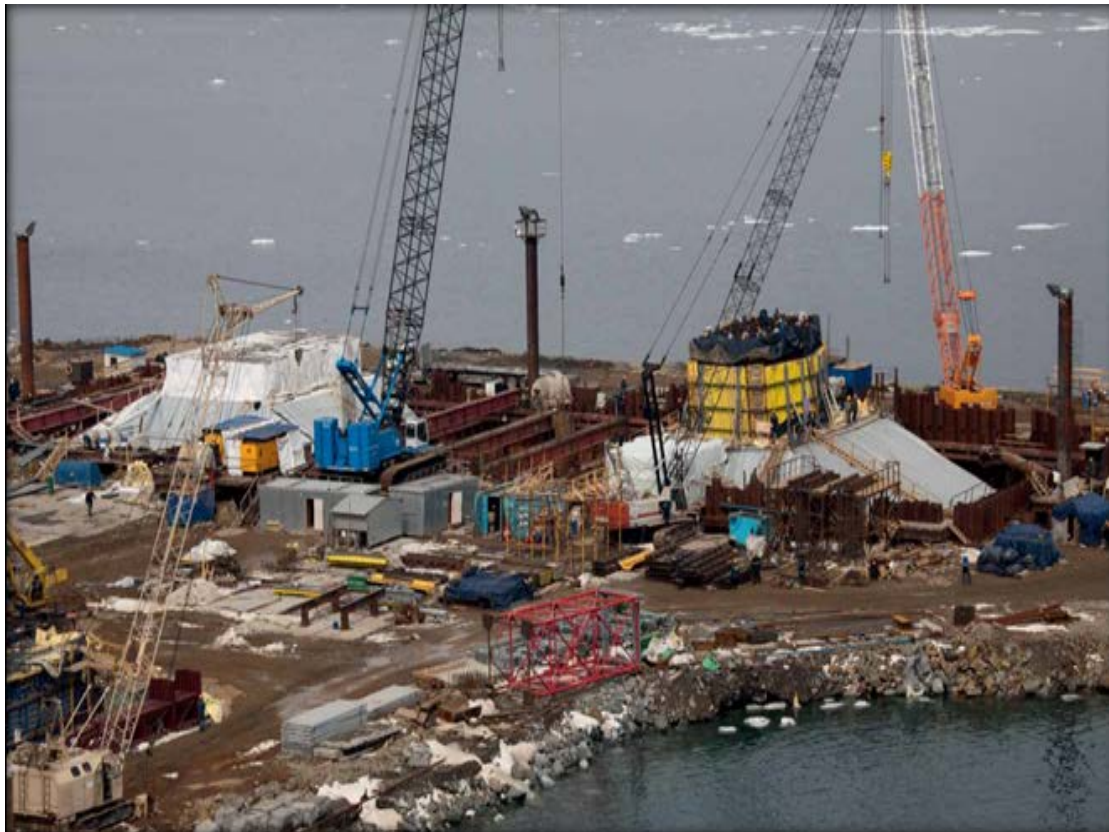
Εικόνα 45 Η κατασκευή των πεδίων
