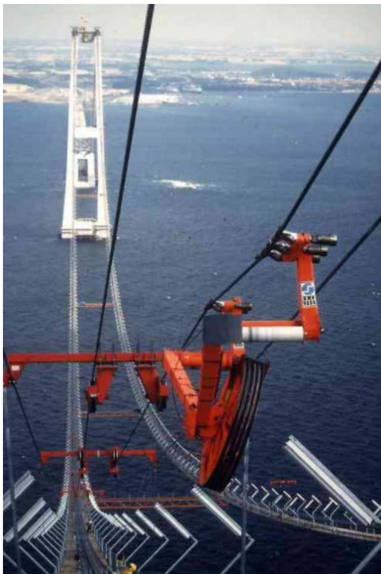
Εικόνα 86 Η τοποθέτηση των κύριων καλωδίων
