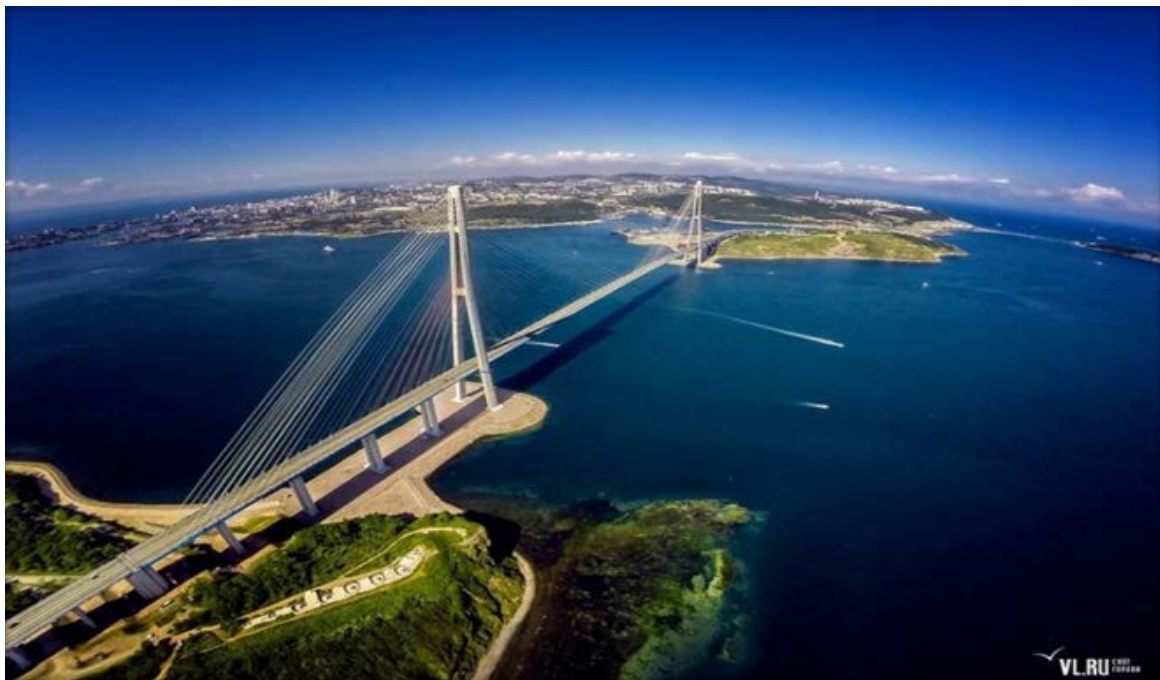
Εικόνα 35 Η γέφυρα σήμερα
