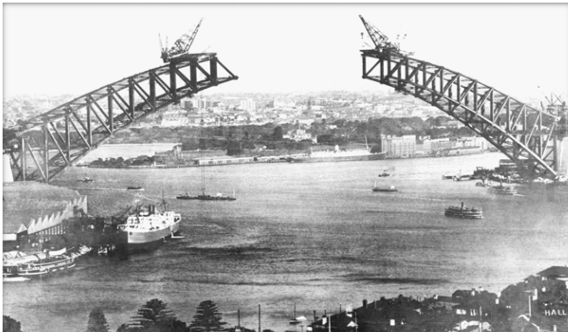
Εικόνα 32 Η κατασκευή της αψίδας
