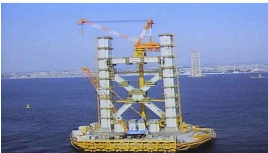
Εικόνα 5 Η κατασκευή των πύργων
