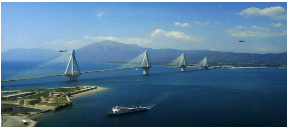
Εικόνα 66 Η γέφυρα σήμερα
