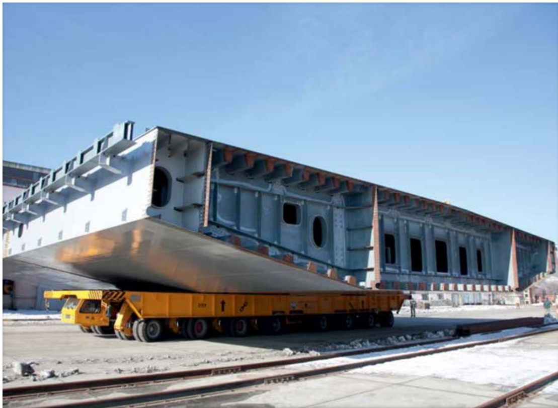
Εικόνα 49 Πάνελ έτοιμο για τοποθέτηση
