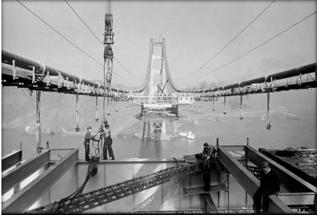
Εικόνες 19,20 Η τοποθέτηση του καταστρώματος
