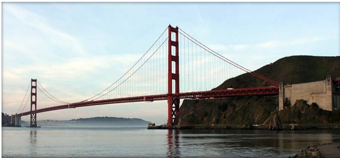
Εικόνα 10 Η γέφυρα σήμερα
