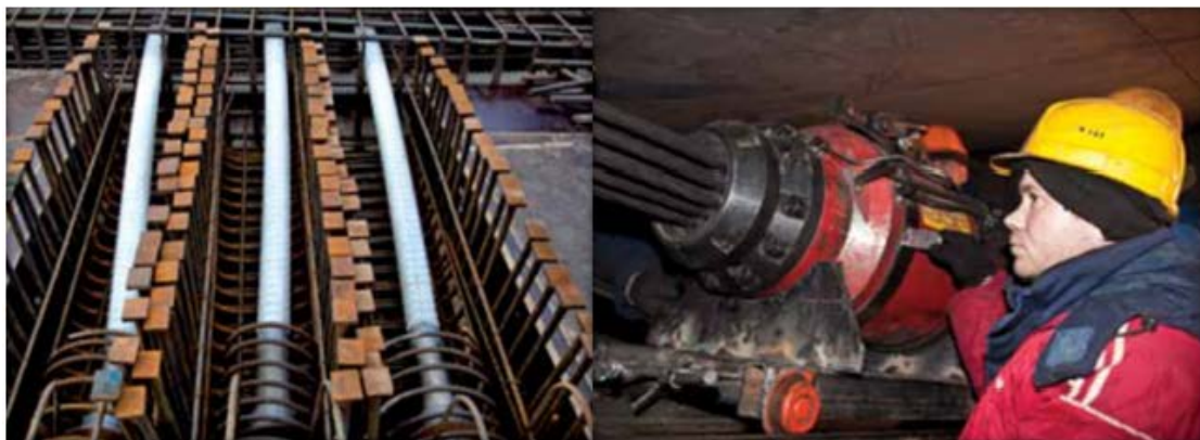
Εικόνα 47 Η τοποθέτηση της προέντασης και ο ειδικός γρύλος
