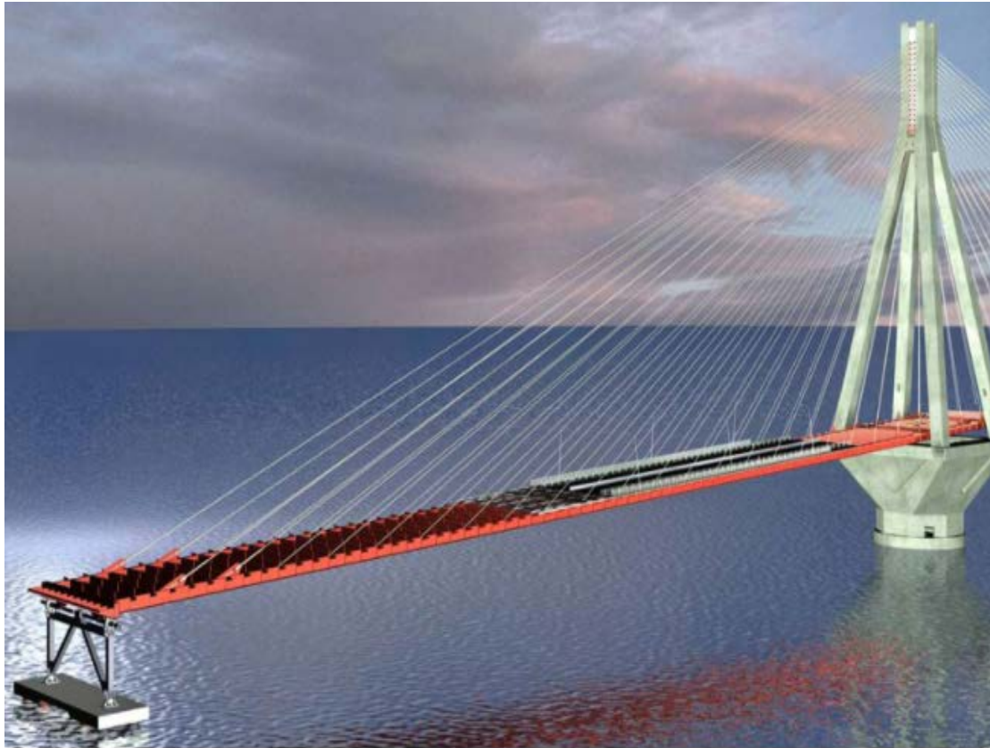
Εικόνα 71 Η σύνδεση του καταστρώματος με το μεταλλικό περιστρεφόμενο ακρόβαθρο
