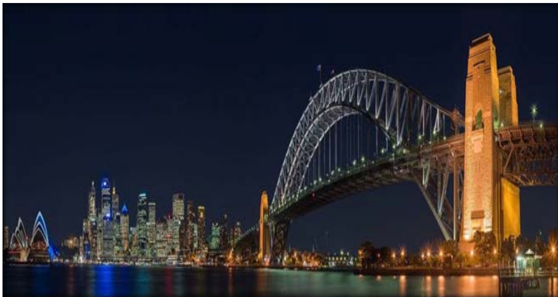
Εικόνα 29 Η γέφυρα σήμερα
