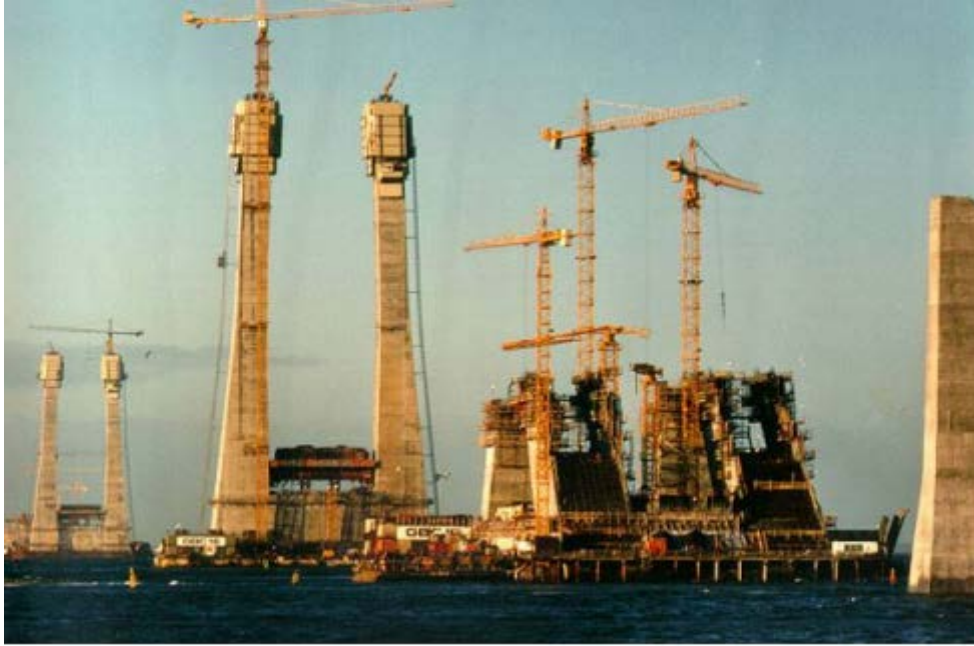
Εικόνα 83 Η κατασκευή των πυλώνων
