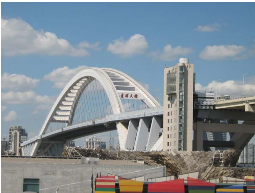
Εικόνες 21 Η γέφυρα σήμερα
