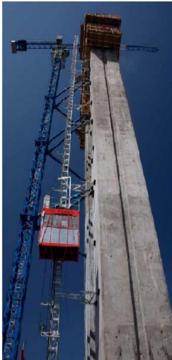
Εικόνες 39.40 Η κατασκευή των βάθρων
