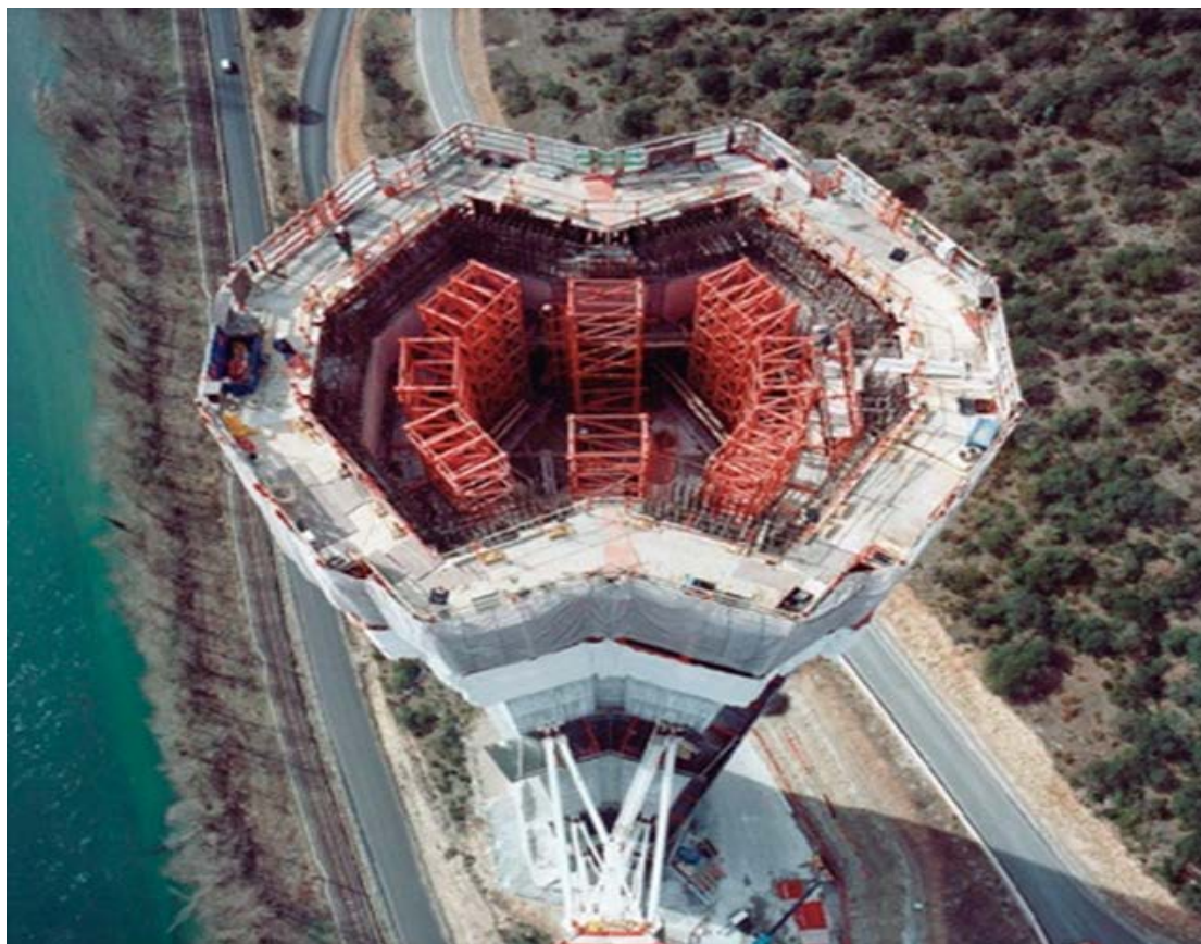
Εικόνα 53 Η κατασκευή των βάθρων
