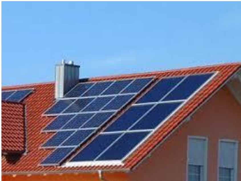
Εικόνα 1.4.1 – Φωτοβολταϊκά σε στέγες και σκεπές.
