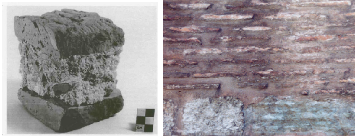
Εικ. 1.14: Δείγμα οπτοπλίνθων - κονιάματος και τοιχοδομή από την Αγία Σοφία.
