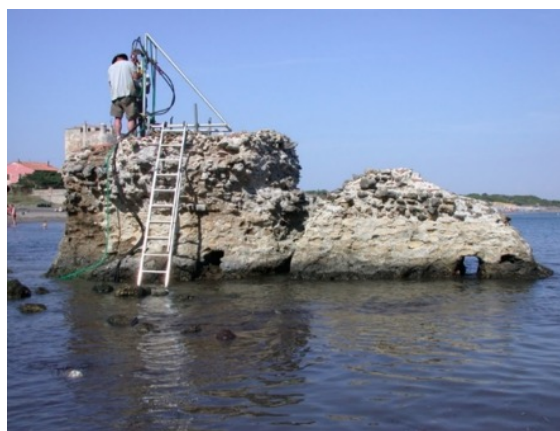
Εικ. 1.10: Υποθαλάσσιος ξυλότυπος, κατασκευασμένος in situ στο βυθό, σύμφωνα με περιγραφή του Βιτρούβιου (De arch. 5.12.3) (C. J. Brandon).
