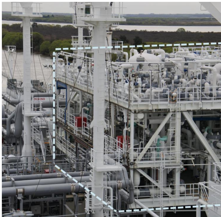
Εικόνα 85: Μονάδα επαναεριοποίησης FSRU (LEIF HÖEGH & CO, 2020, p. 15)
