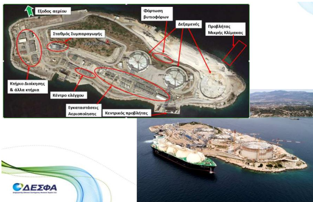
Εικόνα 59: Εγκατάσταση θερματικού σταθμού Ρεβυθούσας (I Chomatas-Desfa, 2019, p. 5)
