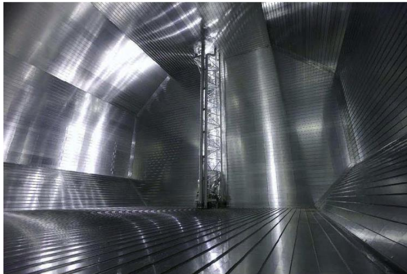
Εικόνα 54: Εσωτερικό δεξαμενής μεμβράνης τύπου GTT N096 πλοίων LNG (S. Mokhatab J. Mak J. Valappil D. Wood, 2014, p. 25)
