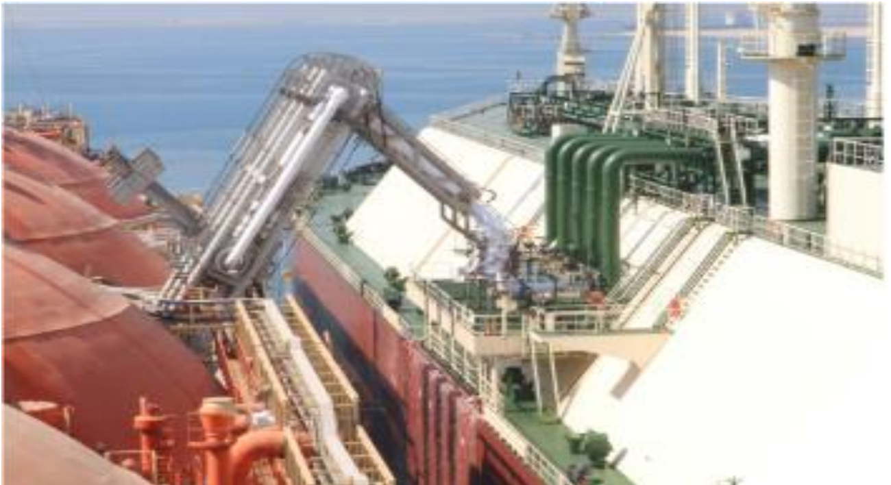
Εικόνα 123: Βραχίονες εκφόρτωσης LNG (TechnipFMC, 2018, p. 11)
