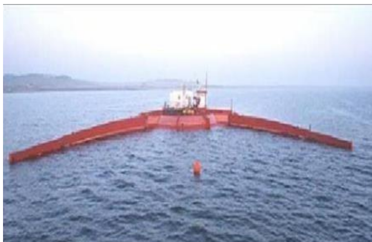
Εικόνα 31. Μετατροπέας WaveDragon. Πηγή: ΜΑΝΑΛΗΣ ΑΝΤΩΝΙΟΣ ΕΥΑΓΓΕΛΟΣ, Κυματική και Ωκεάνια Ενέργεια, σημερινή πραγματικότητα και μελλοντικές προοπτικές, 2012, σελίδα 116.
