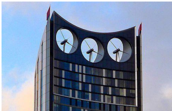
Εικόνα 2. Ανεμογεννήτριες ενσωματωμένες σε κτίριο. Πηγή: Renewable Energy Strategies for Communities in Alberta.
