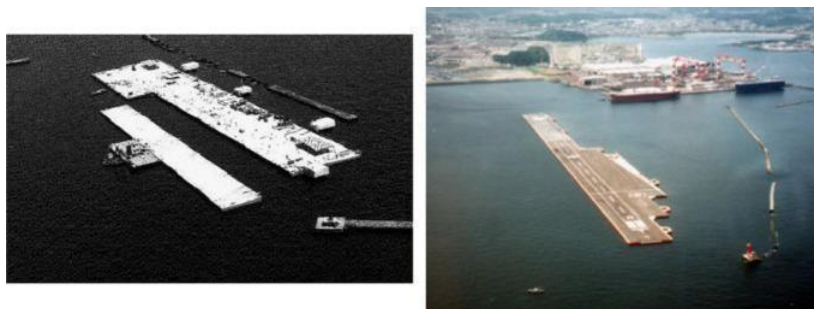
Εικόνα 46. Διαδικασία συναρμολόγησης πλωτής κατασκευής. Πηγή: A review of Very Large Floating Structures (VLFS) for coastal and offshore uses, 2015, σελίδα 5.
