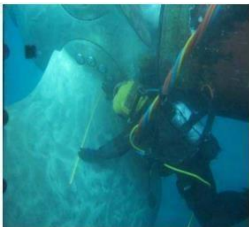
Εικόνα 56. Δύτης κατά τη διάρκεια συντήρησης της κατασκευής. Πηγή: A Study on the Developing concepts of Underwater Construction.
