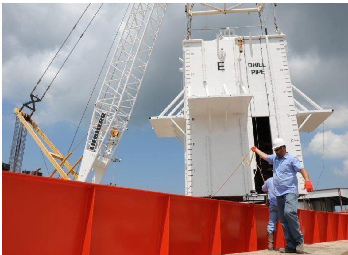
Εικόνα 51. Χαλύβδινο φράγμα πάνω σε κατάστρωμα πλοίου. Πηγή: How are Structures built underwater.
