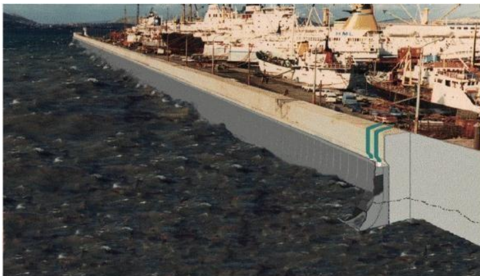
Εικόνα 22. Μετατροπέας κυματικής ενέργειας WECA. Πηγή: ΜΑΝΑΛΗΣ ΑΝΤΩΝΙΟΣ ΕΥΑΓΓΕΛΟΣ, Κυματική και Ωκεάνια Ενέργεια, σημερινή πραγματικότητα και μελλοντικές προοπτικές, 2012
