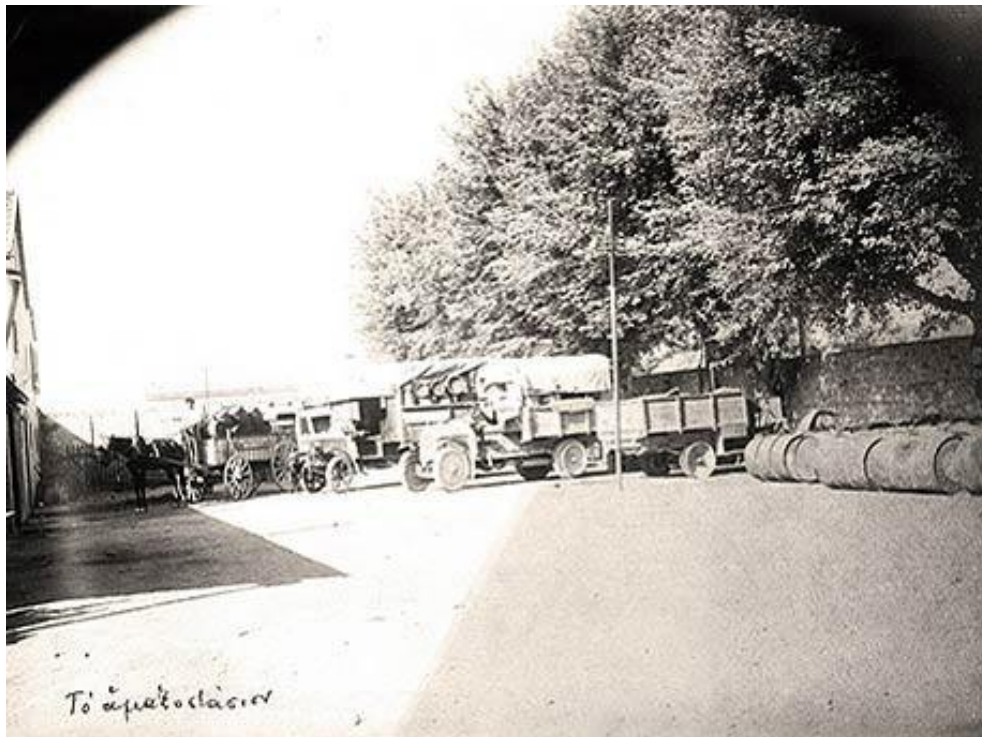
ΕΙΚΟΝΑ 129 ΦΩΤΟΓΡΑΦΙΑ ΤΟΥ ΑΜΑΞΟΣΤΑΣΙΟΥ ΤΗΣ ΖΥΘΟΠΟΙΑΣ ΜΑΜΟΣ ΟΠΟΥ ΣΤΑΘΜΕΥΑΝ ΤΑ ΑΥΤΟΚΙΝΗΤΑ ΓΙΑ ΤΗ ΜΕΤΑΦΟΡΑ ΤΩΝ ΠΡΟΪΟΝΤΩΝ, 1920.
