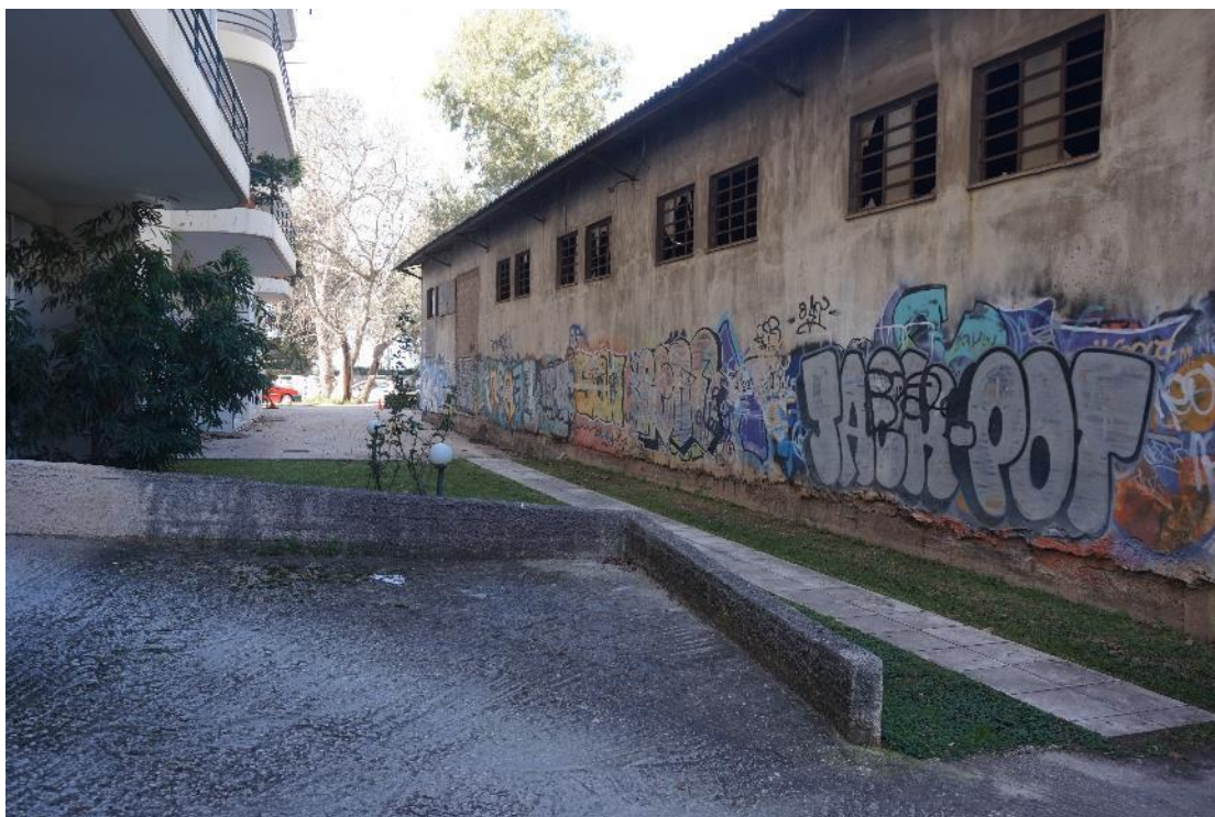
ΕΙΚΟΝΑ 187 ΠΑΛΙΟ ΠΕΤΡΙΝΟ ΚΤΙΡΙΟ, ΑΠΟΜΕΙΝΑΡΙ ΤΟΥ ΒΙΟΜΗΧΑΝΙΚΟΥ ΣΥΓΚΡΟΤΗΜΑΤΟΣ.
