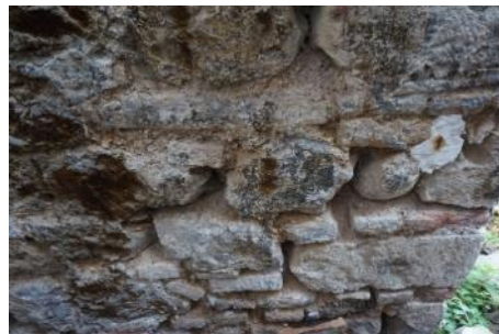
ΕΙΚΟΝΑ 45 ΑΠΩΛΕΙΑ ΤΟΥ ΣΥΝΔΕΤΙΚΟΥ ΚΟΝΙΑΜΑΤΟΣ, ΜΑΥΡΕΣ ΚΡΟΥΣΤΕΣ, ΒΙΟΛΟΓΙΚΗ ΠΡΟΣΒΟΛΗ ΚΑΙ ΠΑΡΟΥΣΙΑ ΑΛΑΤΩΝ.
