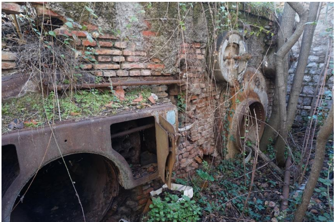
ΕΙΚΟΝΑ 174 ΛΕΠΤΟΜΕΡΕΙΑ ΒΙΟΜΗΧΑΝΙΚΩΝ ΚΑΤΑΛΟΙΠΩΝ ΜΕ ΕΝΤΟΝΗ ΠΑΡΑΣΙΤΙΚΗ ΒΛΑΣΤΗΣΗ.
