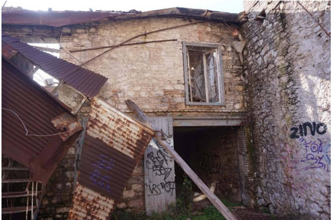
ΕΙΚΟΝΑ 179 ΕΣΩΤΕΡΙΚΑ ΤΟΥ ΒΙΟΜΗΧΑΝΙΚΟΥ ΣΥΓΚΡΟΤΗΜΑΤΟΣ.
