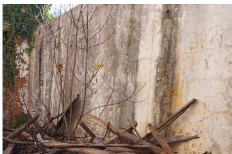
ΕΙΚΟΝΑ 54 ΧΡΩΜΑΤΙΣΜΟΣ ΑΠΟ ΜΕΤΑΛΛΙΚΑ ΟΞΕΙΔΙΑ.
