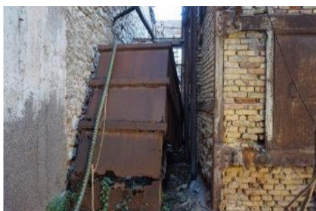
ΕΙΚΟΝΑ 52 ΜΕΤΑΓΕΝΕΣΤΕΡΗ ΣΥΜΠΛΗΡΩΣΗ ΜΕ ΝΕΟΤΕΡΟ ΚΟΝΙΑΜΑ.
