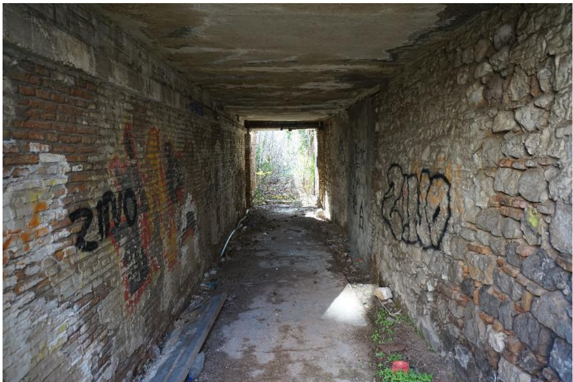
ΕΙΚΟΝΑ 168 ΕΣΩΤΕΡΙΚΗ ΣΤΟΑ ΑΝΑΜΕΣΑ ΤΩΝ ΚΤΙΣΜΑΤΩΝ.
