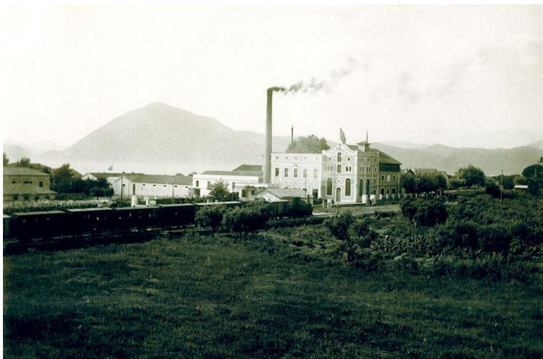
ΕΙΚΟΝΑ 103 ΦΩΤΟΓΡΑΦΙΑ ΤΩΝ ΕΓΚΑΤΑΣΤΑΣΕΩΝ ΤΟΥ ΕΡΓΟΣΤΑΣΙΟΥ ΜΑΜΟΥ ΤΟ 1914.
