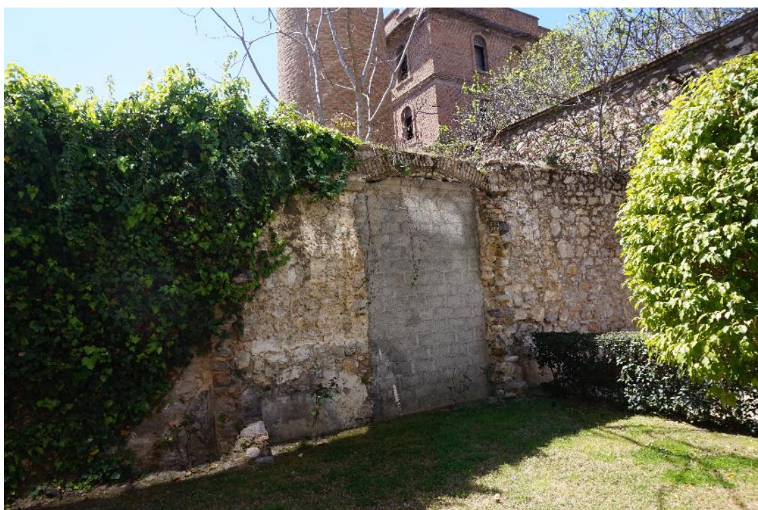
ΕΙΚΟΝΑ 144 ΆΠΟΨΗ ΑΠΟ ΤΑ ΒΟΡΕΙΑ, ΔΙΑΚΡΙΝΕΤΑΙ ΣΦΡΑΓΙΣΜΑ ΑΝΟΙΓΜΑΤΟΣ ΜΕ ΤΣΙΜΕΝΤΟΛΙΘΟΥΣ.
