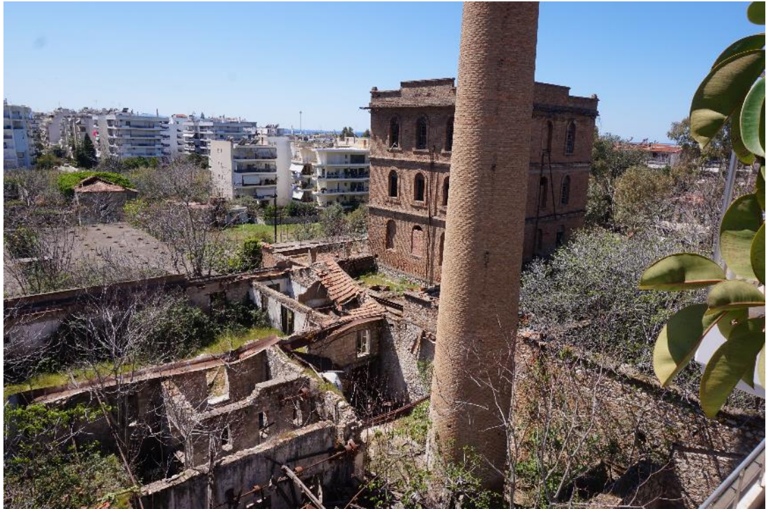
ΕΙΚΟΝΑ 159 ΆΠΟΨΗ ΤΩΝ ΕΡΕΙΠΙΩΝ ΑΠΟ ΨΗΛΑ, ΛΕΠΤΟΜΕΡΕΙΑ ΤΗΣ ΜΕΓΑΛΗΣ ΥΨΙΚΑΜΙΝΟΥ.
