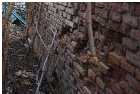
ΕΙΚΟΝΑ 59 ΣΠΑΣΙΜΑΤΑ, ΕΚΔΟΡΕΣ, ΚΑΙ ΑΠΩΛΕΙΕΣ ΥΛΙΚΟΥ.
