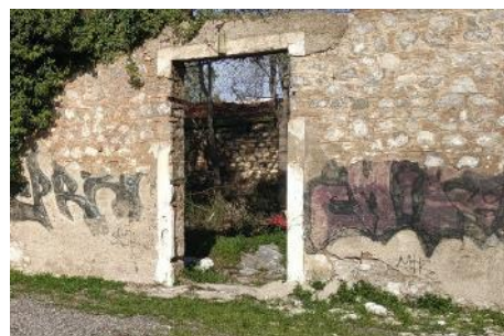
ΕΙΚΟΝΑ 55 ΚΑΤΑΡΡΕΥΣΗ ΤΩΝ ΚΟΝΙΑΜΑΤΩΝ ΚΑΙ ΤΩΝ ΕΠΙΧΡΙΣΜΑΤΩΝ, ΧΡΩΜΑΤΙΚΗ ΑΛΛΟΙΩΣΗ ΜΕ GRAFFITI.
