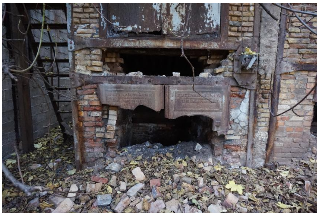
ΕΙΚΟΝΑ 80 ΚΑΤΑΛΟΙΠΑ ΒΙΟΜΗΧΑΝΙΚΟΥ ΕΞΟΠΛΙΣΜΟΥ.
