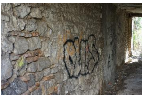
ΕΙΚΟΝΑ 48 ΑΠΩΛΕΙΑ ΤΟΥ ΣΥΝΔΕΤΙΚΟΥ ΚΟΝΙΑΜΑΤΟΣ ΚΑΙ ΧΡΩΜΑΤΙΚΗ ΑΛΛΟΙΩΣΗ ΜΕ GRAFFITI.
