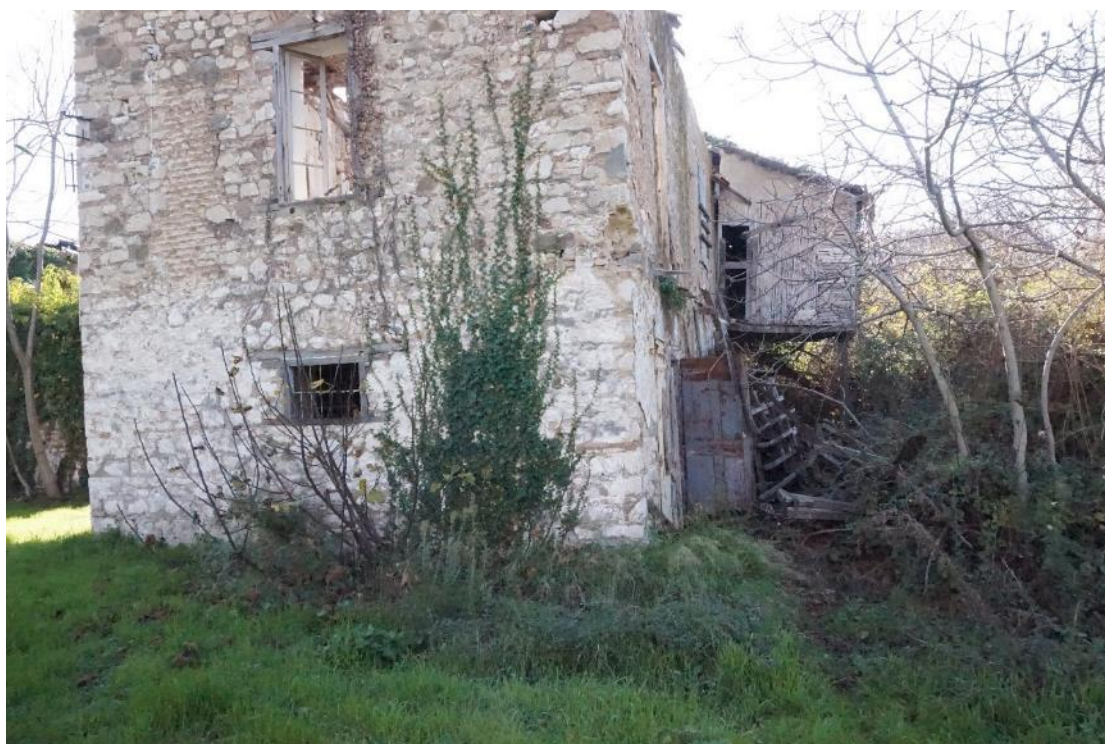
ΕΙΚΟΝΑ 156 ΛΙΘΟΚΤΙΣΤΟ ΚΤΙΡΙΟ ΠΛΗΣΙΟΝ ΤΩΝ ΕΡΕΠΙΩΝ.
