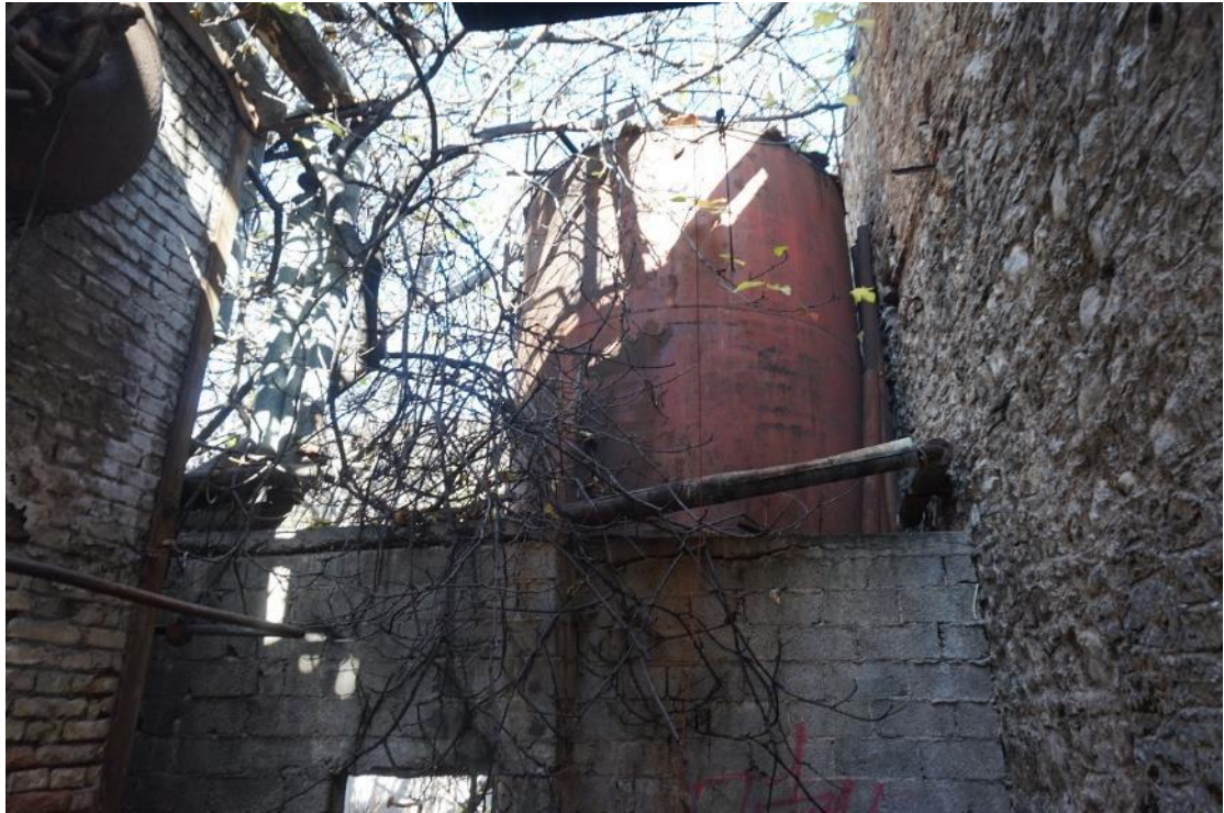
ΕΙΚΟΝΑ 171 ΔΕΞΑΜΕΝΗ ΕΣΩΤΕΡΙΚΑ ΤΩΝ ΚΤΙΣΜΑΤΩΝ.
