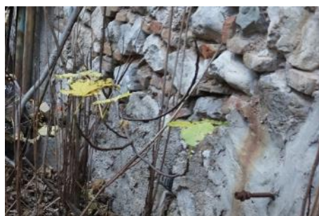
ΕΙΚΟΝΑ 47 ΧΡΩΜΑΤΙΣΜΟΣ ΑΠΟ ΜΕΤΑΛΛΙΚΑ ΟΞΕΙΔΙΑ.
