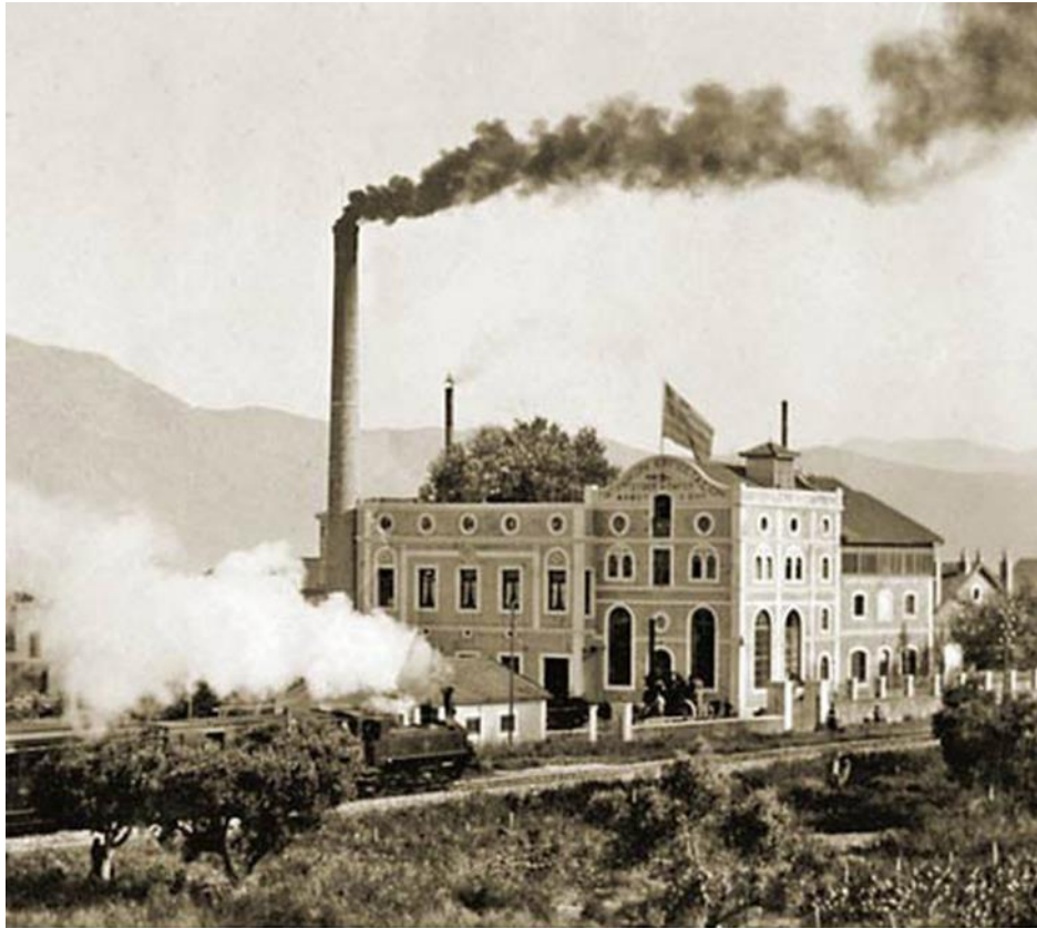
ΕΙΚΟΝΑ 104 ΦΩΤΟΓΡΑΦΙΑ ΤΩΝ ΕΓΚΑΤΑΣΤΑΣΕΩΝ ΤΟΥ ΕΡΓΟΣΤΑΣΙΟΥ ΜΑΜΟΥ ΤΟ 1916.
