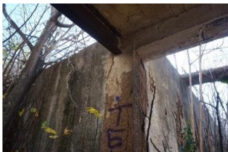
ΕΙΚΟΝΑ 50 ΡΗΓΜΑΤΩΣΕΙΣ ΚΑΙ ΑΠΟΚΟΛΗΣΕΙΣ ΤΟΥ ΕΠΙΧΡΙΣΜΑΤΟΣ.
