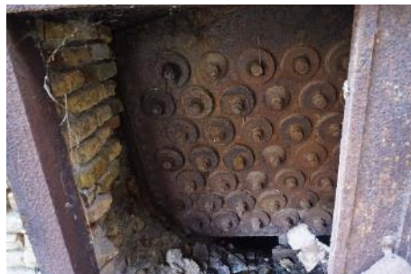
ΕΙΚΟΝΑ 63 ΚΑΦΕ-ΠΟΡΤΟΚΑΛΙ ΠΡΟΪΟΝΤΑ ΔΙΑΒΡΩΣΗΣ, ΧΑΛΑΡΕΣ ΦΟΛΙΔΕΣ ΣΚΩΡΙΑΣ.
