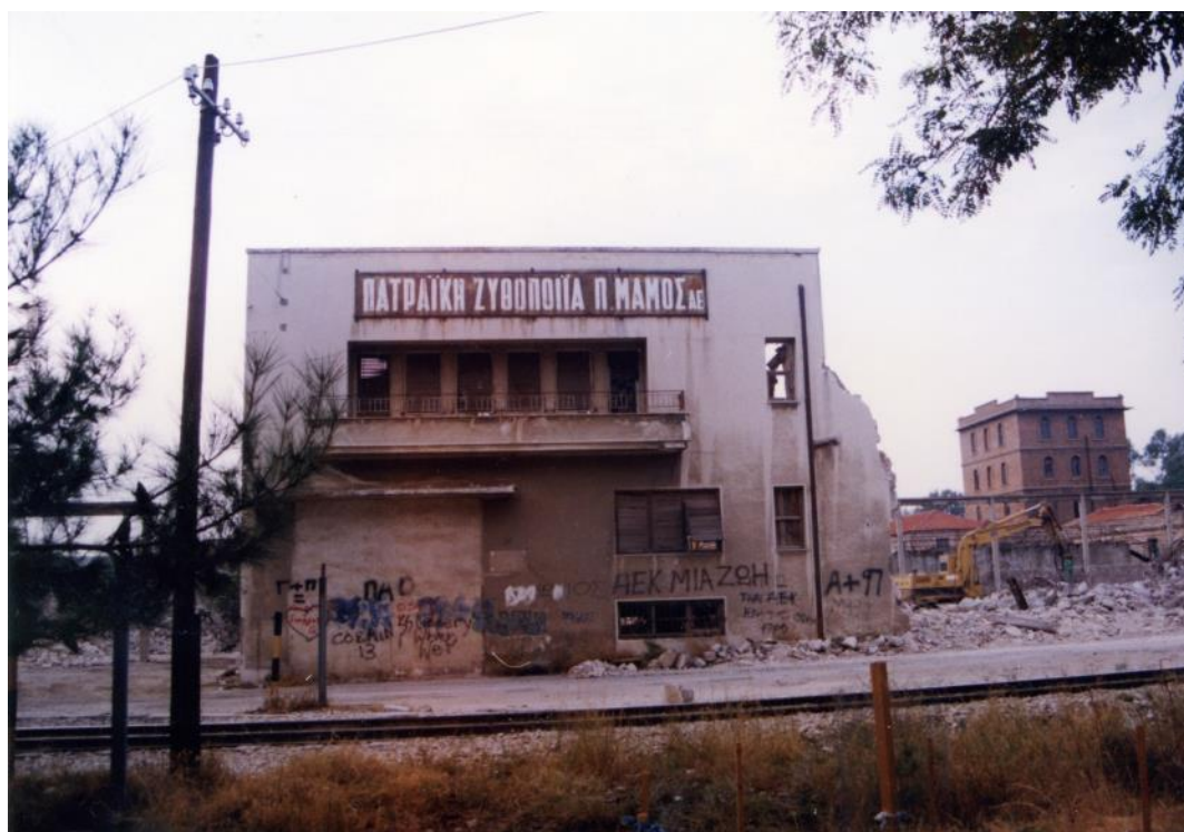
ΕΙΚΟΝΑ 111 ΑΠΟΨΗ ΤΩΝ ΥΠΟ ΚΑΤΕΔΑΦΙΣΗ ΚΤΙΡΙΩΝ ΜΑΜΟΥ ΑΠΟ ΤΗ ΣΙΔΗΡΟΔΡΟΜΙΚΗ ΓΡΑΜΜΗ, 1990.
