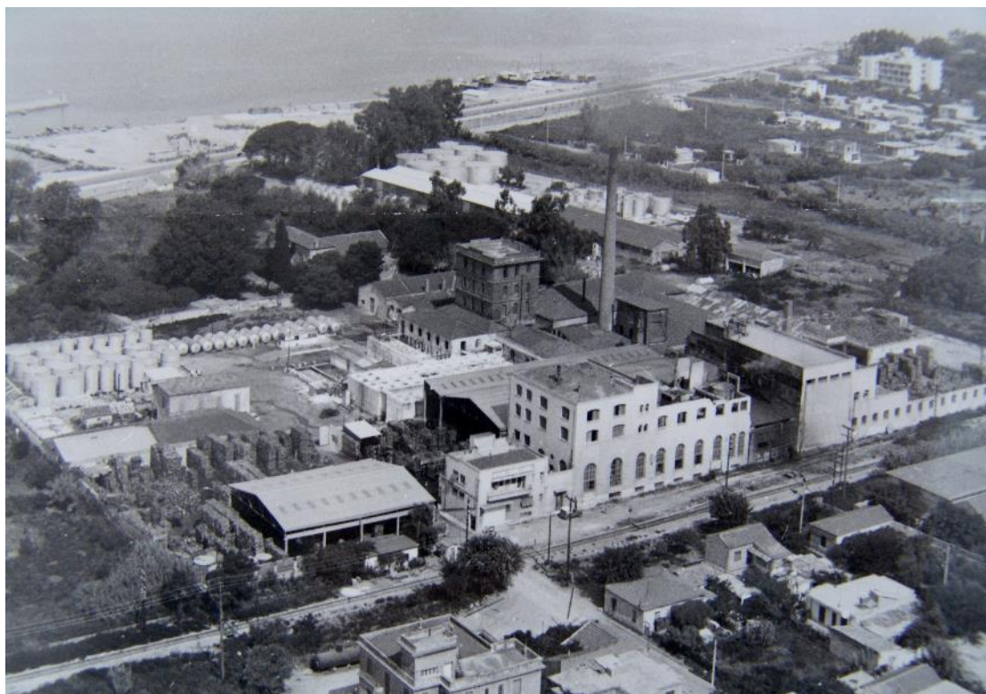
ΕΙΚΟΝΑ 107 ΆΠΟΨΗ ΑΠΟ ΑΕΡΟΣ ΕΓΚΑΤΑΣΤΑΣΕΩΝ ΕΤΑΙΡΙΑΣ ΜΑΜΟΣ ΚΑΙ 5Ε, 1960.
