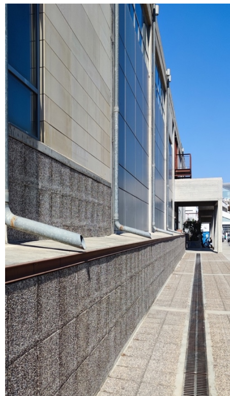
Εικόνα 6.23. Οι υδρορροές που κατεβαίνουν από την οροφή του κτιρίου και οι αγωγοί του νερού που διοχετεύουν το νερό εκτός ΑΣΚΤ. Πηγη: προσωπικό αρχείο
