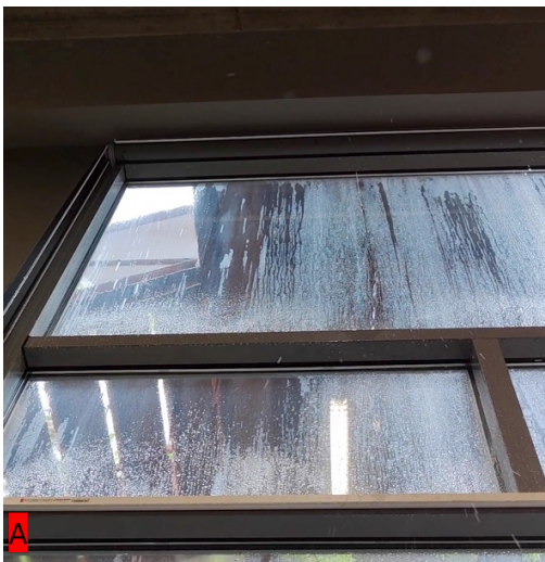
Εικόνα 6.30. Εισροή υδάτων από τζάμια και τοίχους
