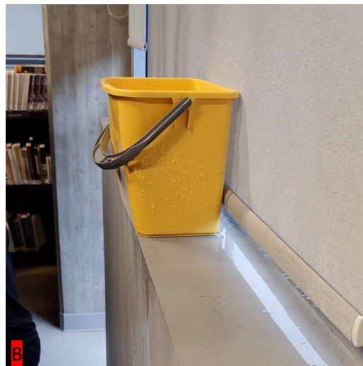
Εικόνα 6.30. Εισροή υδάτων από τζάμια και τοίχους
