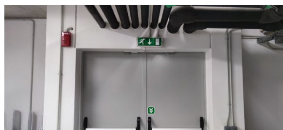
Εικόνα 6.49. Έξοδος κινδύνου αποθήκης 1ου υπογείου, όψη από το εσωτερικό της αποθήκης. Πηγή: προσωπικό αρχείο
