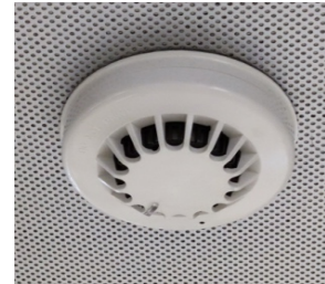
Εικόνα 6.43. Ανιχνευτής καπνού βιβλιοθήκης. Πηγή: προσωπικό αρχείο
