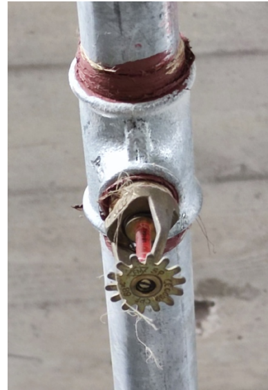
Εικόνα 4.10. Καταιονητήρας νερού (sprinkler) ανεστραμμένου τύπου με προκαθορισμένη θερμοκρασία τους 57°C (Πηγή: Προσωπικό αρχείο)
