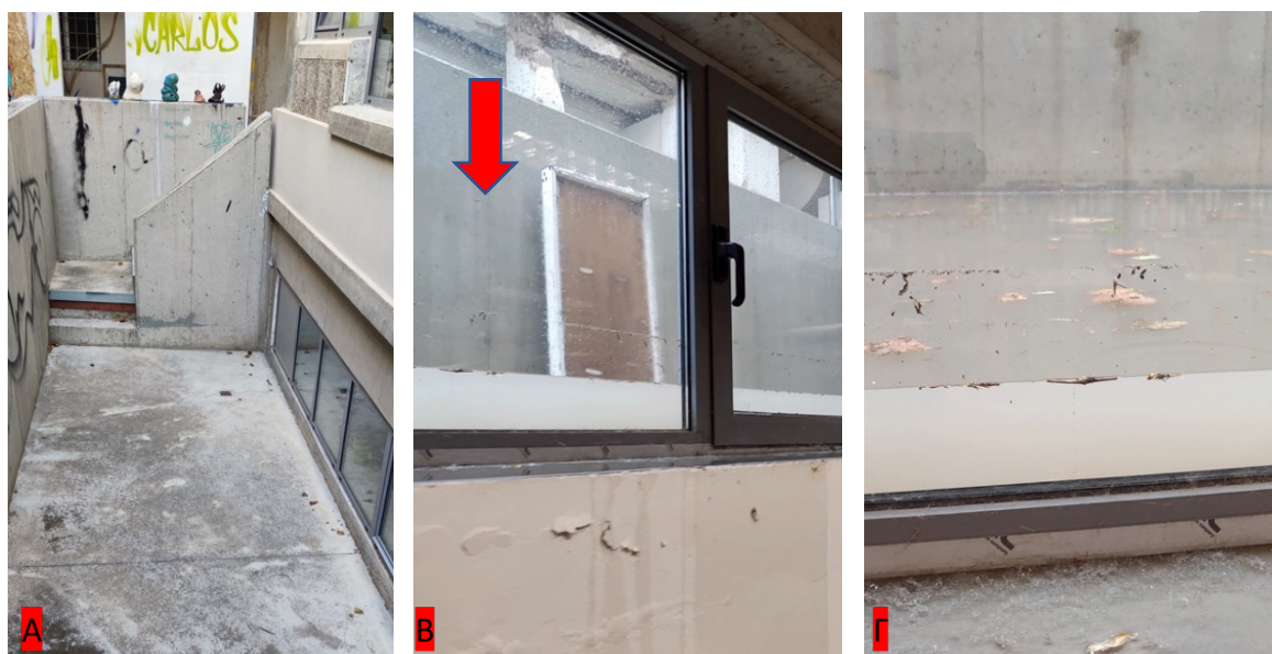
Εικόνα 6.26. Ισόγειος Χώρος από τη βορινή πλευρά του κτιρίου
