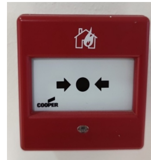
Εικόνα 6.52. Διακόπτης αναγγελίας πυρκαγιάς (συναγερμού) ή εκτάκτου ανάγκης. Πηγή: προσωπικό αρχείο
