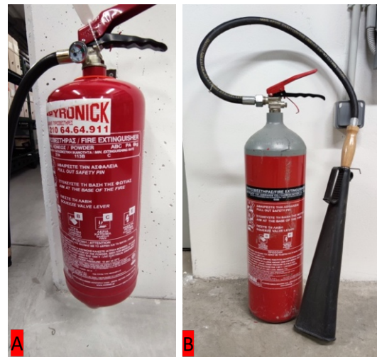
Εικόνα 6.47. (Α) Πυροσβεστήρας ξηράς κόνεως. (Β) Πυροσβεστήρας διοξειδίου άνθρακα.
