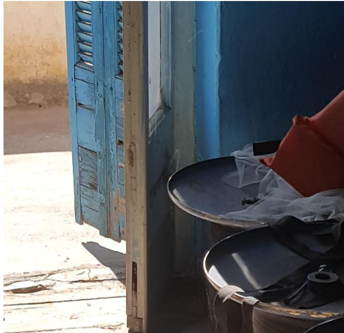
Εικόνα 28: Φθορά σε κούφωμα
