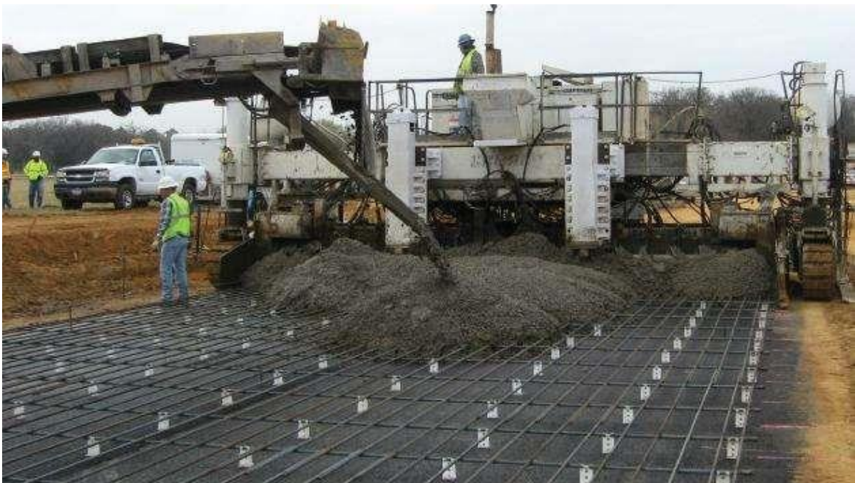
Εικόνα 13. Ιπτάμενη τέφρα στην κατασκευή δρόμων
