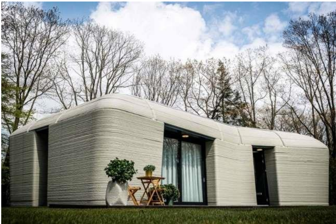
Εικόνα 35. Σπίτι κατασκευασμένο από εκτυπωτή 3D
