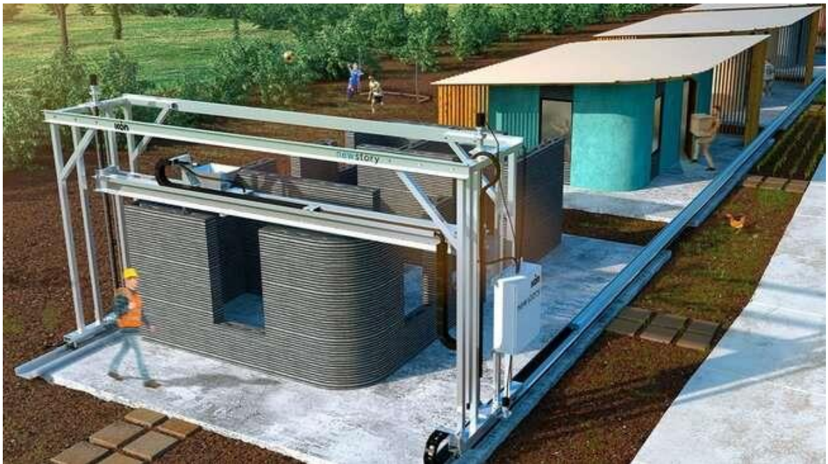
Εικόνα 34. Κατασκευή σπιτιών με εκτυπωτές 3D
